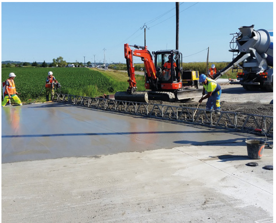
➤ Le giratoire de Pérouges, sur la RD65b, lors du bétonnage. La société Agilis a utilisé une règle vibrante pour assurer la mise en place du béton.
