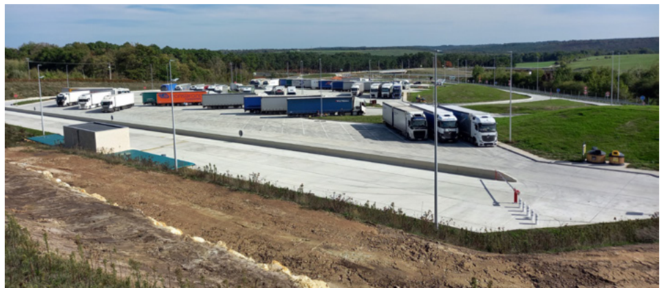
➤ RN 10. Aire de la Grolle. Chaussée composite en BC5g sur GB3. (photo © Gilles PETIT / DIRA)
