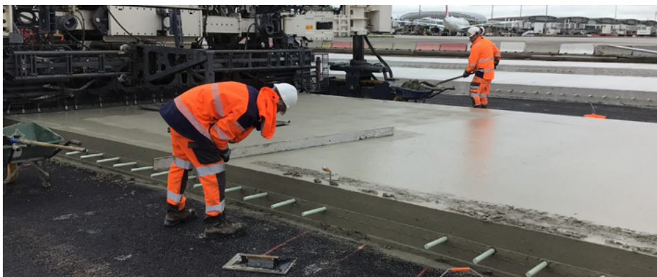
➤ Paris CDG, chaussée composite en BC6g/GB5. Mise en œuvre du BC6g.
