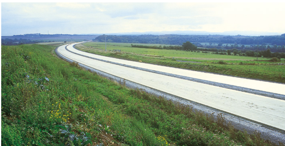
➤ RN4. Déviation de Bebing et d'Imling réalisée en 2001 en chaussée composite BAC sur GB3.
