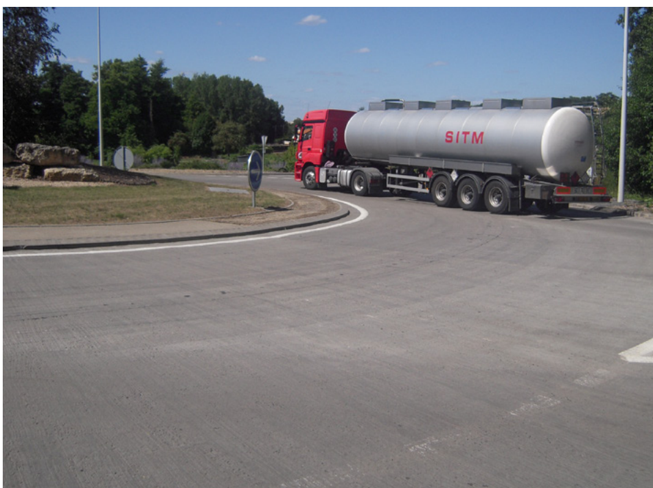
➤ Carrefour giratoire D'airvault (Deux-Sèvres) en BAC sur GB3. Date de réalisation 2001.
