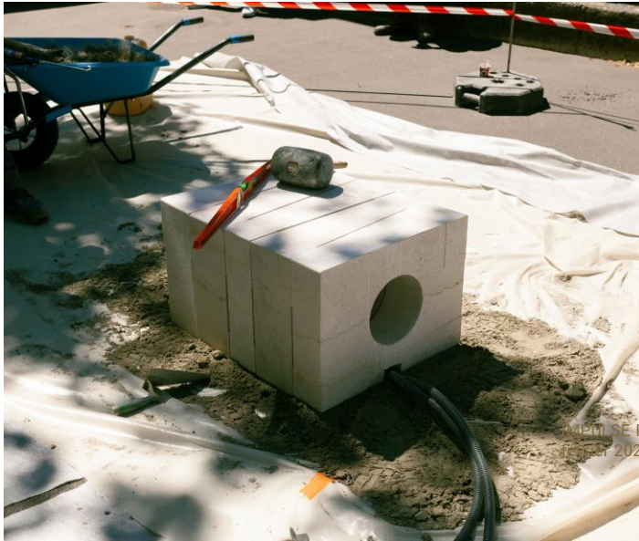
Taille numérique des blocs de pierre marbrière (par l'entreprise Hérés)
