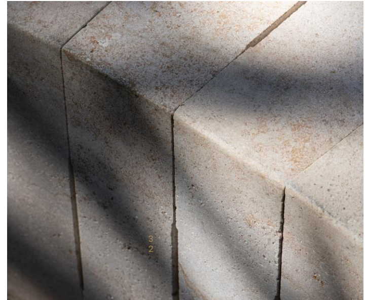
Détail du banc installé
