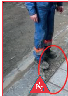
Chaussée déformée
