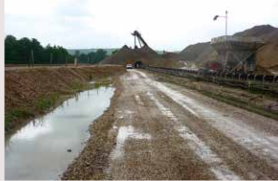
Figure B : les pistes sont entretenues afin d'éviter la création d'ornières. Les points d'eau temporaires sont limités aux fossés de récupération des eaux (à gauche de la piste) afin d'éviter tout risque d'écrasement des pontes lors du passage des engins.
