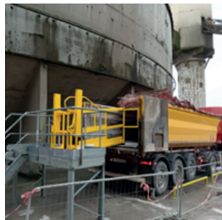
Balayage d'une benne d'un camion de clinker
