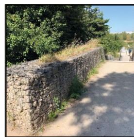
Les murs en gabion
