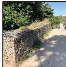
Les murs en gabion
