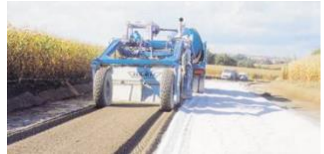
Malaxage en place
