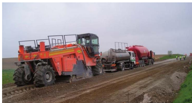
Malaxage et humidification du matériau par injection d'eau sous la cloche
