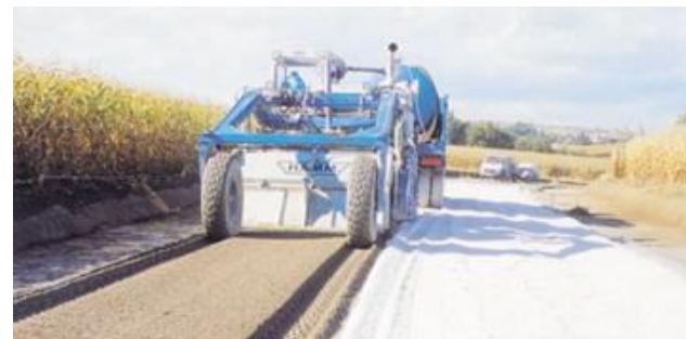
Malaxage en place
