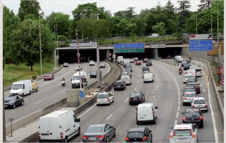
→ Tunnel de la Porte d'Auteuil sur le boulevard périphérique de Paris.
