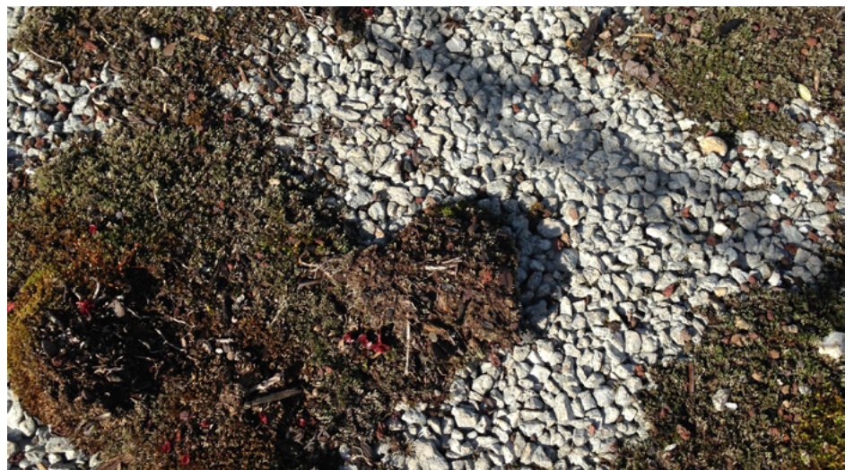
↑ Ci-dessus. Béton drainant comme support à de la mousse et du lichen. ©Maloudebo
