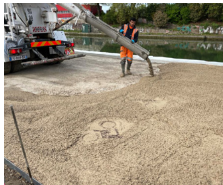
⬆ Le béton est acheminé à pied d'œuvre par camion-toupie et déversé sur la fondation en grave traitée au LHR. (©Sébastien Vinatier/Sols)
