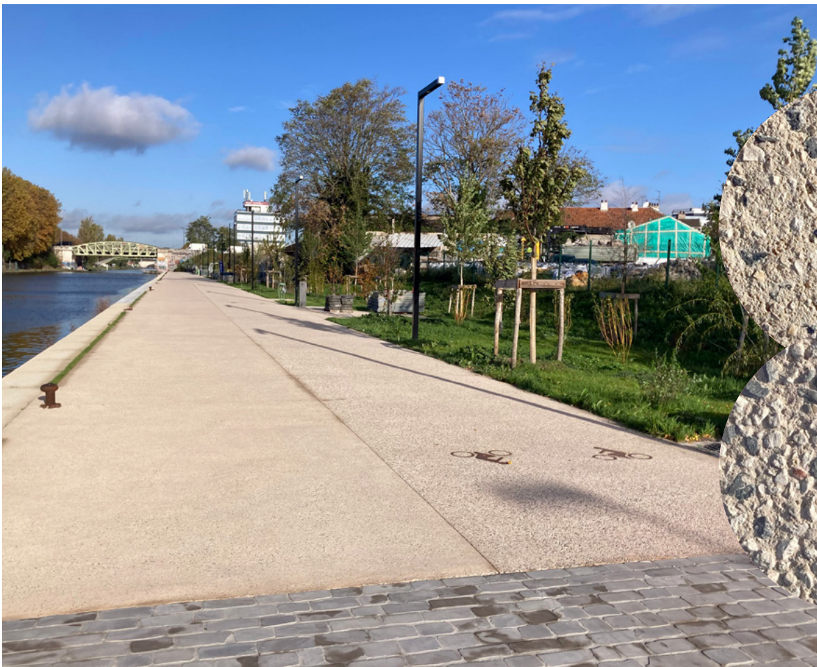
⬆ Vue du revêtement en béton avec un sablage léger pour la voie piétonne et un sablage plus prononcé pour la piste cyclable. (©Joseph Abdo/JA-Consulting)
