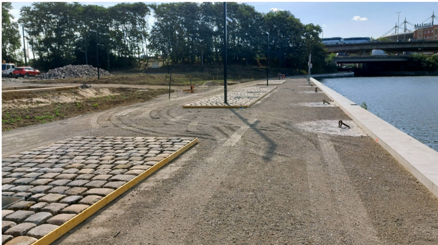
⬆ Vue du chantier avant le coulage du béton, montrant la fondation en grave traitée au LHR, les coffrages posés, les bordures de rive et le pavage. (©Sébastien Vinatier/Sols)
