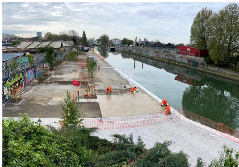
⬆ Le béton est réglé manuellement à l'aide d'une règle en aluminium, tout en respectant les repères altimétriques constitués, d'un côté, par les bordures de rive et, de l'autre côté, par des marques portées sur des piquets « repères ». (©Sébastien Vinatier/Sols)
