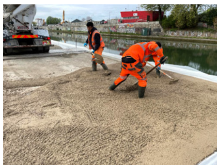
⬆ Le béton est tiré à l'aide d'un râteau. (©Sébastien Vinatier/Sols)
