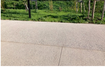
⬆ Sciage du joint de retrait longitudinal sur toute la hauteur du revêtement et des joints de retrait transversaux en quinconce. (©Joseph Abdo/JA-Consulting)
