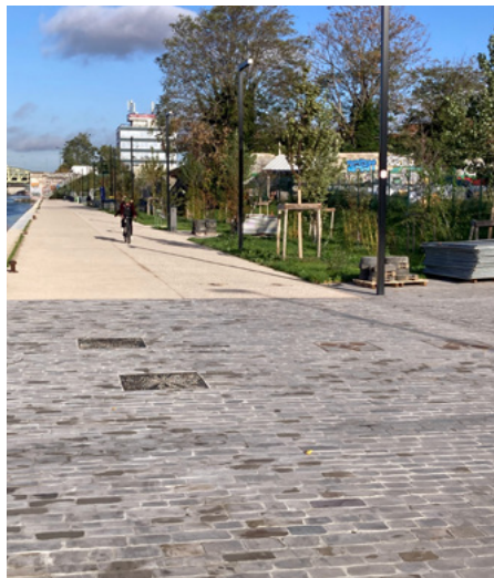
▲ Vue générale de l'aménagement des berges du canal Saint-Denis montrant les différents revêtements réalisés, les espaces verts ainsi que les zones de détente. (©Joseph Abdo/JA-Consulting)
