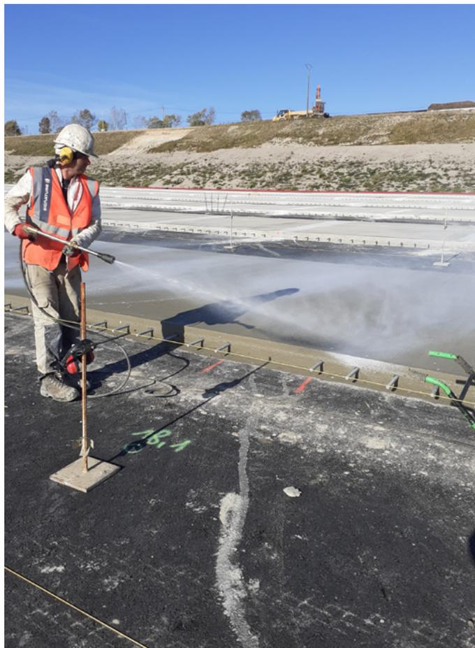
▲ Pulvérisation du produit de cure à la surface du béton.
