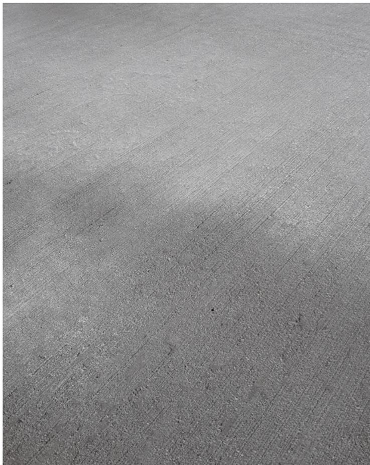
▲ L'adhérence sur le béton est obtenue par balayage fin.
