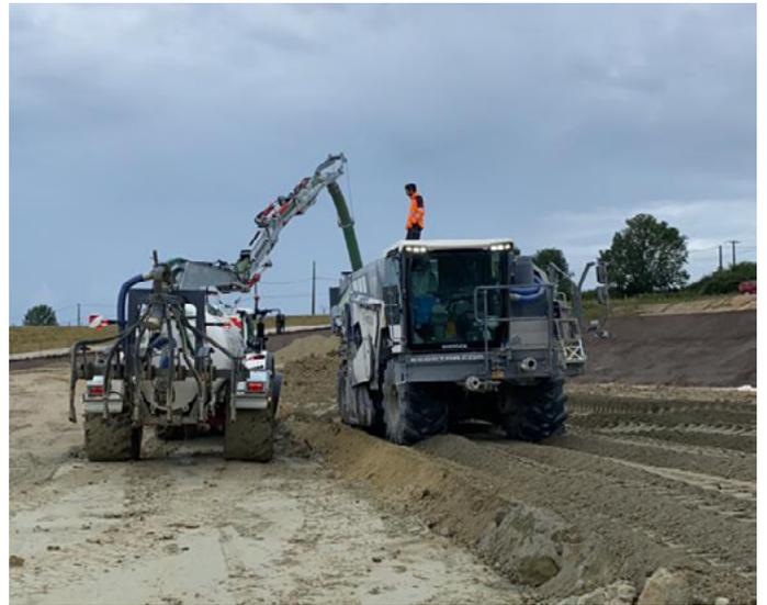
⤴ Un malaxage et les derniers ajustements en teneur en eau jusqu'à l'obtention de la teneur optimale se font en injection d'eau directement dans la cloche du pulvimixeur. (© D. Daguzan\_Ecostab)
