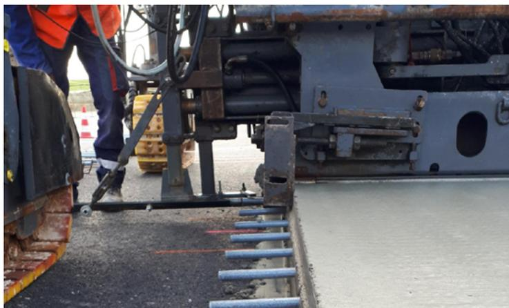
⤴ Insertion des goujons à mi-hauteur sur les deux flancs de la bande en béton.
