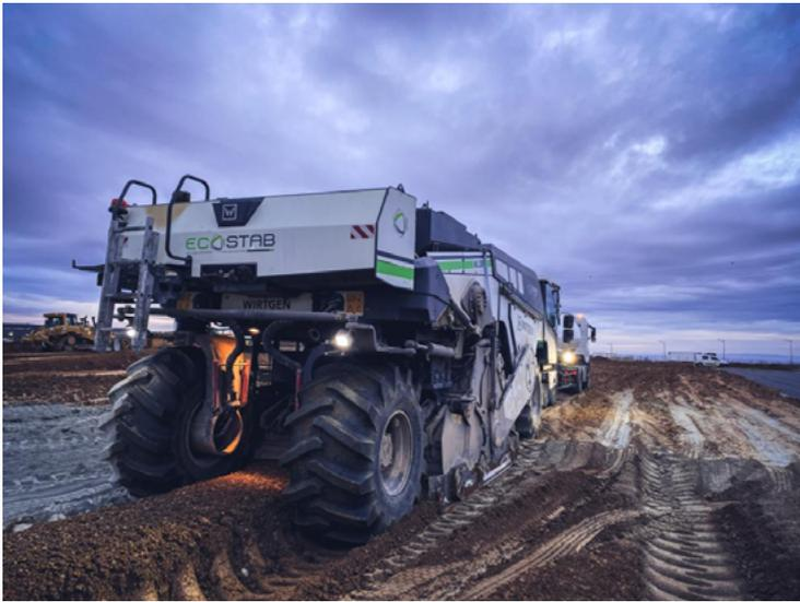
⤴ Malaxage du matériau de la couche de forme avec le liant hydraulique routier Ligex. (© D. Daguzan\_Ecostab)
