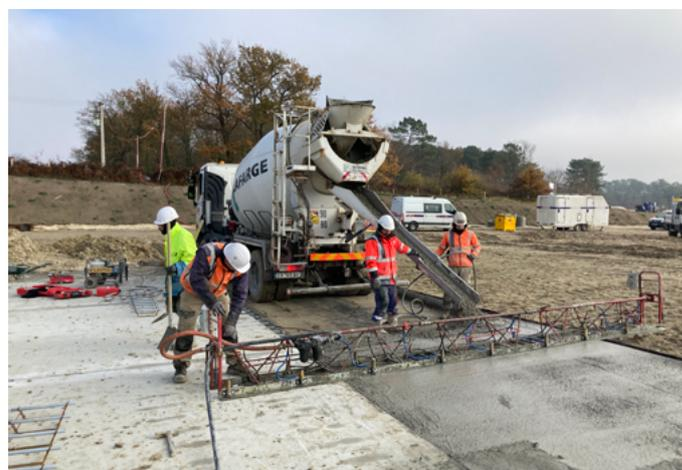
▲ Mise en œuvre manuelle à l'aide d'une aiguille et d'une poutre vibrantes.
