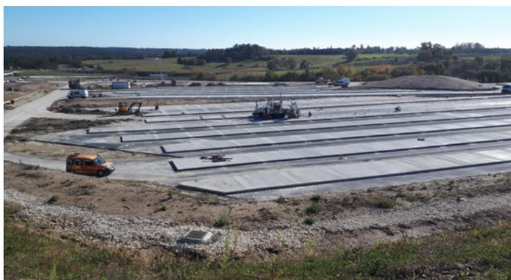
▲ Application de la technique du clavage. Coulage d'une bande sur deux.
