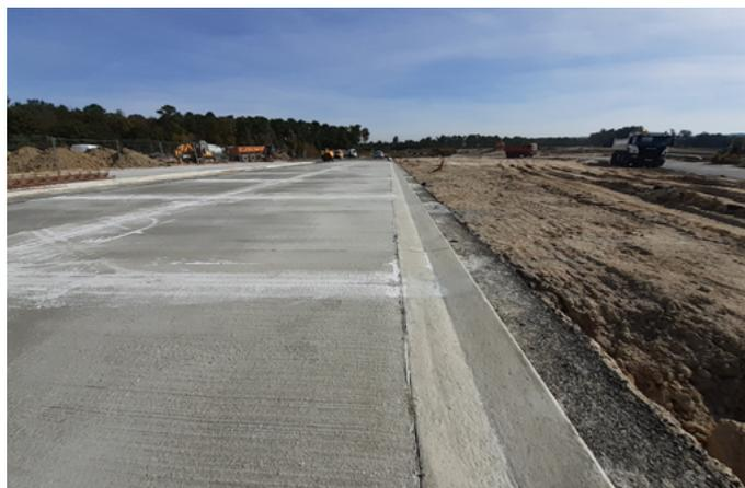
⤴ Les eaux de ruissellement sont recueillies dans des caniveaux en béton.
