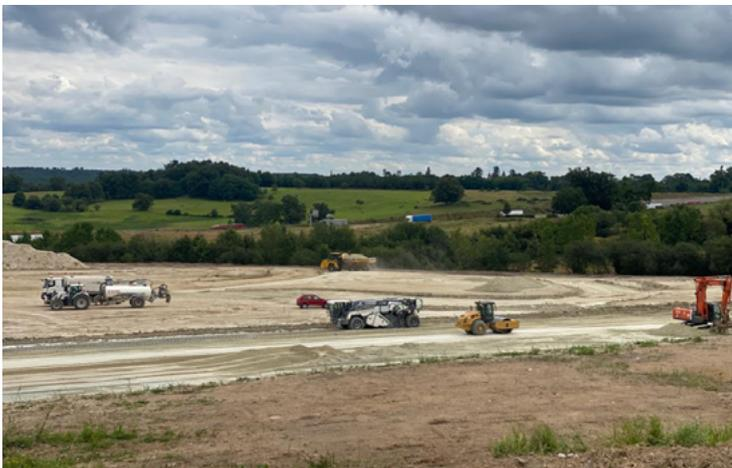
⤴ Vue de l'atelier de traitement du sol en place au liant LIGEX avec, au premier plan, un compacteur à bille lisse en action. (© D. Daguzan\_Ecostab)
