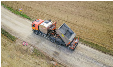
↗ Mise en œuvre de l'enduit de protection.
