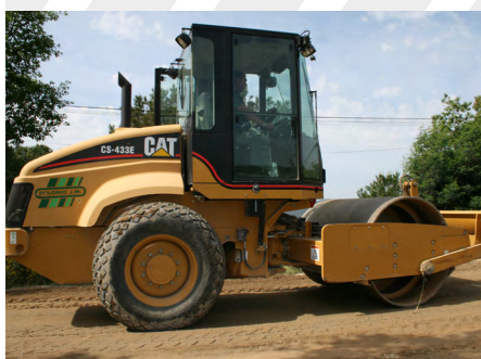
▲ Compactage au rouleau vibrant.
