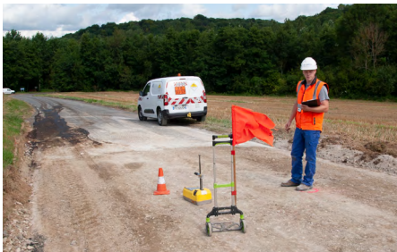
↗ Contrôle de compactage au gamma-densimètre.
