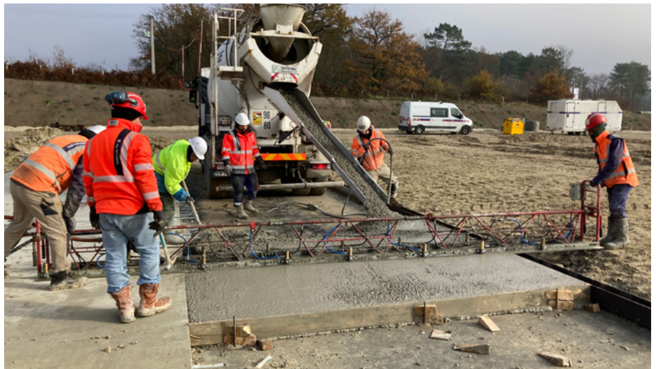
↗ Mise en œuvre du béton à l'aide d'une poutre vibrante.
