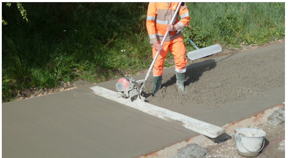
↗ Mise en œuvre du béton manuellement.
