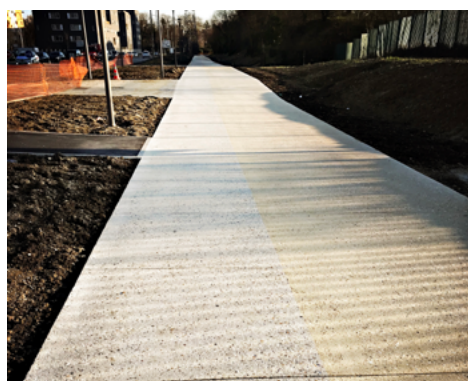
⤴ Le chantier, très linéaire a nécessité la pose de 1 800 ml de coffrage (3 x 600 ml).
