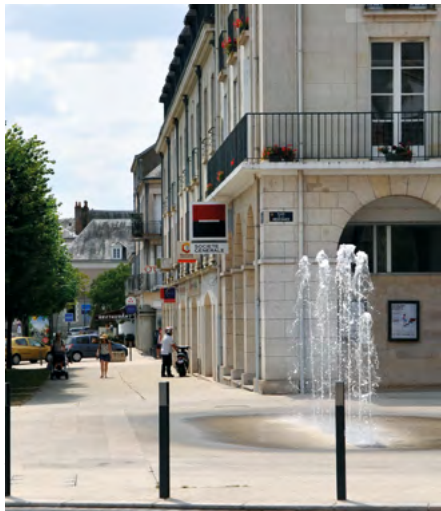
↑ Blois, quai de la Saussaye, sur la rive droite. La rénovation des trottoirs en béton bouchardé s'est accompagnée de travaux d'embellissement. Ici, une fontaine.
