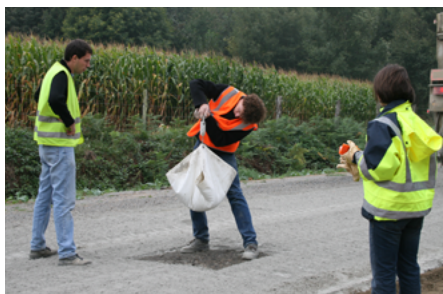
↗ Contrôle de l'épandage à la bâche.
