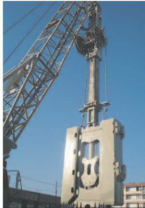
Creusement de la tranchée avec une benne à câble.
