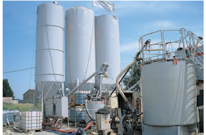
Station de fabrication du coulis de bentonite.
