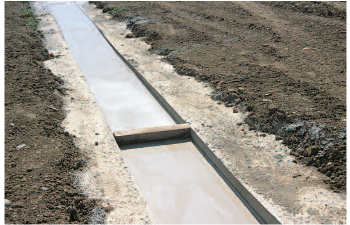
Tranchée remplie de coulis bentonite-ciment.
