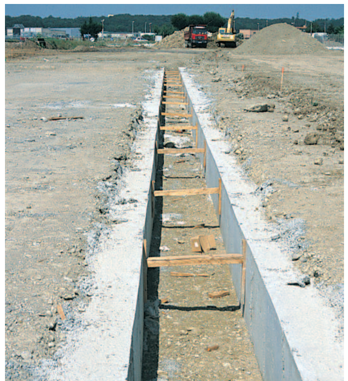
Muret-guide en béton.
