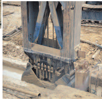
Creusement de la tranchée.
