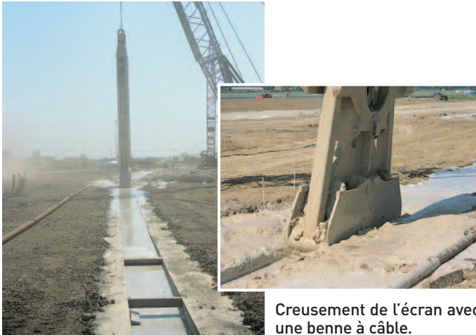
Tranchée remplie de coulis bentonite-ciment.
