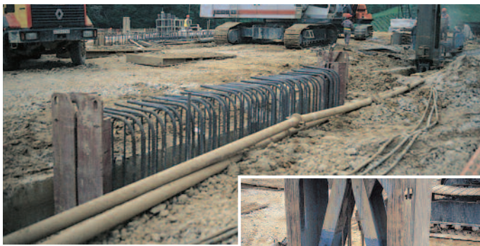
Cages d'armatures mises en place dans la tranchée.
