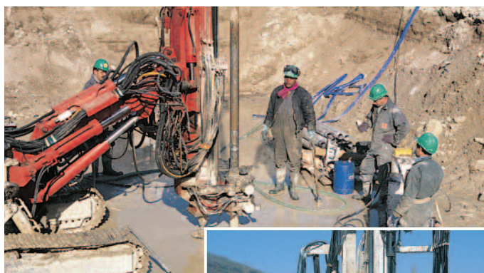
Ateliers de forage de «jet grouting».
