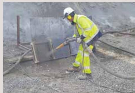
→ Projection dans des caisses ajourées pour éviter de piéger des pertes.
