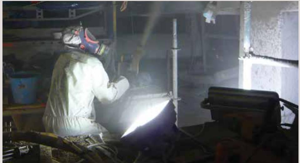
→ Réparation structurelle par projection de béton par voie sèche dans un environnement exigu et encombré.
