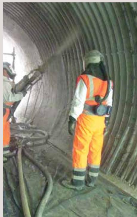
→ Projection de BFUP au cours du chantier expérimental.
