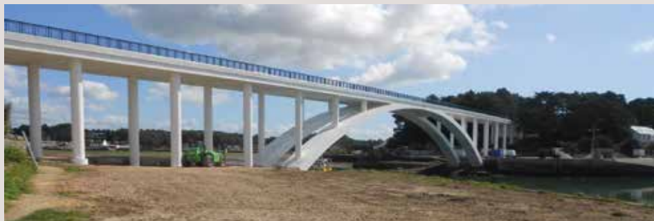
→ Le pont Kerisper à La Trinité-sur-Mer après mise en peinture.
