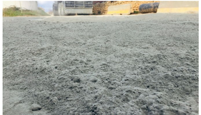
Le liant hydraulique routier après épandage : 190 tonnes de LV-TS 13 de Vicat ont été mises en œuvre à raison de 40 kg/m 2 .
