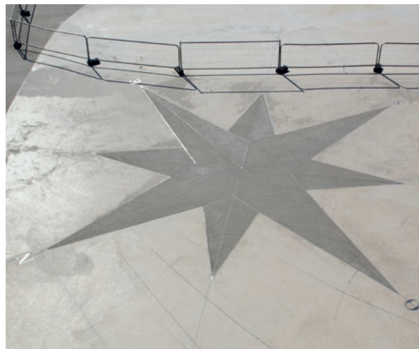
La magnifique rose des vents – dont les branches forment des angles aigus, ce qui rend délicate la mise en œuvre du béton – a été réalisée avec un soin tout particulier.
