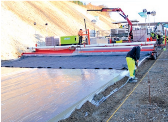
Après la pulvérisation d'un retardateur de surface, le revêtement est recouvert d'un film en polyéthylène.
