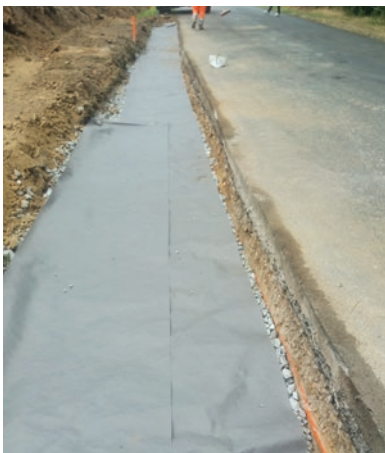
Une base drainante de 20 cm a été constituée en fond de fouille. Elle a été réalisée en matériaux drainants de granulométrie 20/40 et placés dans un géotextile anticontaminant (chaussette). Elle a facilité l'essorage du Macés.
