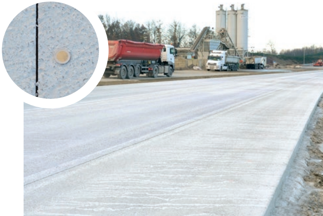
Le BAC recouvert d'un produit de cure. // En médaillon : les amorces de fissuration réalisées dans les vingt-quatre heures après bétonnage.
