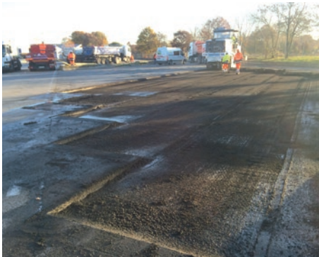
L'ancien enrobé orniéré a été raboté sur une épaisseur de 10 cm. Durée d'intervention pour respecter le planning : une journée.
