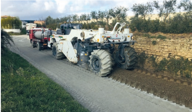
L'atelier de traitement d'Eurovia intervient sur une épaisseur de 32 cm et sur une largeur de 2,50 m par passage.
