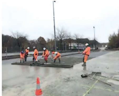
Le béton a été mis en œuvre sur 10 cm d'épaisseur et vibré à l'aide d'aiguilles vibrantes et d'une règle vibrante.
