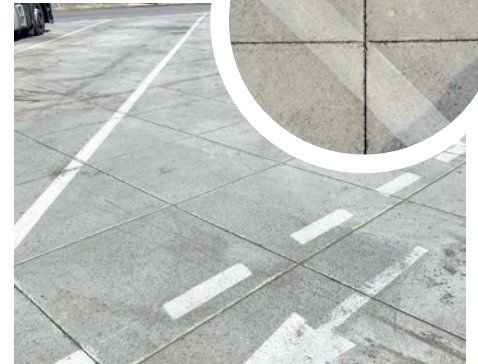
Le calepinage des sciages a été réalisé selon un quadrillage de 1,20 x 1,20 m. Total : 2 100 mètres linéaires.
