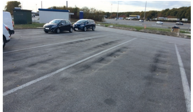
Les aires de stationnement en enrobé bitumineux sont sujettes à des déformations, notamment à un important orniérage et à du « fluage », ce qui impose un entretien répétitif.
