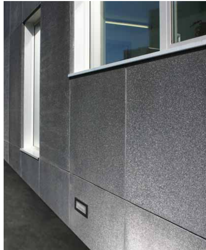
Les microbilles de verre qui réfléchissent la lumière donnent à ce béton un aspect scintillant. L'intensité de la luminosité naturelle associée aux rayons du soleil modifie son aspect.
