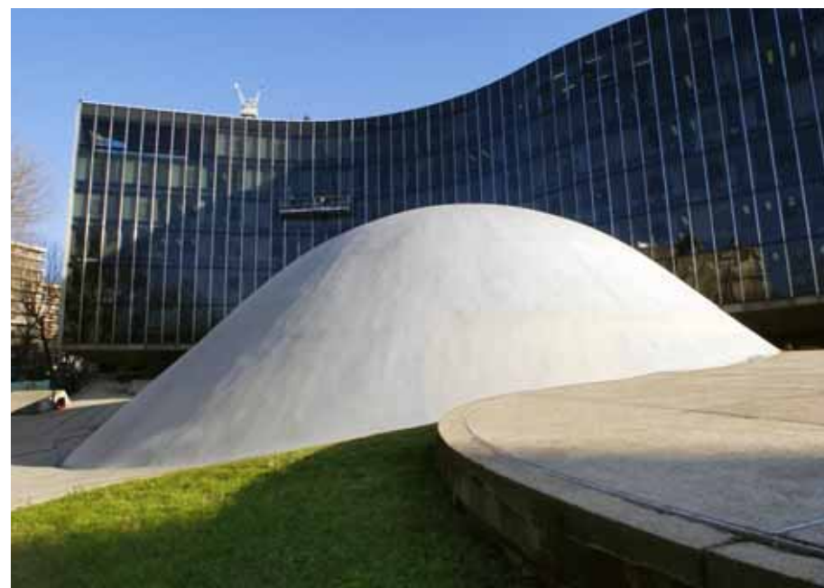
Le siège du Parti Communiste Français a été achevé en 1971 à Paris. Tout en courbes et rondeurs, il illustre à merveille la sensualité architecturale d'Oscar Niemeyer.
