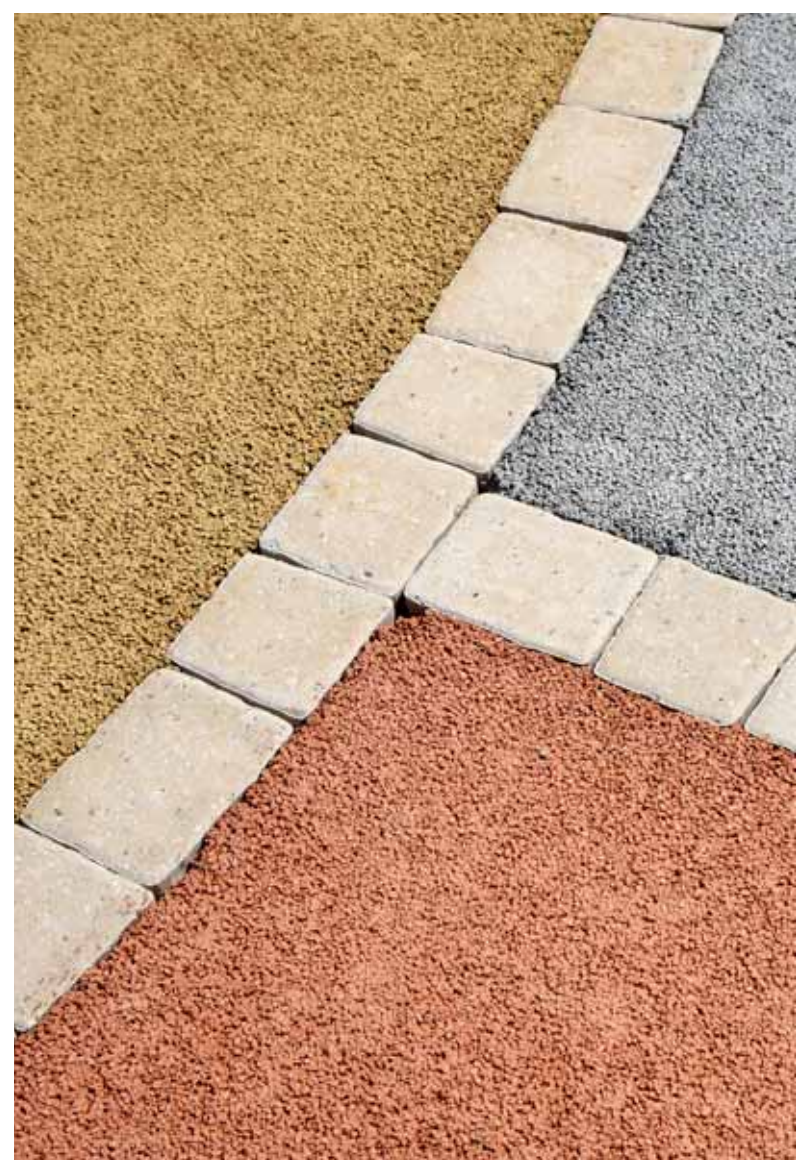
Les revêtements de sol en béton perméable réduisent les risques d'inondation en permettant une infiltration locale des eaux de pluies directement dans la terre – rappelant ainsi le cycle naturel de l'eau – sans déployer de lourds réseaux de collecte.
