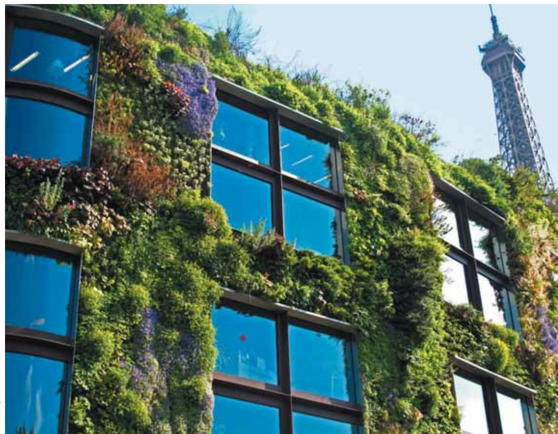
Au-delà de leurs qualités ornementales, les terrasses et les murs végétalisés permettent de gagner de l’espace, d’améliorer l’isolation thermique et acoustique des constructions, d’absorber la pollution atmosphérique, de tempérer le climat, de faciliter la gestion des eaux pluviales ou encore de favoriser la pollinisation.
