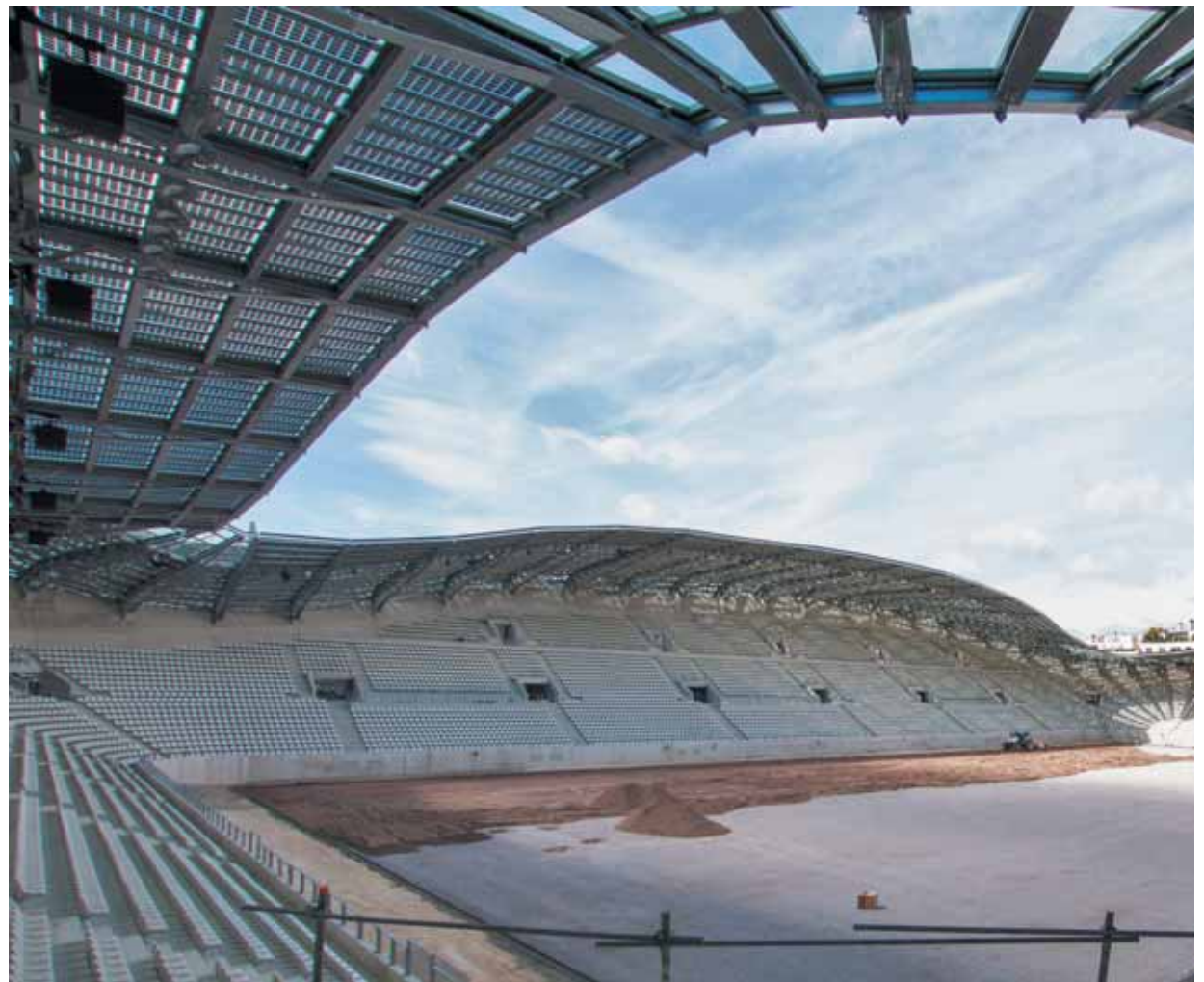
L'immense et magnifique résille en béton à ultra hautes performances du nouveau stade Jean Bouin à Paris. 23 000 m 2 de haute technologie.
