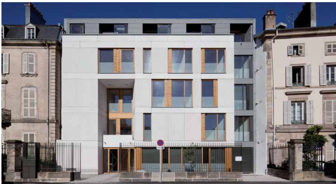
Le Conseil général des Vosges à Epinal [Atelier d'architecture Lucien Colin] est un bâtiment sans climatisation, dont la consommation énergétique totale est inférieure à 65 kWh/m 2 /an. Chauffage hivernal et rafraîchissement estival sont assurés par un plancher chauffant/rafraîchissant, qui utilise l'inertie thermique des dalles en béton armé et joue un rôle primordial dans les performances énergétiques de ce bâtiment.
