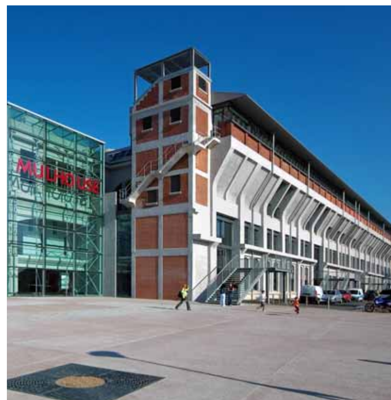
Même vue (façade Ouest) de l'ensemble rénové avec, en façade Nord, l'entrée principale formant un sas de verre enchâssant la première travée de la rue intérieure.
