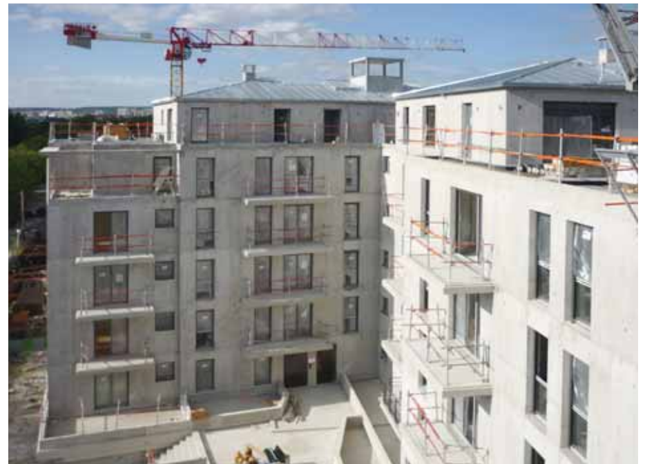
Coulés en place dans des banches, ces bétons «thermiquement efficaces» augmentent la résistance thermique des parois et évitent la mise en place de rupteurs économiquement pénalisants.
