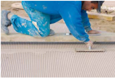
Réalisation des stries de raccord entre deux rectangles.
