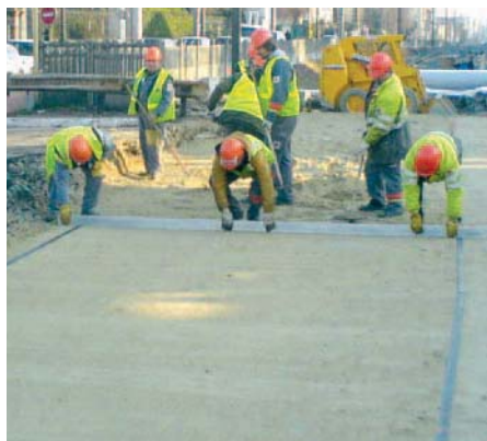
Etape importante : le réglage de niveau du lit de sable sous l'œil du géomètre.
