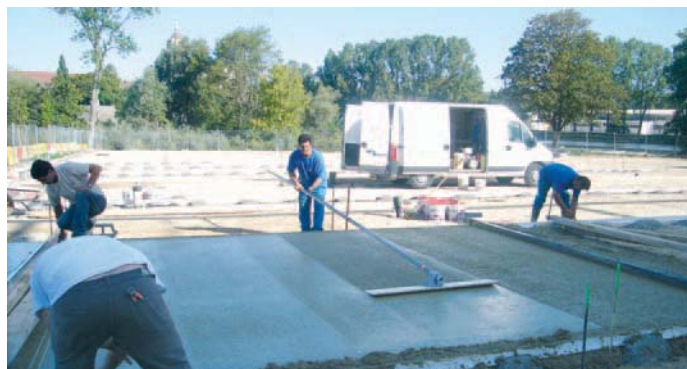
Phase d'incorporation du colorant durcisseur au moyen de la lisseuse à stries, spécialement conçue aux Etats-Unis.
