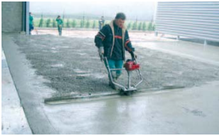
Passage de la poutre vibrante.
