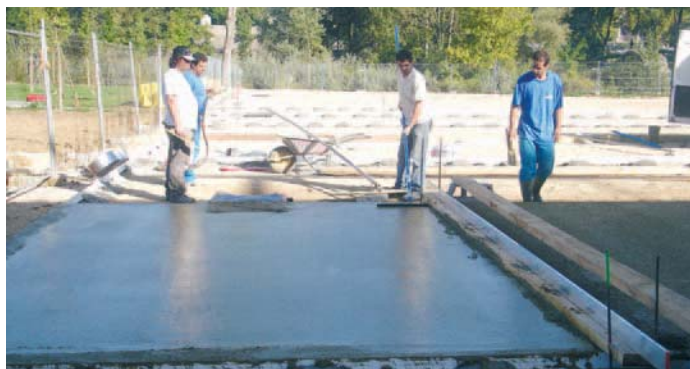
Le lissage du béton prêt à l'emploi, effectué rectangle par rectangle, permet de réaliser une surface bien plane.
