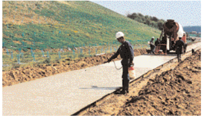
Cure du béton frais : pulvérisateur manuel de type agricole.
