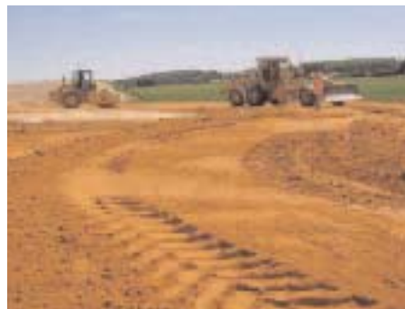
Egalisation au compacteur monobille.
