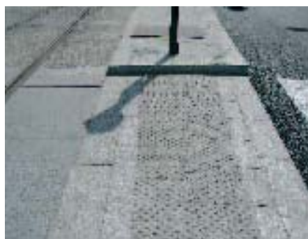
Des bandes podo-tactiles signalent le bord du quai aux malvoyants.
