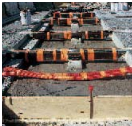
Raccordement des rails et des multitubulaires en plate-forme.
