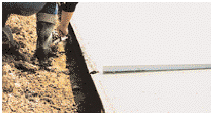
Moulage d'un joint transversal dans le béton frais.
