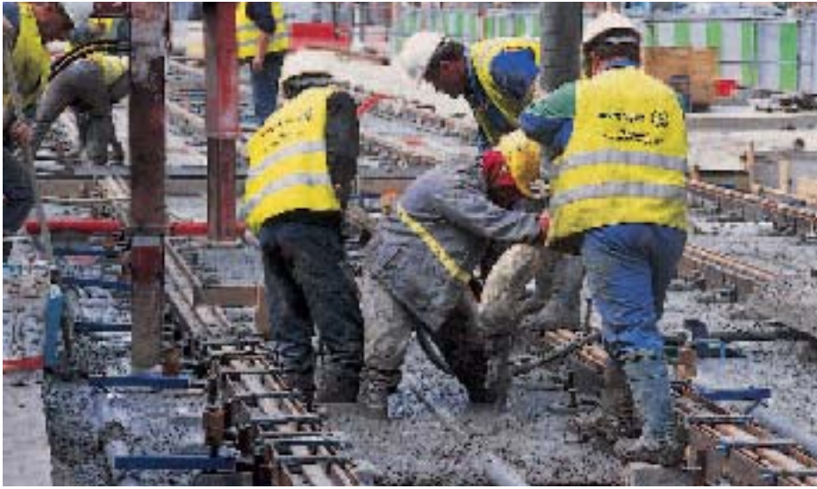
Blocage des traverses en béton par coulage.
