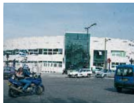
Le nouvel atelier d'exploitation et de maintenance des tramways.
