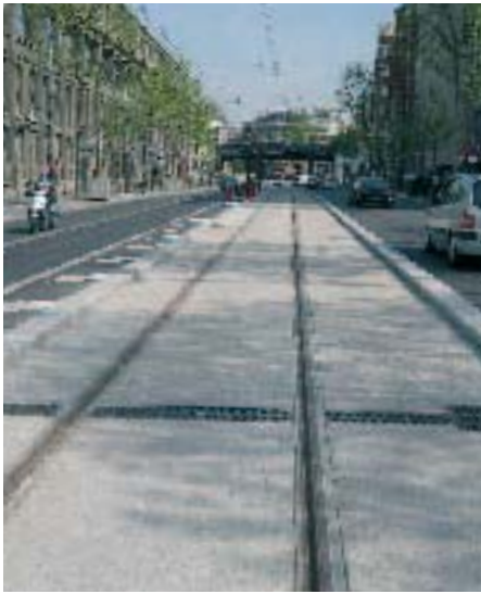
La plate-forme en béton de la voie qui mène à l'atelier de maintenance.
