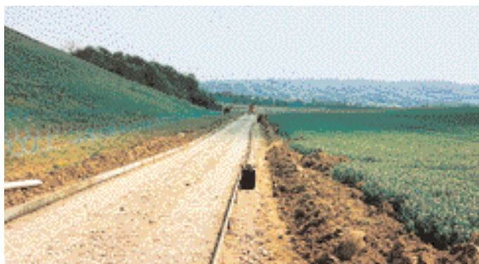
Plate-forme et coffrages exécutés.
