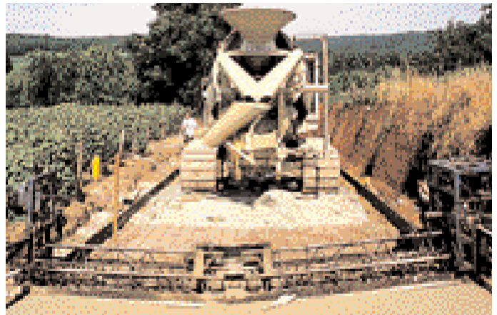
Mise en œuvre au vibrofinisseur.
