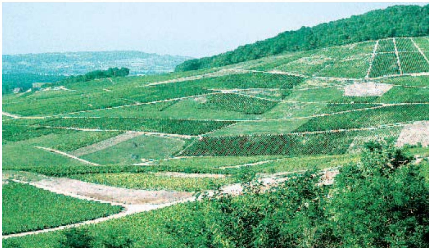
Vue générale : réseau de routes en béton réalisé dans le cadre d'un remembrement agricole.
