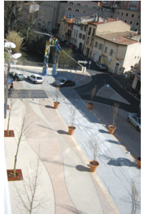
Les bétons désactivés et colorés de la Place du 14 Juillet sont faciles à entretenir et résistants au nettoyage à haute pression.
