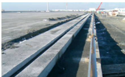
Le rail est à proximité de la réservation.
