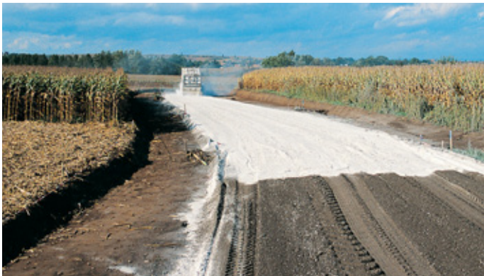
Épandage de liant pulvérulent sur la chaussée fragmentée à traiter.
