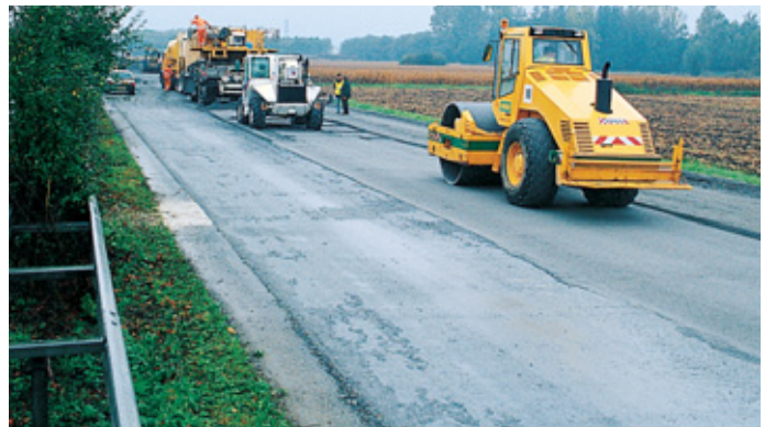
Le passage des compacteurs termine la mise en œuvre des matériaux recyclés en place.
