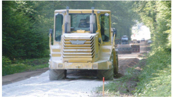
Après épandage du ciment, ou du liant hydraulique routier, le malaxage permet d'obtenir une structure homogène.
