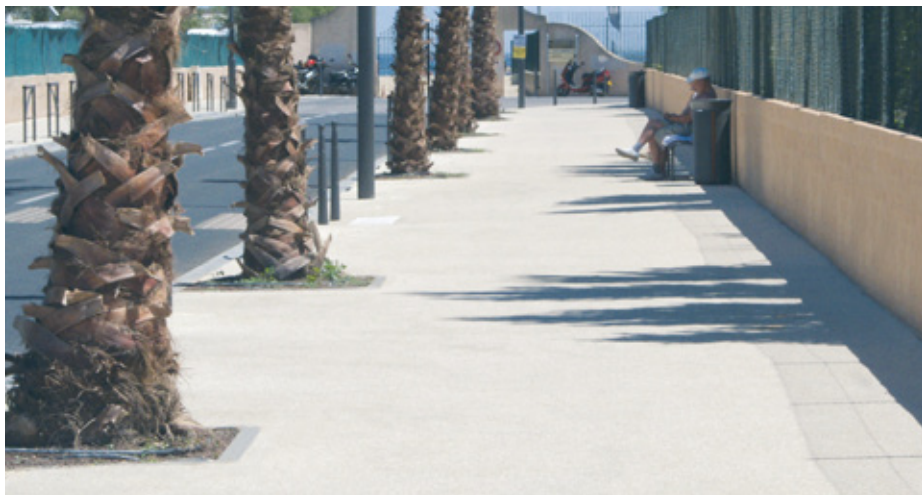
Port-Grimaud : l'accès à la mer a été entièrement traité en béton désactivé.
