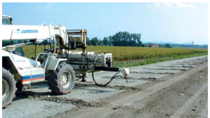
Matériel pour réaliser la préfissuration du matériau traité.
