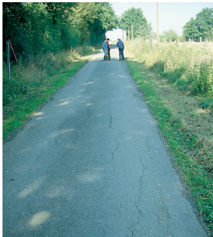
Chaussée dégradée : fissures de fatigue et déformations visibles en surface.
