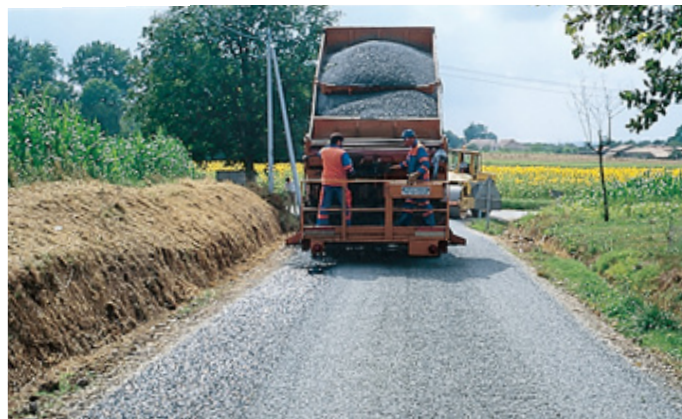
Protection de la structure retraitée par la réalisation d'un enduit superficiel.
