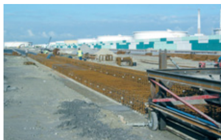
Mise en place du ferrailage de la poutre.
