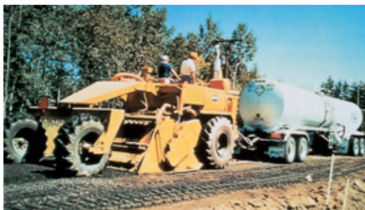
Matériel de malaxage : pulvimixeur à arbre horizontal.
