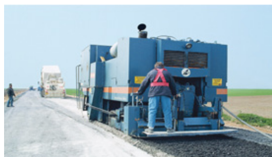
Matériel de retraitement : atelier de reconditionnement des chaussées (ARC dosage et ARC 700 en action).
