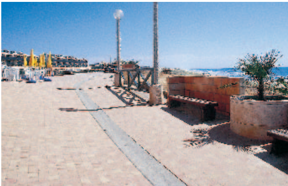
Lacanau-Océan (Gironde) : un aménagement de plus de 13 000 m 2 de pavés béton, avec des pavés carrés pour les voies piétonnes et des pavés autobloquants pour les voies circulées.
