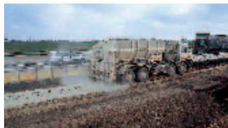
Un liant hydraulique routier spécial réduit de 95 % les émissions de poussières.
