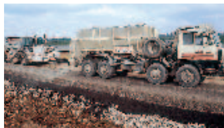
L'atelier de retraitement regroupe un camion d'épandage de liant et un malaxeur.
