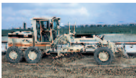
La niveleuse confère à la couche de forme son profil et son dévers final de 2 à 3 %.
