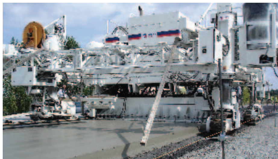
Le fil et les potences assurent le guidage de la slip-form et la qualité finale de l'opération.
