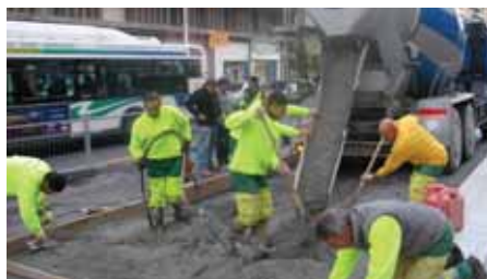
La répartition du béton mobilise une équipe de 8 à 10 personnes.
