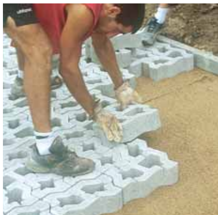
Les pavés drainants en béton se posent bord à bord, comme des pavés autobloquants.
