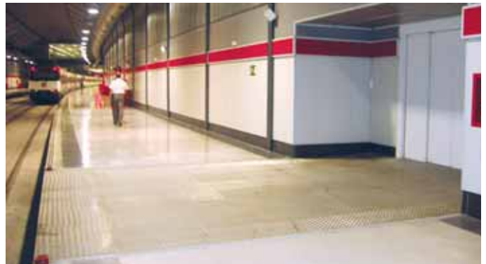
Le tunnel du métro de Madrid (Espagne), station d'Alcobendas : à droite, on aperçoit l'un des ascenseurs permettant la descente directe sur la voie béton de véhicules de secours ou de maintenance.
