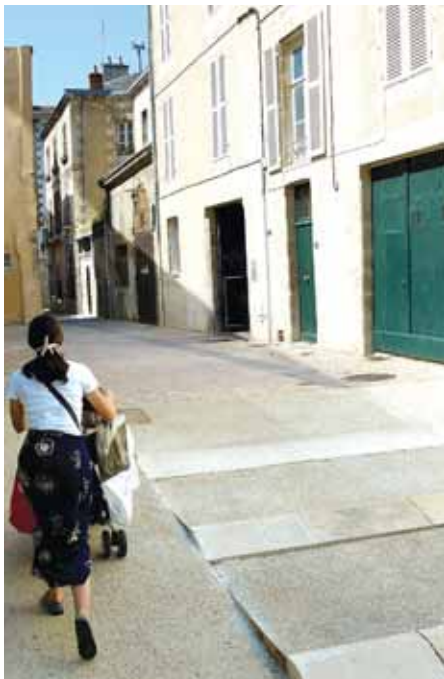
Impasse Petite Roue : le béton désactivé fait la liaison entre ancien et moderne.
