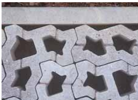
Les bordures latérales en béton assurent le parfait blocage des pavés.
