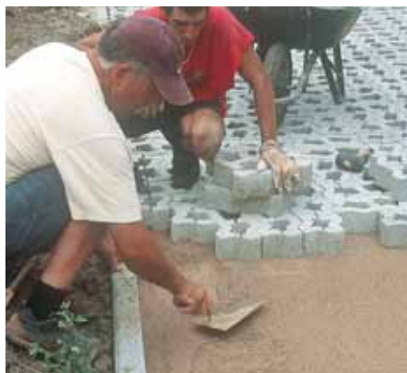
Les pavés drainants en béton se posent sur une couche de 3-4 cm de sable lissé.
