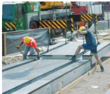
Des engins de levage de type "Travellift" sont utilisés pour positionner les éléments de grande dimension.
