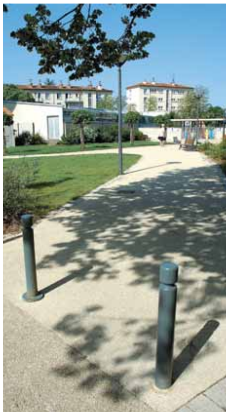
Square Jean Mermoz : mariage réussi du béton désactivé et du sable ciment.
