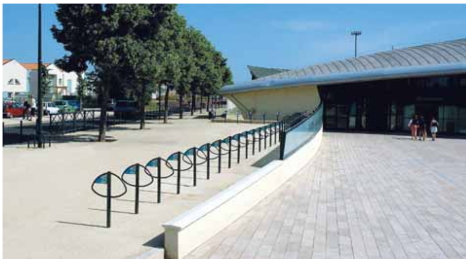
Piscine de la Pépinière : élégante cohabitation de la pierre et du sable renforcé.
