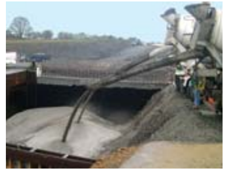
Deux camions-toupies permettent de réaliser le chantier dans la journée.
