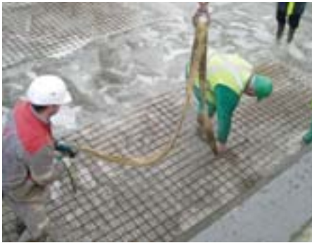
Positionné en partie haute, un treillis métallique sert ponctuellement de renfort.
