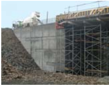
Ce passage nécessite un remblaiement sur une hauteur de 6 mètres.
