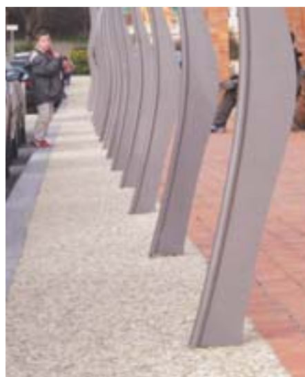
Tresse : le béton désactivé entoure une pergola moderne, faite de métal et de briques, invitant à déambuler ou à s'asseoir.
