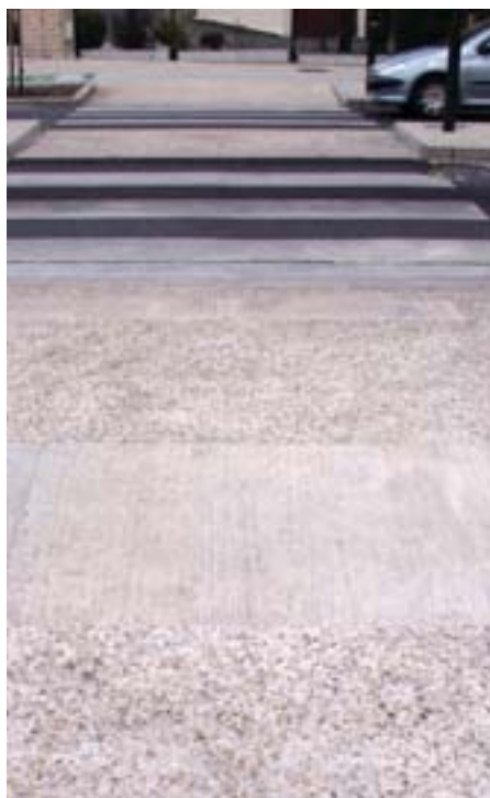
Le Bouscat : bétons balayés et désactivés délimitent l'espace, selon l'usage piéton ou cycliste.
