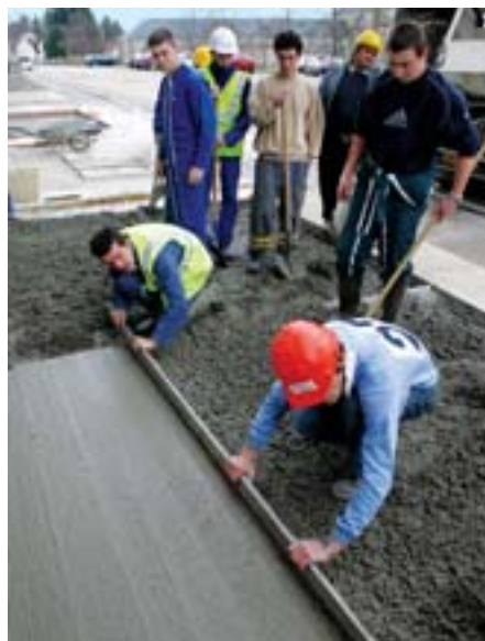
Les élèves font, avec application, l'apprentissage du réglage du béton.
