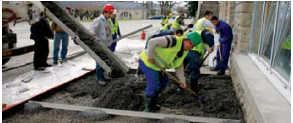
Se confronter à la réalité du terrain : un atout pour de futurs chefs de chantier.
