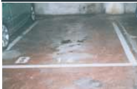
Sol de parking avant minéralisation.
