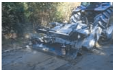
Le traitement de sol, réalisé par un concasseur, est suivi d'un compactage.
