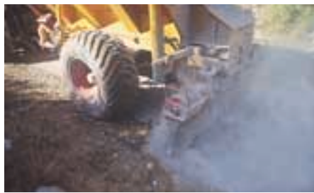
Le liant est épandu à raison de 15 kg par m 2 , soit 150 kg par m 3 de matériau.
