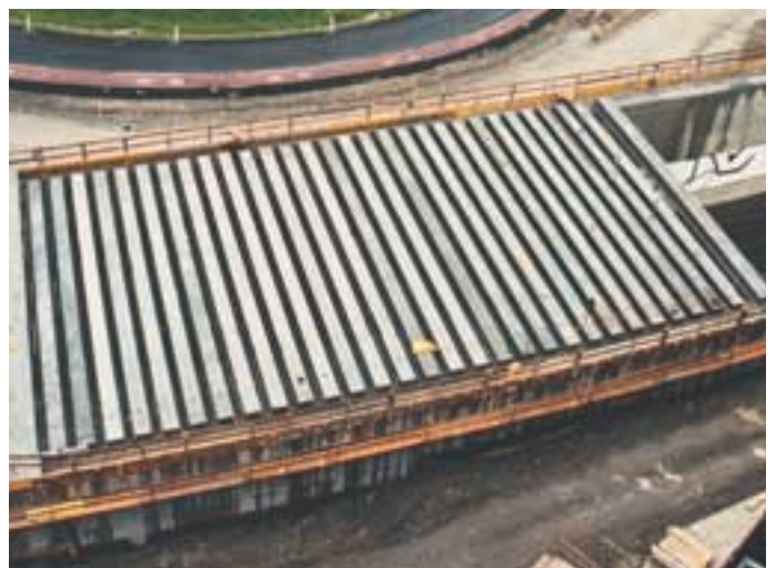
Couverture d'une tranchée couverte en poutres précontraintes.
