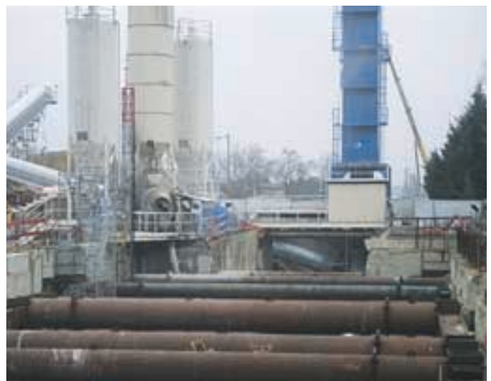
Butons pour assurer la stabilité des parois moulées.
