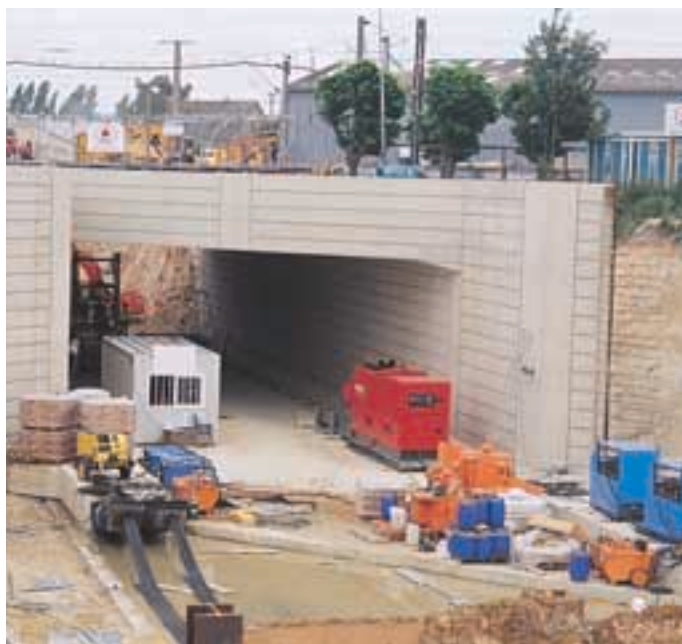
Ouvrage cadre mis en œuvre par "autoripage".
