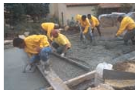
Le béton est mis en œuvre à la main par du personnel spécialisé pour chaque tâche.
