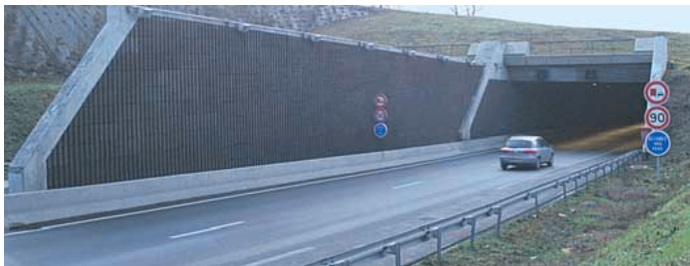
Tranchée couverte équipée de panneaux acoustiques.
