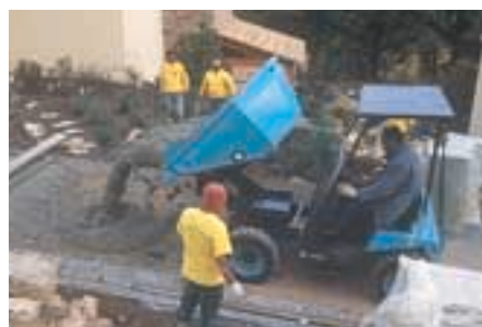
L'exiguïté des lieux impose l'utilisation d'une moto-pelle.
