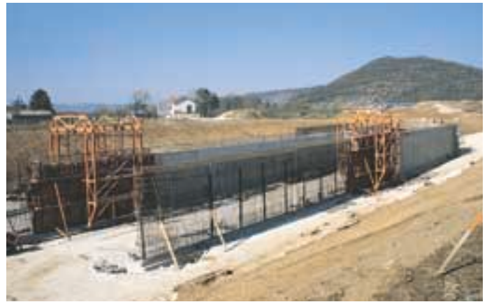
Coffrage et ferrailage de la tranchée dans une fouille talutée.
