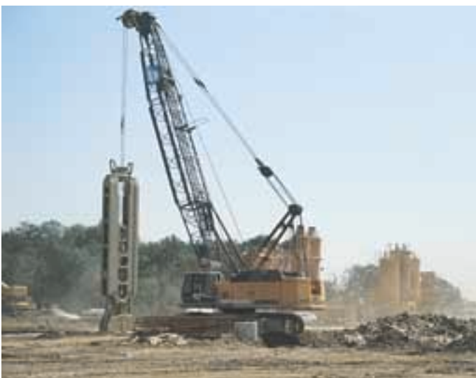
Réalisation d'une paroi moulée.
