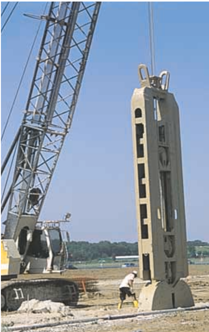
Réalisation d'un écran étanche.
