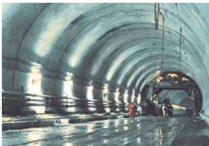
Revêtement d'un tunnel en béton coffré.
