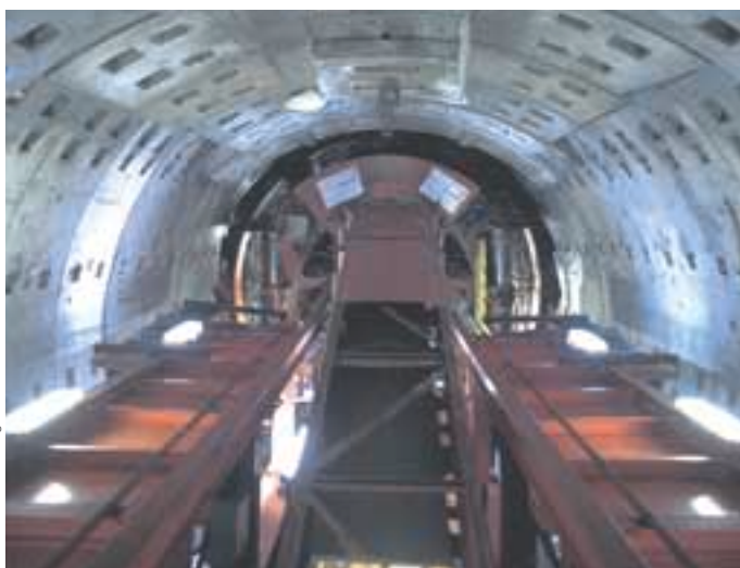
Voussoir préfabriqué en béton, en cours de pose (vue du tunnelier).
