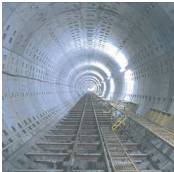
Revêtement d'un tunnel en voussoirs préfabriqués en béton armé.
