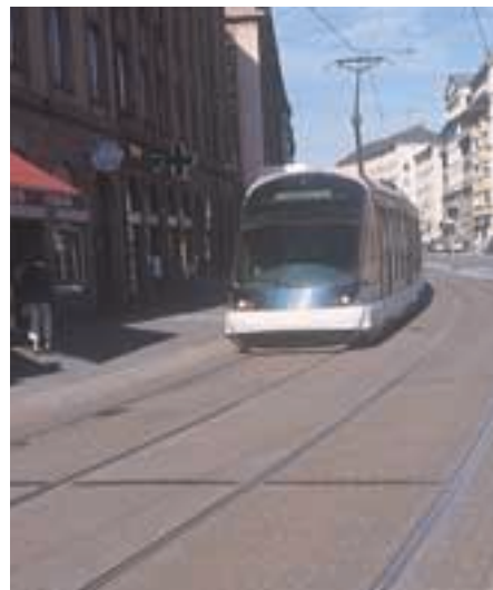
Strasbourg : une plateforme constituée de trois couches de béton dense.
