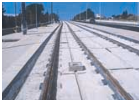
Montpellier : 50 000 m 2 bétons désactivés et dalles sur une plateforme en béton compacté.
