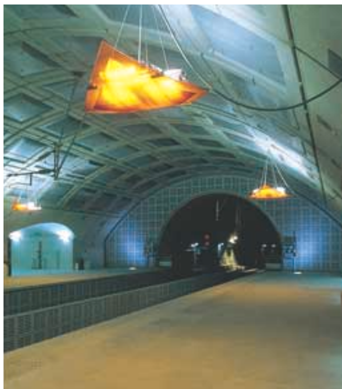
L'une des deux gares souterraines du RER E.
