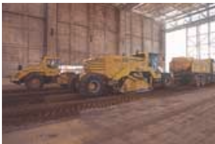
Les plateformes des hangars sont réalisées par traitement du sol à la chaux et au ciment.
