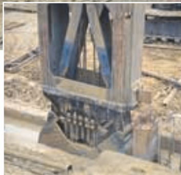
Cages d'armatures mises en place dans la tranchée.
