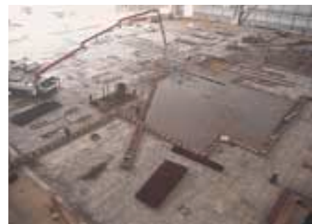
Coulage à la pompe permettant l’approvisionnement du béton en tous points.
