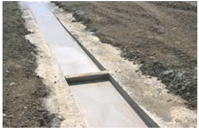
Tranchée remplie de coulis bentonite-ciment.
