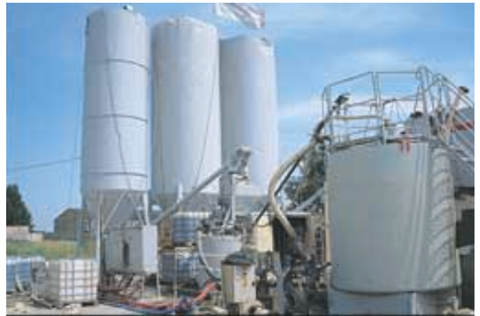
Station de fabrication du coulis de bentonite.
