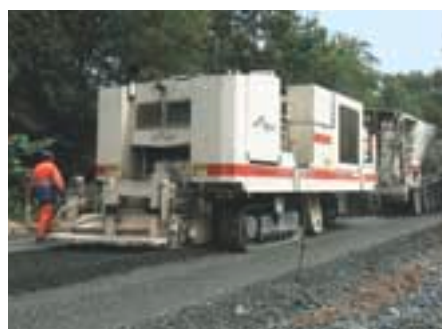
L'ARC 700 (Atelier de Reconditionnement de Chaussées) imaginé par Appia.
