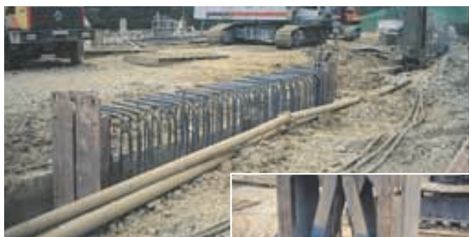
Cages d'armatures mises en place dans la tranchée.
