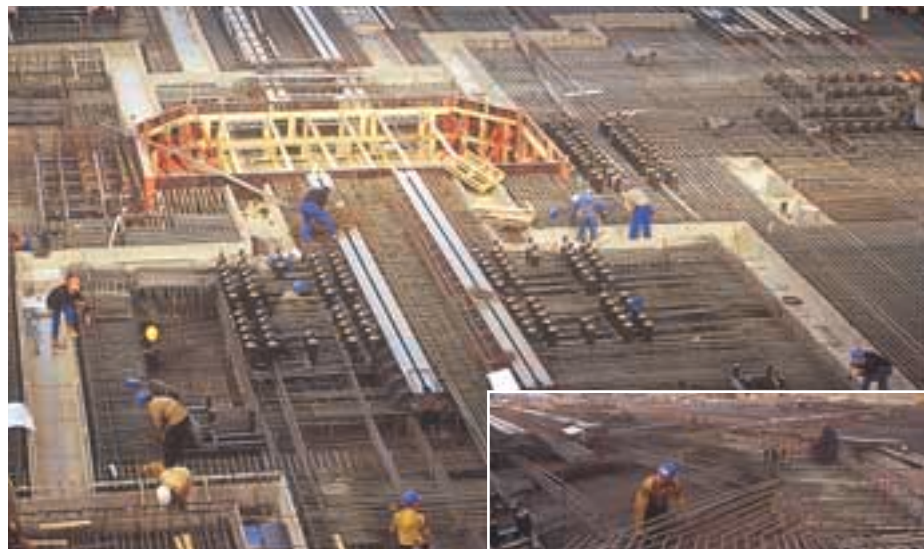
Le portique accueillant l’A380 est ancré sur de nombreux inserts et nécessite un nombre exceptionnel d’armatures.
