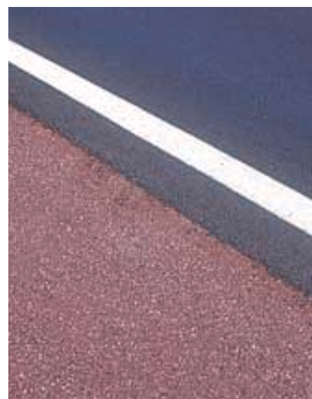
Le retraitement d'une chaussée gagne à être étendu aux accotements pour les stabiliser et accroître la sécurité des usagers.
