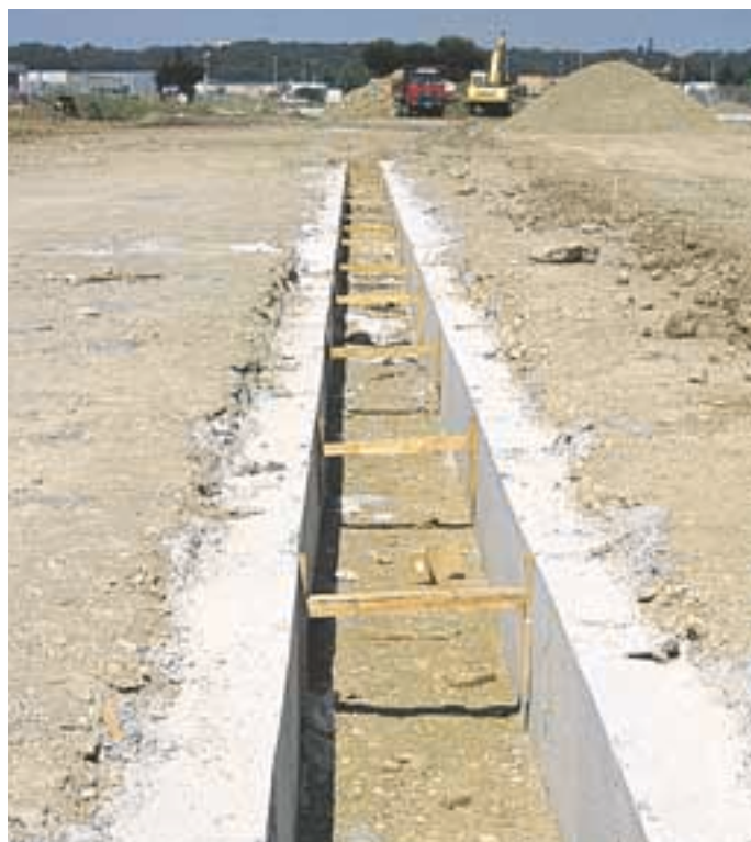
Muret-guide en béton.
