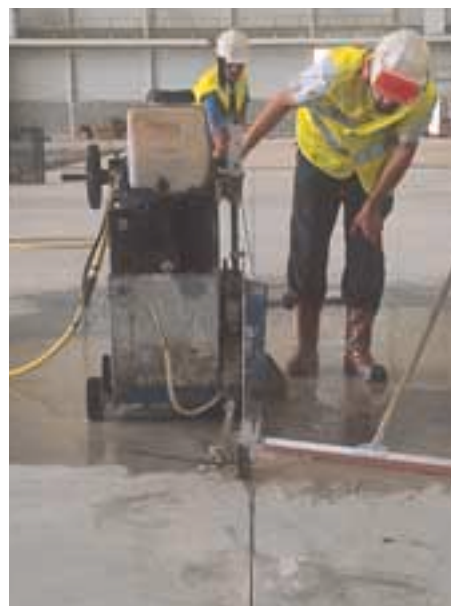
La scie diamantée permet de positionner avec précision les joints de retrait.
