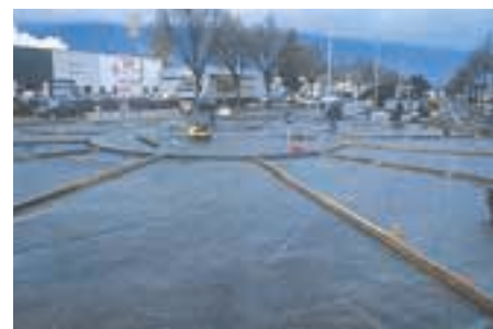
Des coffrages radiaux scindent la surface en petites unités et limitent les joints sciés.
