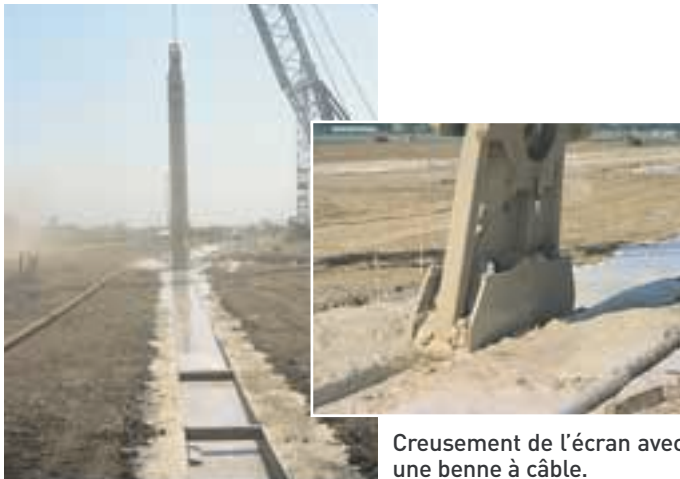
Tranchée remplie de coulis bentonite-ciment.
