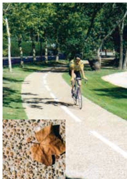
Piste cyclable en béton désactivé.
