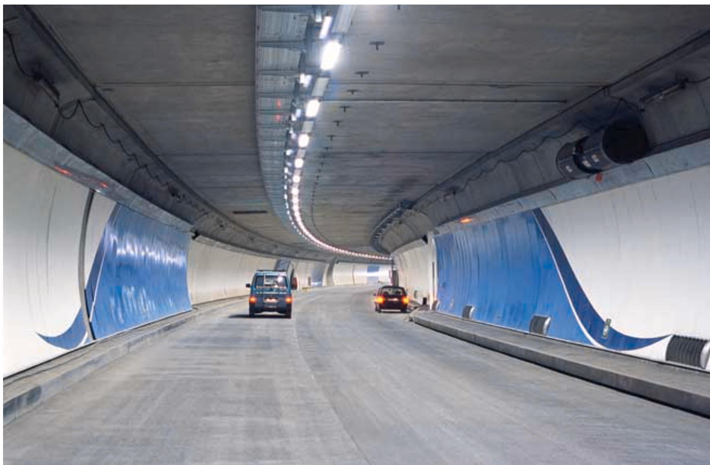
La chaussée en béton armé continu du tunnel de Cointe en Belgique : un revêtement durable, stable en toutes circonstances, clair et sûr.
