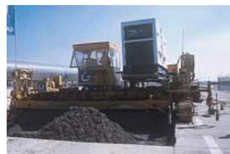
La dalle béton de 40 cm est réalisée avec une machine à coffrage glissant.
