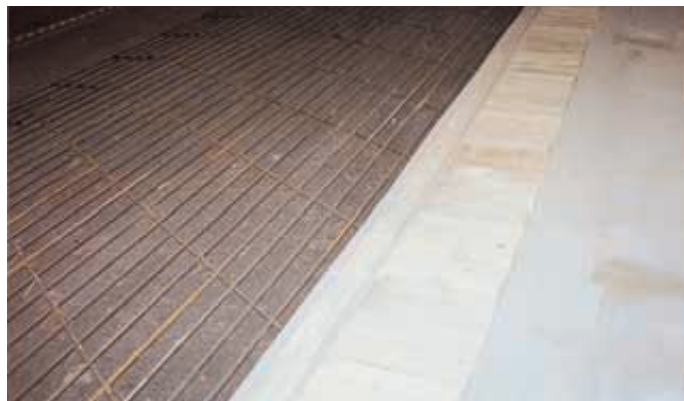
Le béton armé continu (BAC) garantit la régularité de l'uni et l'absence de joints.
