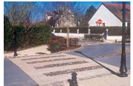
La municipalité de Compans requalifie ses espaces publics avec du béton désactivé.
