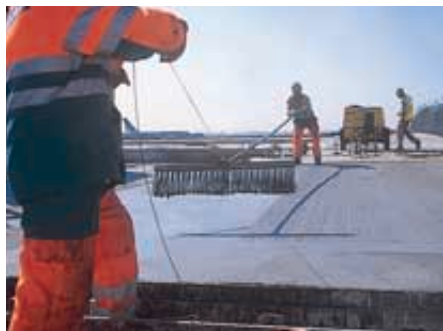
Balayage de la surface du béton.
