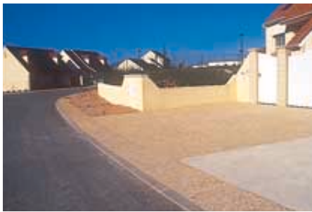
Lotissement de Chauconin Neufmontier : le béton désactivé conjugue résistance pendant les travaux et qualité esthétique.
