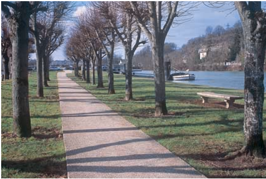
Saint-Mammès : l'aménagement des quais de bord de Seine en béton désactivé à contribué à la réussite de la requalification du site.
