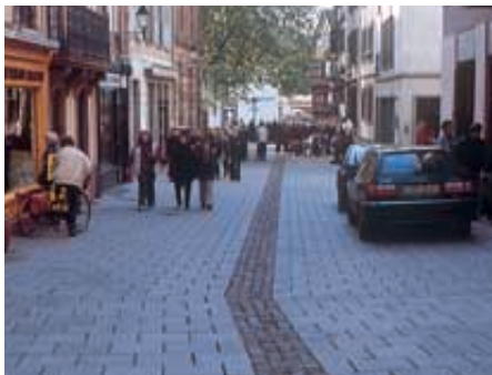
Rue du Fossé des Tanneurs : dalles en béton gris, à dominante rose et de grand format (40 x 40 cm) pour le confort de marche.
