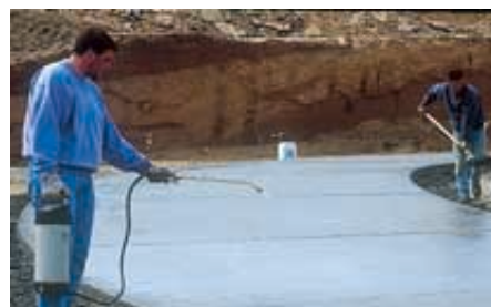
Le béton est protégé pendant sa prise par l'application d'un produit de cure.
