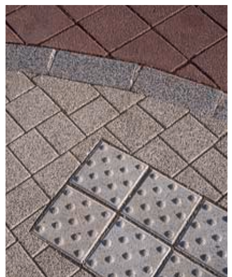
Les produits préfabriqués en béton offrent une grande variété d'aspects, de textures et de formats (ici dalles podo-tactiles).
