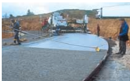
La finition balayée du béton est destinée à augmenter l'adhérence des pneumatiques.
