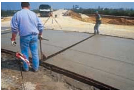
Les joints de retraits sont matérialisés par un marquage à l'aide d'un fer.
