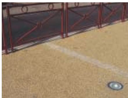
Bassens : le béton désactivé des trottoirs apporte une indéniable valeur esthétique et un meilleur confort aux usagers.
