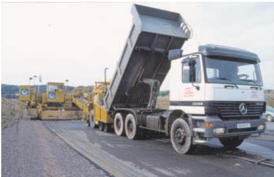
Le bétonnage est réalisé à l'aide d'une machine à coffrage glissant et les armatures sont placées au moyen de trompettes.
