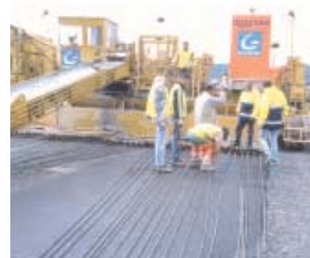
Le bétonnage est réalisé à l'aide d'une machine à coffrage glissant et les armatures sont placées au moyen de trompettes.
