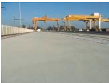
Plate-forme multimodale d'Hourcade : le béton armé continu a été retenu pour sa grande résistance au poinçonnage des containers.
