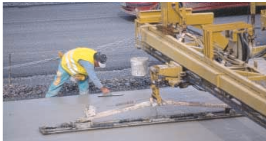
Un talochage manuel complète l'action du super-smoother .
