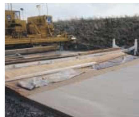
Le passage d'une toile de jute humide unifie la surface de la chaussée.
