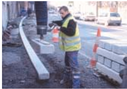
Pose d'une bordure à la ventouse.
