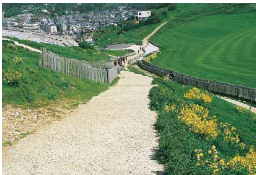
▲ Étretat : l'utilisation du béton a permis de respecter le site en conservant le profil initial du cheminement.
