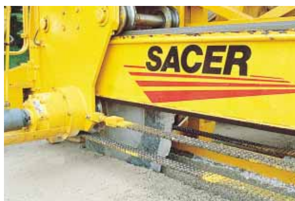
▲ Procédé Sétéc-Sacer : le disque de la trancheuse ouvre un sillon tous les 2 m dans la grave-ciment.
