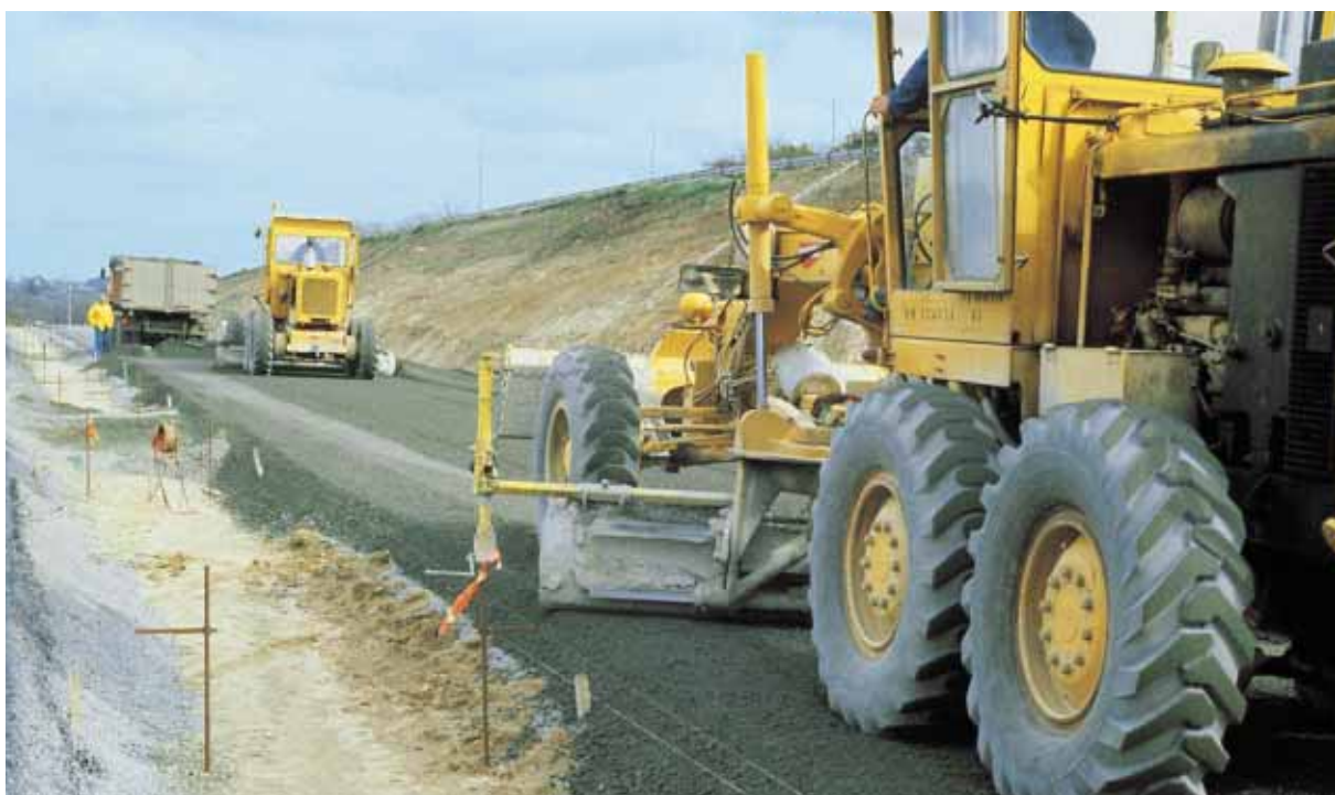
▲ Chantier de mise en œuvre des graves-ciment.
