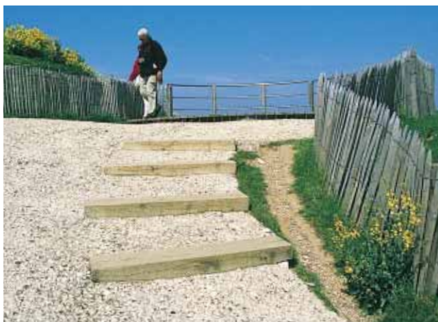
▲ Étretat : les passages trop escarpés ont été aménagés en marches sommaires par la simple intégration de poutres de chêne directement dans le béton.
