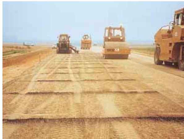
▲ L'atelier de compactage suit la machine de préfissuration. Les joints exécutés sont espacés de 2 à 3 m.
