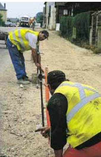
▲ Le guidage de la machine à coffrage glissant en trois dimensions exige l'installation d'un fil tendu et réglé selon les cotes du projet.
