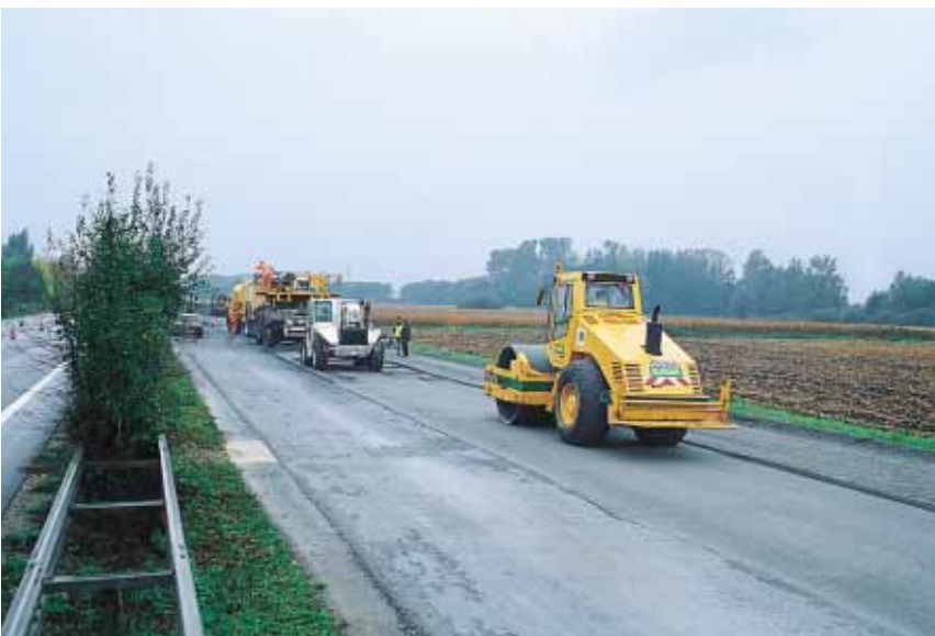
▲ Le passage des compacteurs termine la mise en œuvre des matériaux recyclés en place.
