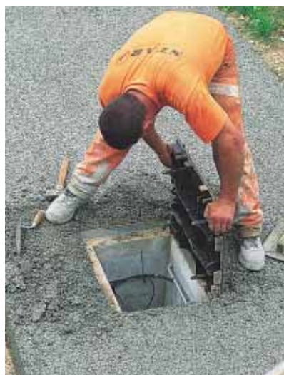
▲ Le relevage des regards est fait manuellement.
