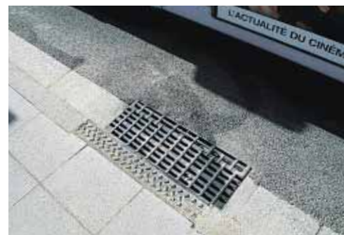
▲ Les bordures et caniveaux en granite mettent en valeur les dalles béton.
