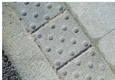
▲ Des dalles podotactiles signalent aux malvoyants les passages piétonniers surbaissés.
