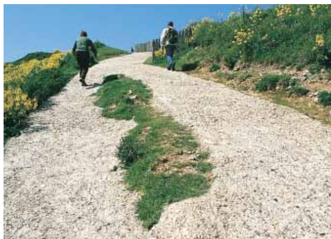
▲ Étretat : la rugosité naturelle du béton désactivé offre au marcheur une sécurité supplémentaire dans les passages les plus pentus de l'ascension.
