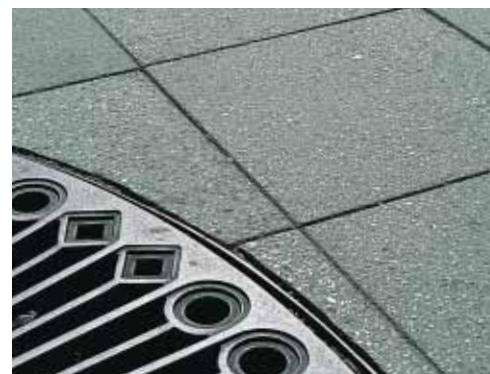
▲ Les dalles bordant les grilles d'arbres sont découpées sur place.
