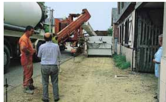
▲ Intervenir en site urbain, au ras des propriétés, a demandé à l'entreprise d'être à l'écoute des usagers.
