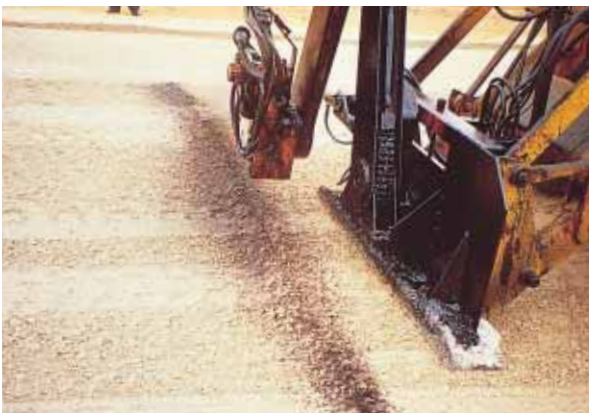
▲ Procédé LCPC-CBC : le soc projette simultanément, sur les parois du sillon, une émulsion de bitume.
