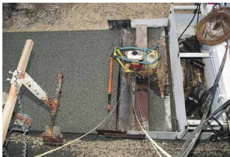
▲ La finition d'un béton drainant est réalisée par une lisseuse vibrante tractée derrière le moule. Cet accessoire, constitué d'une plaque métallique rigidifiée de 60 cm de largeur, et actionné par un moteur couplé à une masse excentrée.
