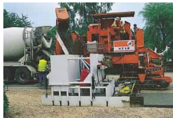
▲ La mise en œuvre mécanisée a permis d'atteindre des rendements moyens journaliers variant entre 350 et 500 m par jour.
