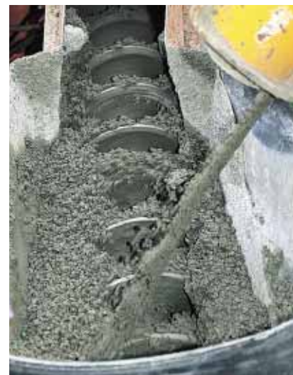
▲ Le béton est déversé non pas devant la machine à coffrage glissant, mais dans une vis d'alimentation qui provisionne le moule déporté.
