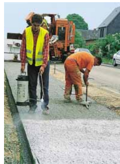
▲ Bien qu'il soit drainant, le béton est désactivé afin d'obtenir une finition plus appropriée au site urbain.
