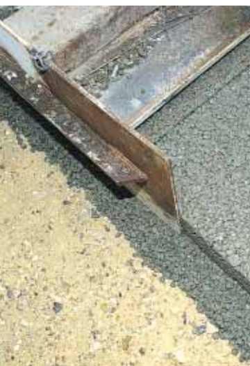
▲ L'action de la règle vibrante apporte une très grande qualité de finition (régularité de l'uni et de l'aspect).
