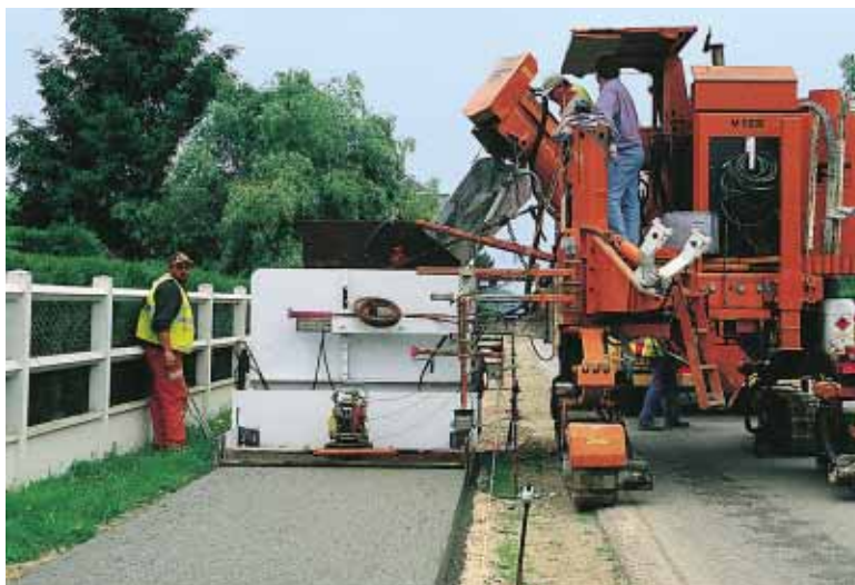
▲ L'utilisation d'un moule déporté, peu courante pour l'exécution de chaussées, est fréquente pour des ouvrages comme les glissières en béton armé ou les bordures continues en béton.
