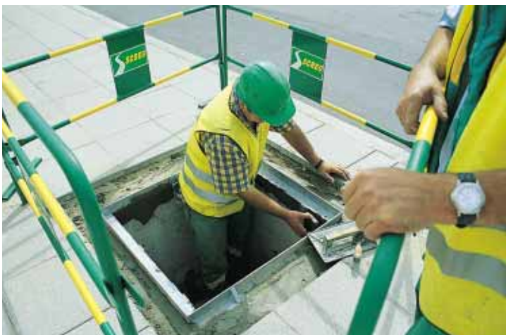
▲ Les dalles de couverture des regards sont coulées en place.
