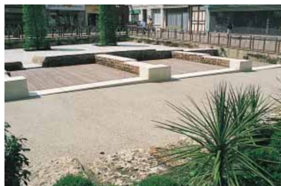
▲ Lillebonne : les vestiges gallo-romains mis au jour lors des travaux d'aménagement de la place ont été conservés, et l'ancienne rue bordée d'échoppes a été réalisée en béton désactivé.
