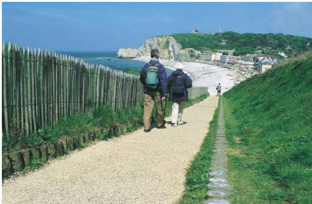
▲ Étretat : réalisé en graves de Seine et ciment blanc fibré, le chemin d'accès à la falaise d'aval se joue du chaos de la pente en offrant un confort de marche aux touristes.
