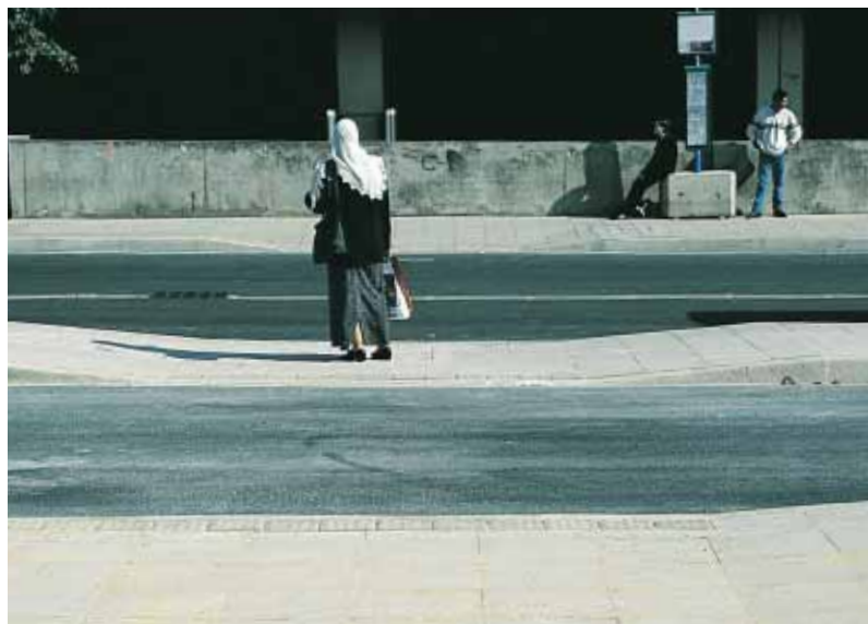
▲ Un calepinage soigné apporte une transition esthétique avec les zones surbaissées des passages piétonniers.
