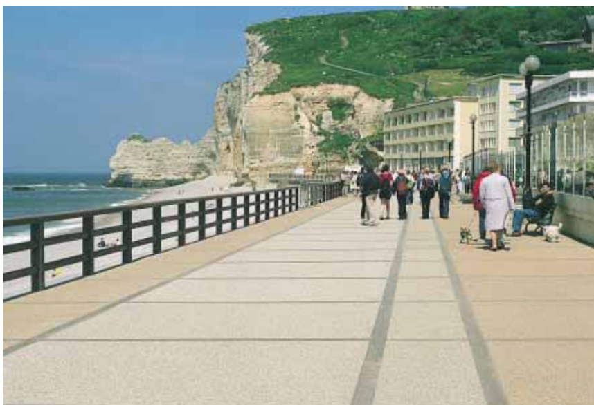
▲ Étretat : les granulats naturels mis à jour par la désactivation du béton et l'emploi de bétons colorés offrent au perrey un aspect résolument moderne, tout en respectant le site grandiose des
