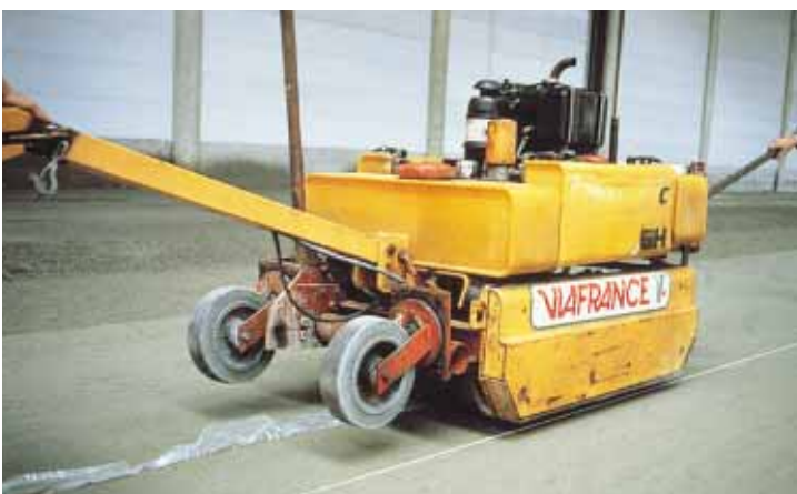
▲ Procédé Viafrance : machine à trancher les joints en position de travail. L'incorporation, dans le joint, d'une feuille de polyane permet d'éviter les épaufrures aux bords de l'entaille.
