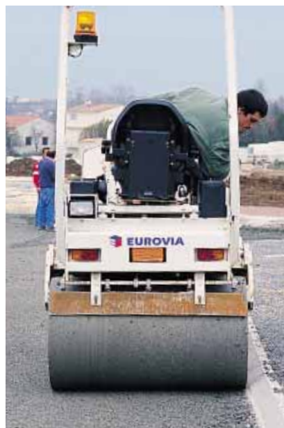
▲ Passage d'un rouleau de 2,5 t pour les finitions et le long des bordures.
