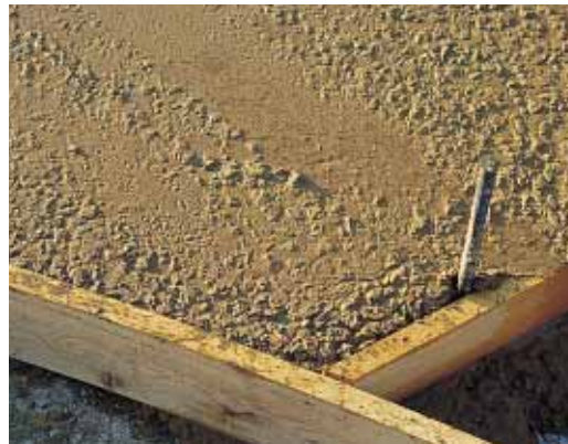
▲ Les liaisons entre les coffrages ont demandé un grand soin dans l'exécution.
