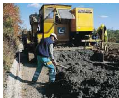
▲ ... afin d'adoucir la tâche des maçons.
