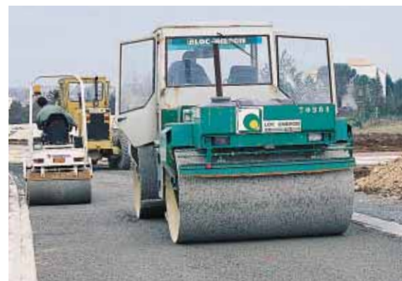
▲ Passage d'un rouleau de 2,5 t pour les finitions et le long des bordures.
