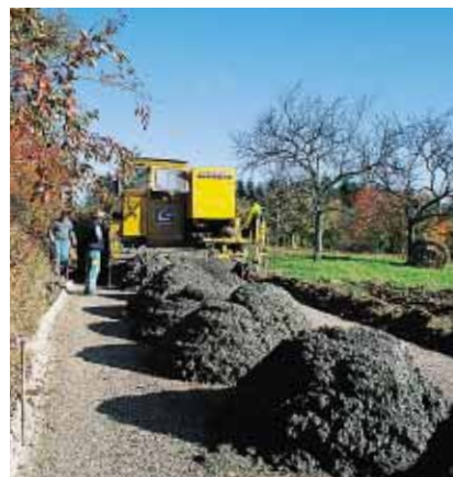
▲ La faible largeur de la chaussée béton (3 m) demandait une bonne répartition du béton frais sur une vingtaine de mètres...
