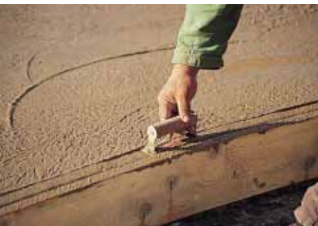
▲ Le béton a été balayé en respectant une même orientation sur la totalité du chantier.
