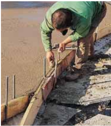
▲ L'exécution de motifs en vagues a demandé l'installation de coffrages courbes, systématiquement contrôlés par le maître d'ouvrage délégué avant la mise en œuvre du béton.
