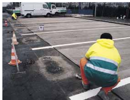
▲ Réalisation des marquages au sol dès le lendemain matin.
