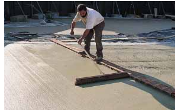
▲ Le béton a été balayé en respectant une même orientation sur la totalité du chantier.
