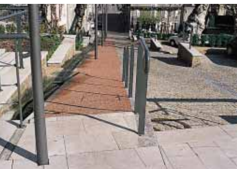
▲ Terrasson : le béton désactivé rouge a été obtenu grâce à des débris de briques et de tuiles concassées.
