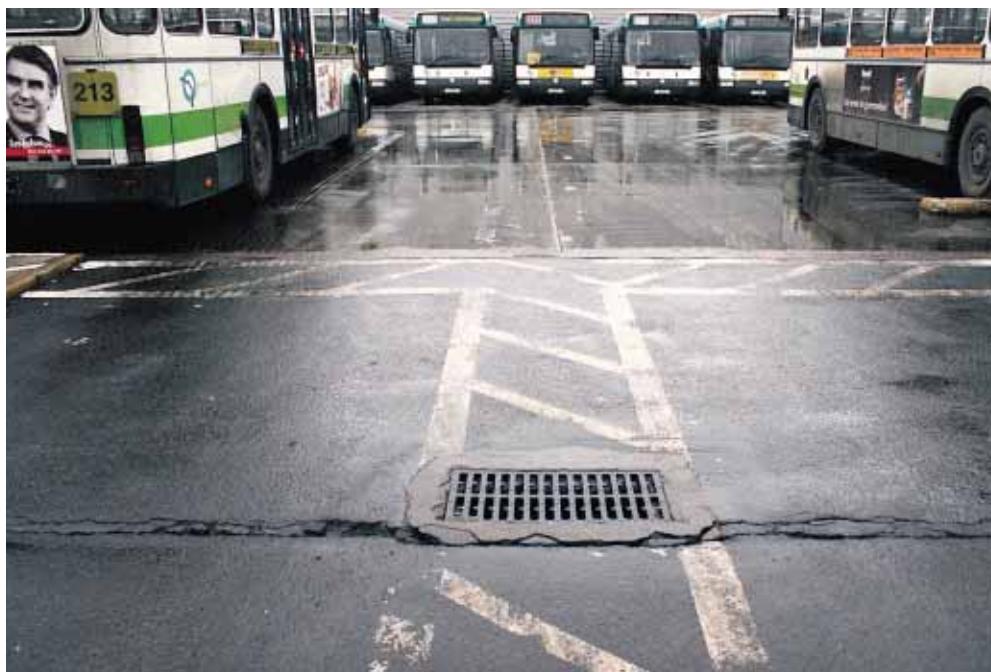
▲ Marqué par de profondes ornières, le dépôt de bus de Neuilly-Plaisance est remis en état en plusieurs tranches successives.
