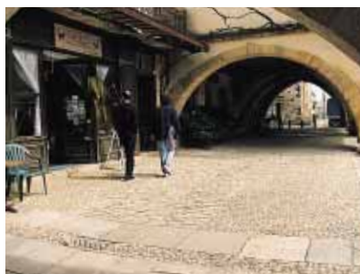
▲ Monpazier : du béton désactivé pour la refonte de la place centrale à cornière mais également pour les rues et les ruelles.
