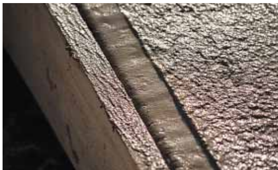
▲ Le béton a été balayé en respectant une même orientation sur la totalité du chantier.
