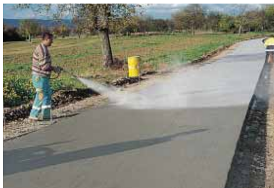
▲ Un enduit de cure est pulvérisé à la surface du béton pour le protéger des variations de température et d'hygrométrie pendant les premières heures de la prise.
