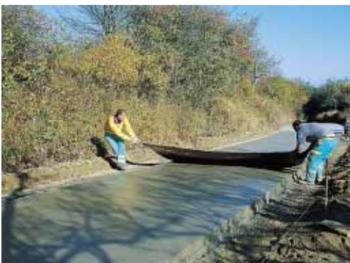
▲ Le passage d'une toile de jute confère à la chaussée une finition longitudinale très appréciée des cyclistes pour son confort de roulement.
