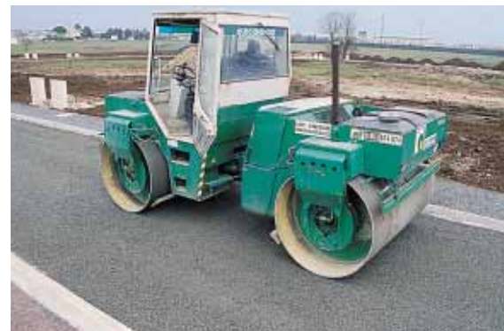
▲ Cylindrage par passage à quatre reprises d'un rouleau tandem de 11 t.
