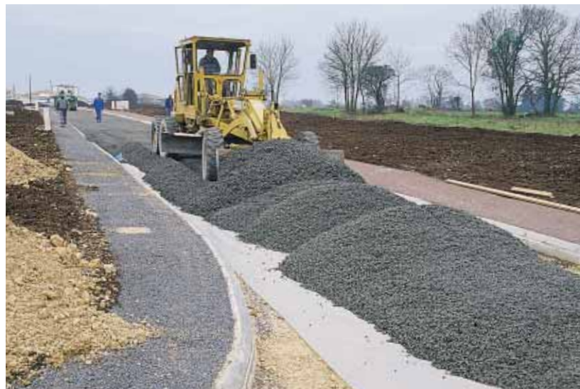
▲ Réglage à la niveleuse de la couche de béton à - 4 cm du niveau fini.
