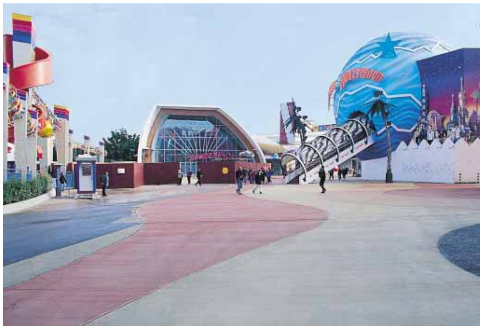
▲ Le choix du béton permettra d'accueillir sans crainte de dégradation les très nombreux visiteurs qui empruntent chaque année la rue de Disney Village.
