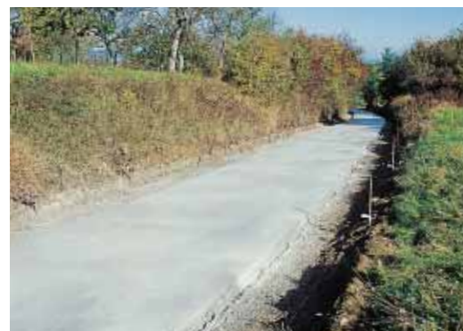
▲ La chaussée béton résistera aux rigueurs du climat comme aux agressions engendrées par la végétation ou le passage des engins agricoles.
