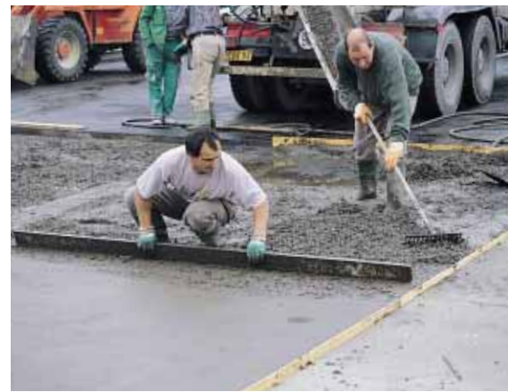
▲ Réglage sur une épaisseur moyenne de 8 cm.
