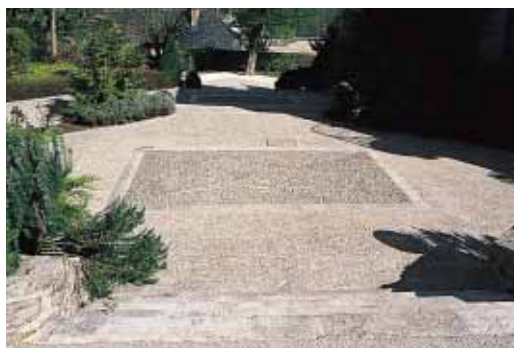
▲ Terrasson : la combinaison de différentes granulométries permet de créer des motifs dans le béton désactivé.
