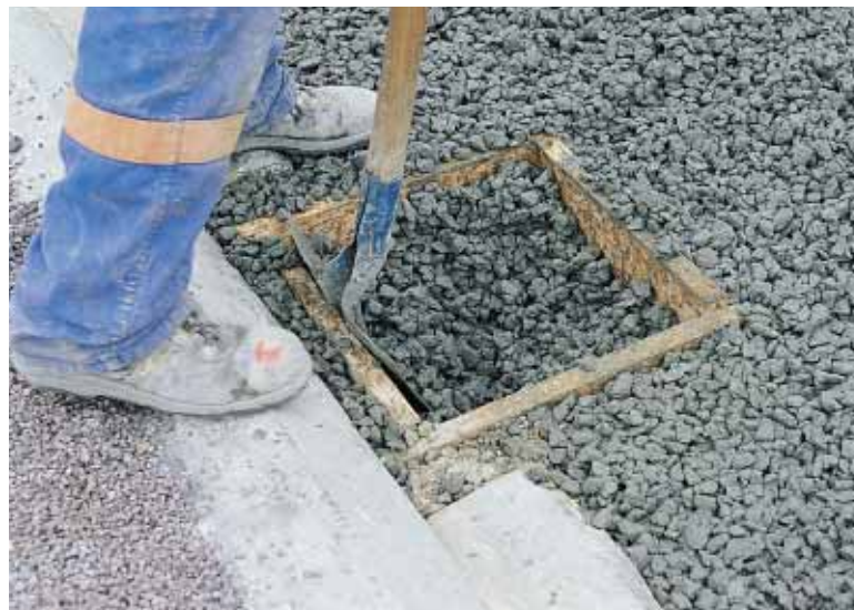
▲ Des réservations permettent de prévoir des regards et des grilles-avaloirs.
