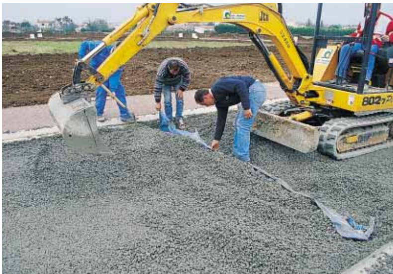
▲ Le polyane doit remonter dans l'épaisseur de la structure pour créer une barrière d'étanchéité.
