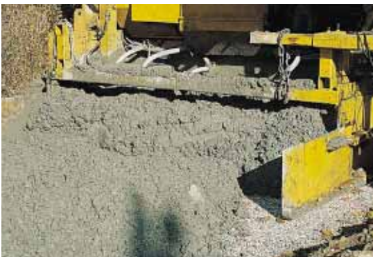
▲ Comme toutes les machines à coffrage glissant, la MSP 50 Gunter & Zimmermann est équipée de vibreurs qui garantissent le bon "serrage" du béton. Elle est guidée par des fils à la fois en direction et en altimétrie, sur 3 points (correction d'assiette).
