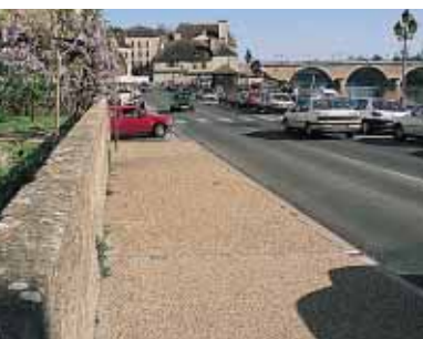
▲ Bergerac : à quelques pas de la Dordogne, les trottoirs du port sont réalisés en désactivé.
