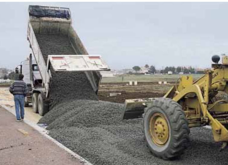
▲ L'approvisionnement du chantier en béton poreux s'effectue par camion-benne 6 x 4.
