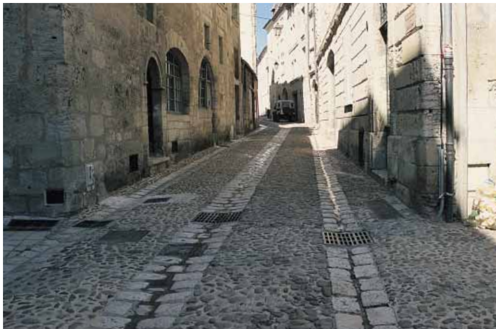
▲ Périgueux : dans la vieille ville, les rues ont été reconstruites à l'ancienne, soit en béton désactivé avec des granulats de petite taille, soit avec des galets percolés dans du béton, le plus souvent désactivés.
