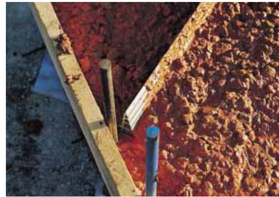
▲ Les joints qui ne pouvaient être sciés ont été réalisés avec des baguettes en aluminium
