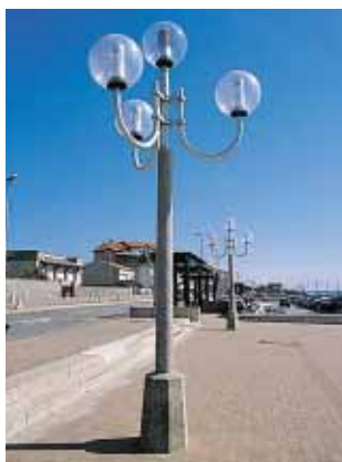
▲ Les supports de candélabres sont réalisés en béton désactivé, matériau insensible au phénomène de corrosion lié à l'air marin.
