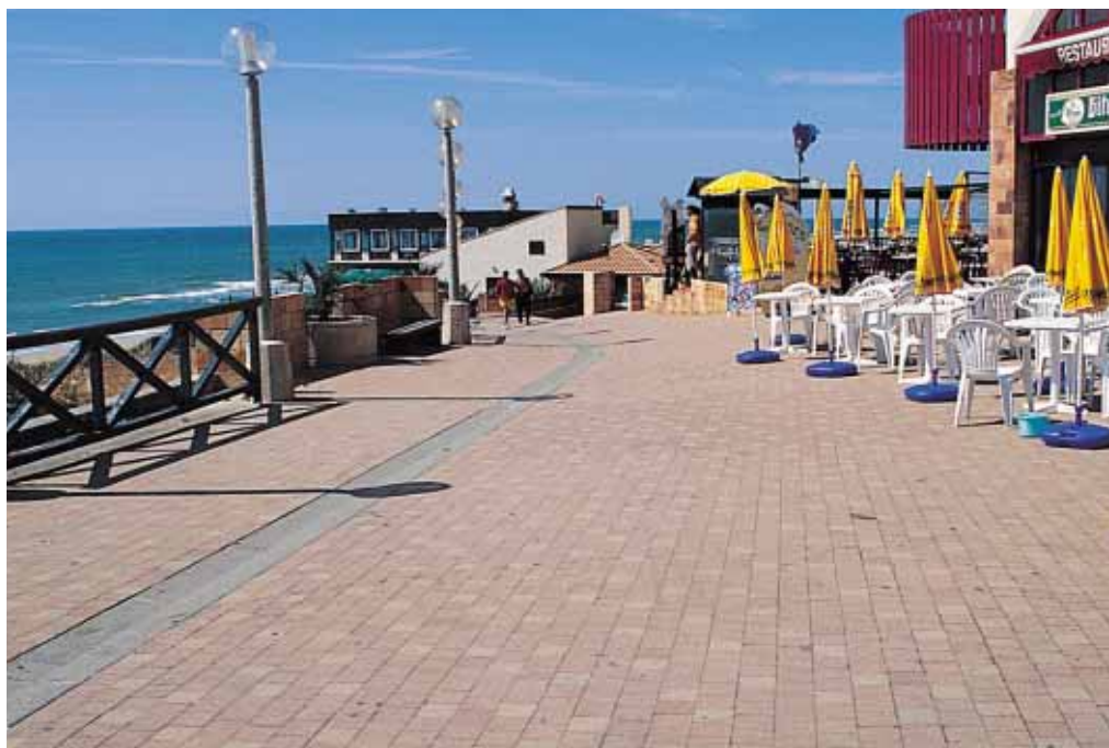
▲ Lacanau-Océan : un programme d'aménagement réalisé entre 1988 et 1999 qui fait appel à 13 000 m 2 de pavés béton.
