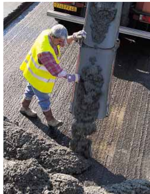
▲ Livré par camion-toupie, le béton est déposé à l'avant de la slip form.
