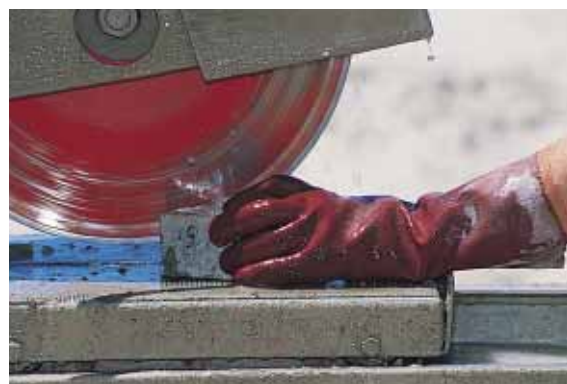
▲ ▼ Le traitement des zones non rectilignes a nécessité de nombreuses coupes sur mesure.
