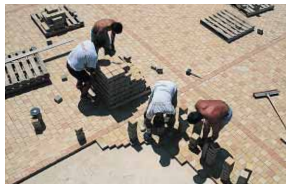
▲ L'aménagement associe trois teintes réparties selon des proportions précises (70 % de saumon, 20 % de beige, 10 % d'orange), un mélange qui s'harmonise parfaitement avec la couleur du sable.
