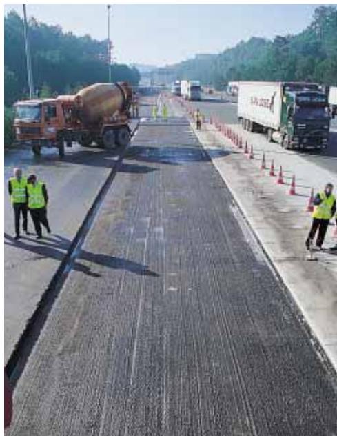
▲ Le fraisage de l'ancien enrobé sur une épaisseur moyenne de 9 cm est suivi d'un nettoyage soigné.
