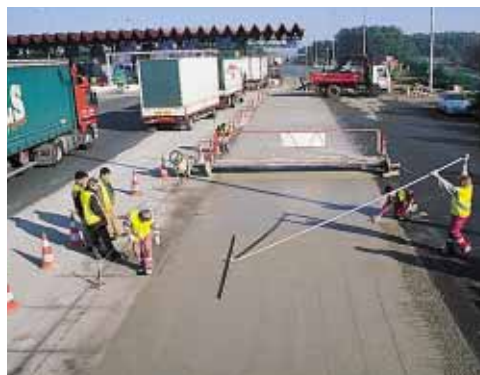
▲ Talochage après le passage de la machine.
