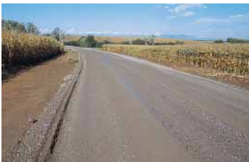
▲ Mise en œuvre du matériau d'apport constitué de granulats 0/20 recyclés épanchés sur une épaisseur de 15 cm.
