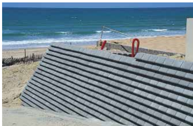
▲ La réalisation des accès à la plage à travers les dunes fait appel à des blocs béton spécifiques offrant une grande stabilité à l'ouvrage.
