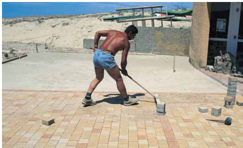
▲ Du sable est répandu en surface de façon à combler les joints. Les pavés seront ensuite damés pour conférer à l'aménagement une stabilité durable.
