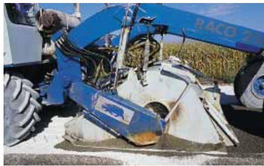
▲ Le malaxeur est équipé d'un rotor muni de dents au carbure de tungstène qui effectue un mélange intime des divers matériaux (chaussée existante, granulats d'apport recyclés, liant routier, eau) sur 30 cm d'épaisseur. L'alimentation en eau est assurée par une citerne montée dans la benne d'un camion poussé par le malaxeur.
