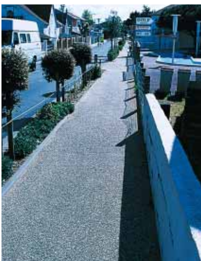
▲ La Faute-sur-Mer : le béton désactivé, réalisé avec un roulé Palvadeau, occupe les trottoirs de la longue rue qui mène à la plage.
