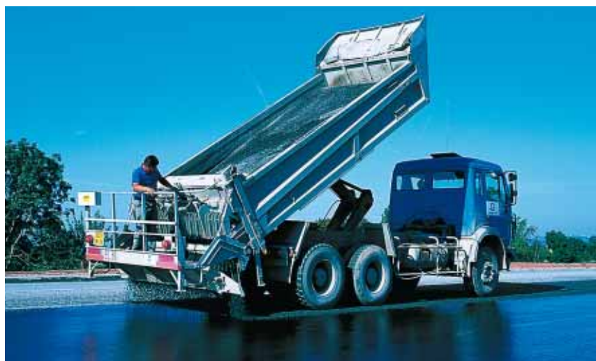
▲ Enduit de cure : émulsion et gravillons.
