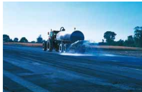
▲ L'arrosage de la couche de sable traité permet de compenser l'évaporation et ainsi de protéger la structure de la dessiccation.
