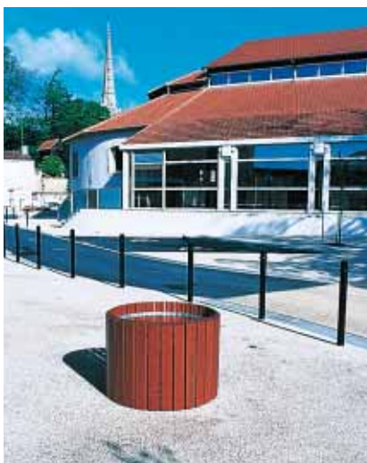
▲ Luçon : le béton désactivé a été mis en œuvre dans le cadre de la refonte totale du quartier des halles.
