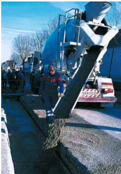
▲ Le BC Tranchées présente une grande fluidité qui lui permet de remplir les moindres cavités de la tranchée.
