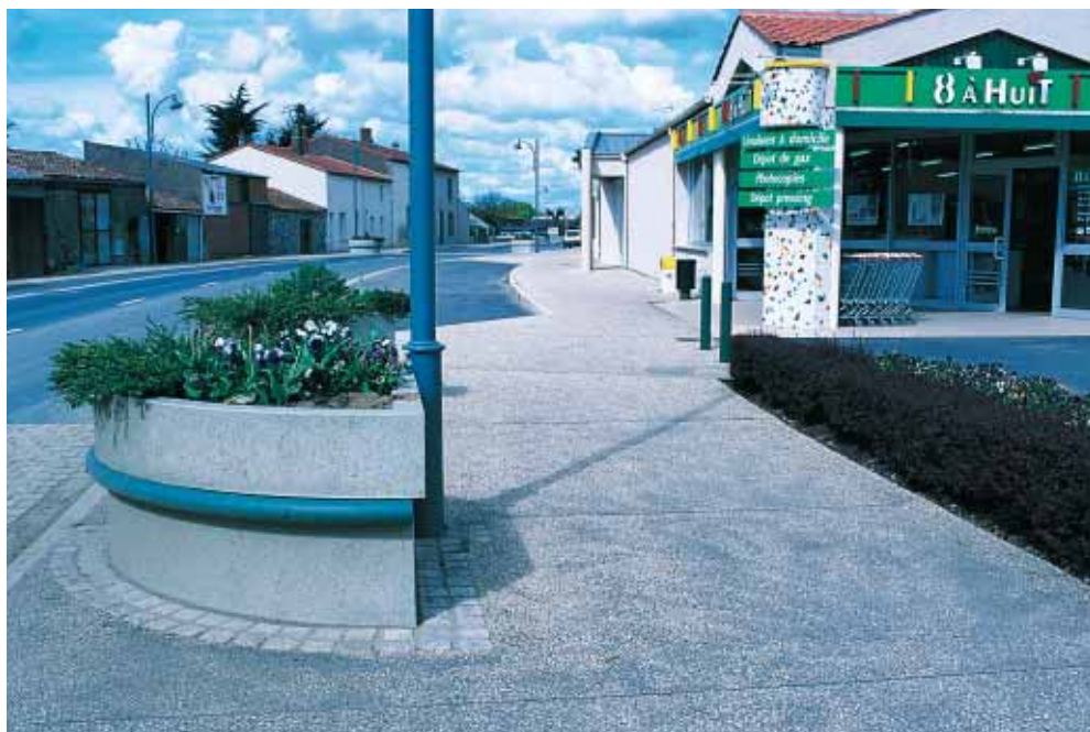
▲ Boufféré : 2 300 m 2 de béton désactivé ont été coulés pour la rénovation des trottoirs de l'avenue qui traverse la commune.
