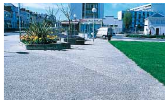
▲ Les Sables-d'Olonne : 3 000 m 2 de béton désactivé pour une esplanade piétonnière.
