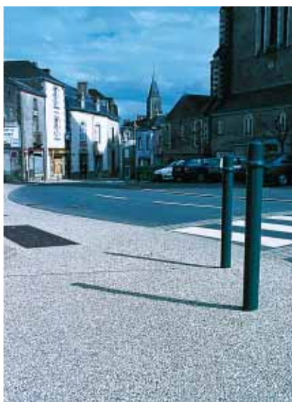
▲ Chavagne-en-Pailleurs : Le béton désactivé mis en œuvre dans la commune a servi à la réfection des trottoirs du centre-ville.
