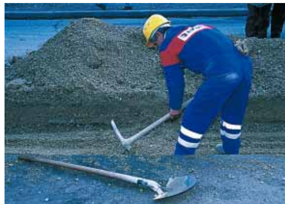
▲ Grâce à une formulation spécifique, le BC Tranchées peut être réexcavé à l'aide d'une pioche, sans effort, même après plusieurs années.
