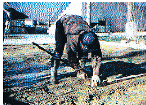
▲ Les joints de retrait-flexion en briques sont posés à même le béton fraîchement répandu, pour laisser libres le plus longtemps possible les cheminements.
