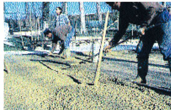
▲ Juste après la livraison, le béton est réparti à la pelle et au râteau.
