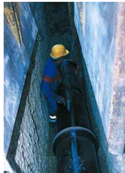
▲ Les canalisations qui reposent sur un lit de sable sont alignées au laser et emboîtées après avoir été encollées au niveau de la “tulipe”.
