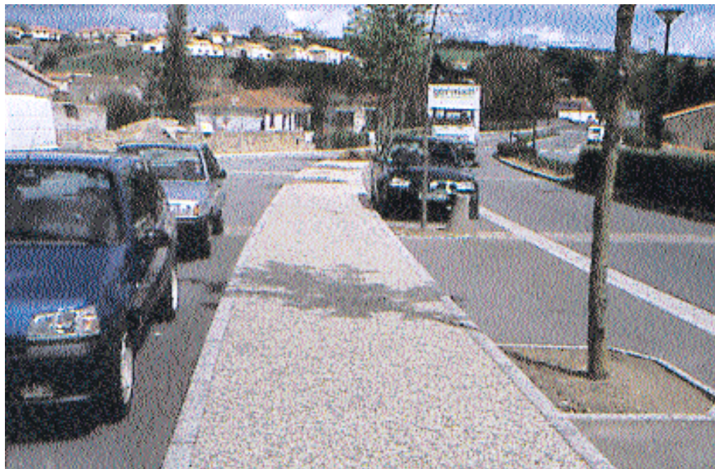
▲ Saint-Laurent-sur-Sèvre : plus de 4 000 m 2 de béton désactivé ont été réalisés.
