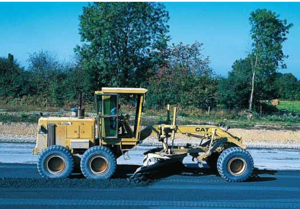
▲ La niveleuse règle l'altimétrie de la couche.
