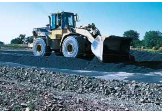
▲ Une chargeuse assure un préréglage du matériau.
