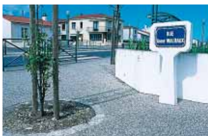
▲ Château-d'Olonne : les trottoirs ont également été réalisés en béton désactivé.
