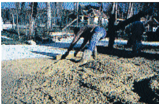
▲ Le béton est ensuite tiré à la règle.
