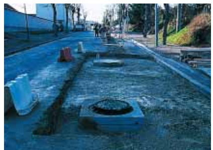
▲ Le BC Tranchées permet d'immobiliser les regards et autres ouvrages.
