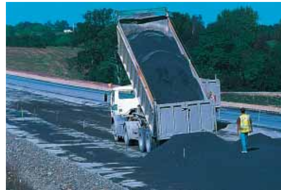
▲ Des camions-bennes déversent le sable traité sur le fond de forme.
