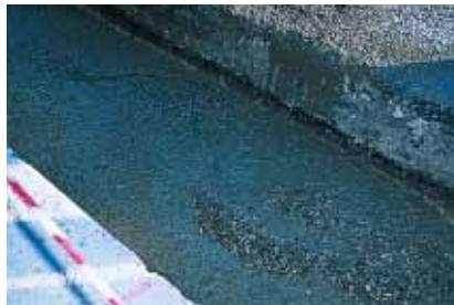
▲ Le BC Tranchées se répand uniformément dans la tranchée, limitant les opérations de réglage à un ratissage rapide. Les risques de décompression de la tranchée sont écartés du fait de la prise rapide du béton et d'un temps d'intervention réduit.
