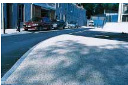
▲ Luçon : choisi comme alternative à l'enrobé, ce béton aux granulats d'un ton très clair égaye la place.
