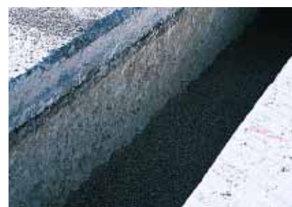
▲▼ Les conduites qui reposent au fond de la tranchée sont recouvertes de gravillons.
