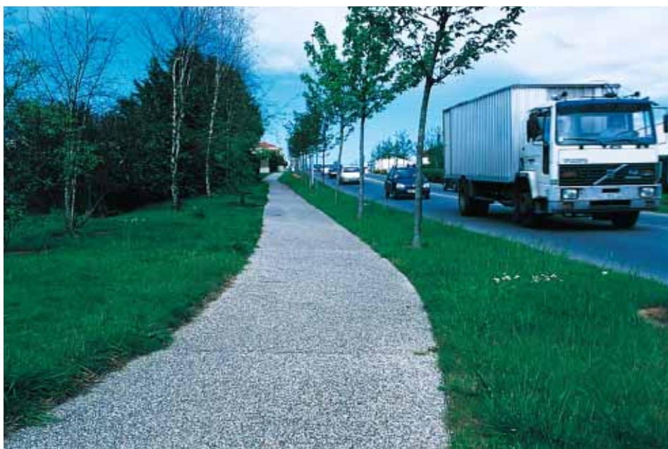
▲ Château-d'Olonne : séparée de la chaussée, la piste cyclable en béton désactivé offre une sécurité totale aux cyclistes.
