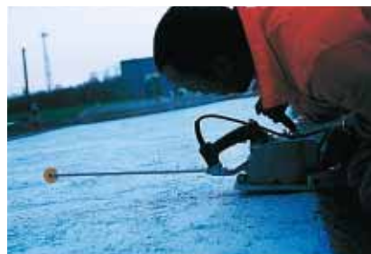
▲ L'opérateur s'apprête à réaliser le joint à l'aide d'une scie électrique de type "soft cut".
