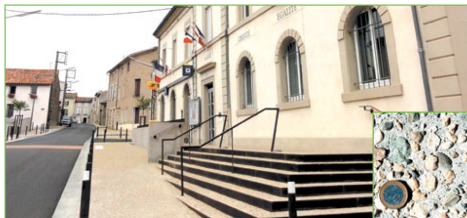
Peyriac-Minervois : deux matériaux ont été utilisés pour différencier les espaces et les utilisations : l'enrobé pour les parties circulées en voiture, le béton désactivé pour les voies piétonnes.
