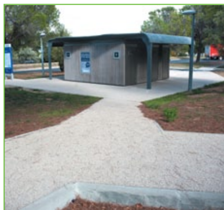
ASF : les cheminements en béton conduisent vers les sanitaires par des rampes permettant l'accès aux fauteuils roulants.
