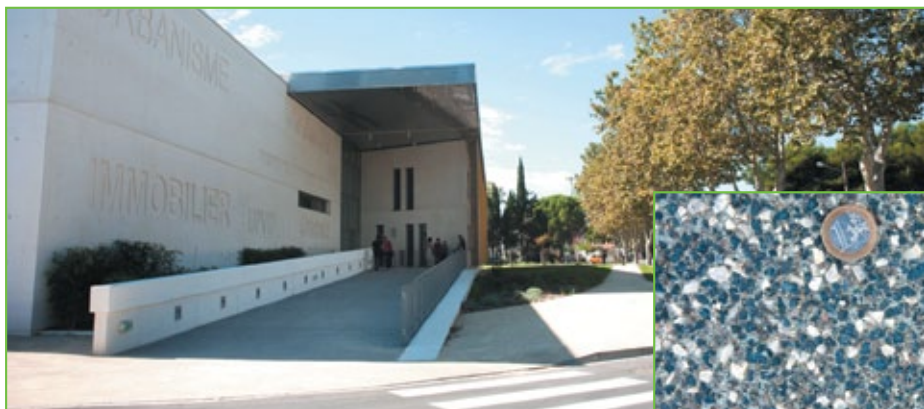
IUP Narbonne : le béton désactivé de la rampe a été formulé avec 40% de granulats basalte gris foncé et 60% de granulats clairs de Murles.
