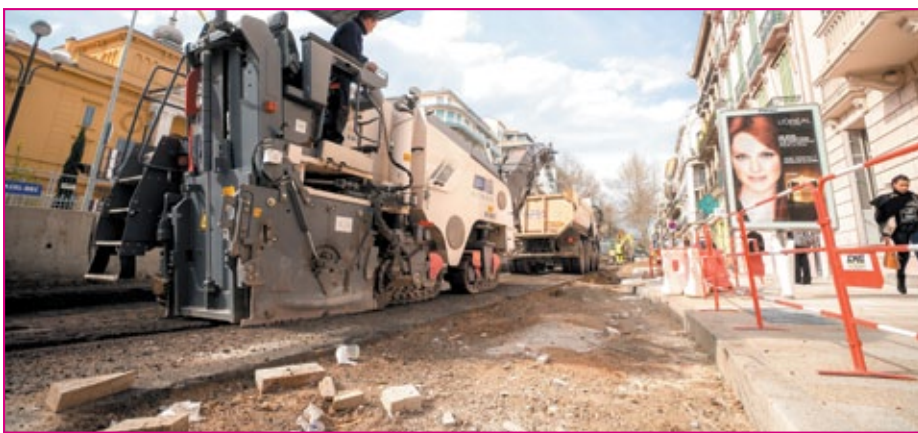
Cannes : le rotabage de l'enrobé ornieré a été réalisé sur 10 cm d'épaisseur, avant le coulage d'une épaisseur identique de BCMC sur une structure grave bitume de 13 cm.
