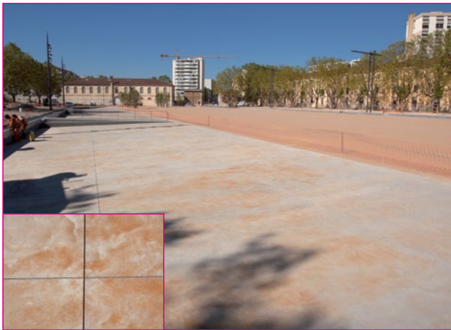
Parc du Sergent Blandan : l'aspect rouillé s'obtient grâce à l'oxydation de fines particules métalliques incorporées à la surface du béton.
