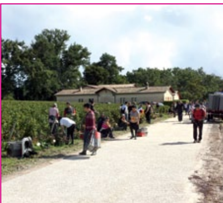
Château Haut-Bailly : l'allée conduisant au bâtiment technique a été traitée en béton désactivé broissé.
