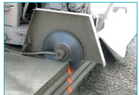
Le sciage du béton a lieu tous les 5 m. Le bord latéral de la bande primaire est ondulé pour améliorer le raccordement avec la bande secondaire.
