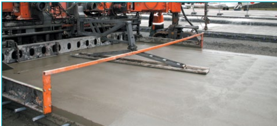
Lissage automatisé à l'arrière de la machine à coffrage glissant.
