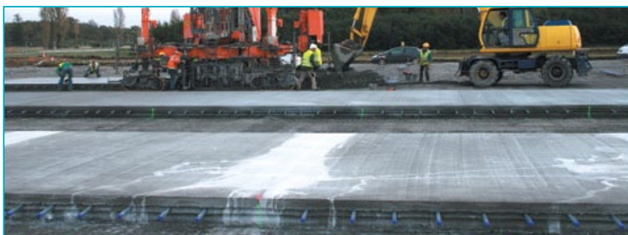
Réalisation en bandes alternées primaires puis secondaires, avec pose de goujons latéraux entre les deux.
