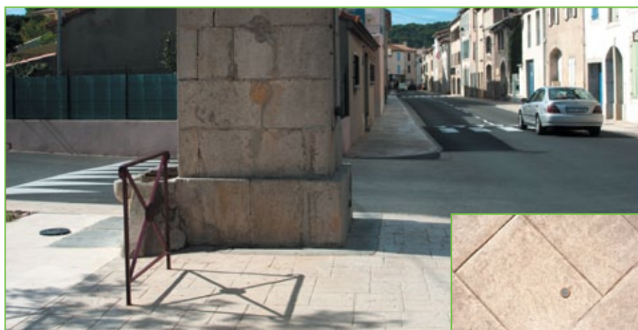
Gruissan : le béton imprimé a été choisi car il permet de retrouver l'effet de dallage de la pierre, la durabilité en plus.
