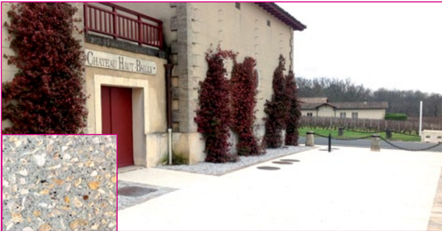
Château Haut-Bailly : devant l'entrée du chai, le béton désactivé est facile d'entretien, durable, esthétique et la technique utilisée est à « zéro rejet ».
