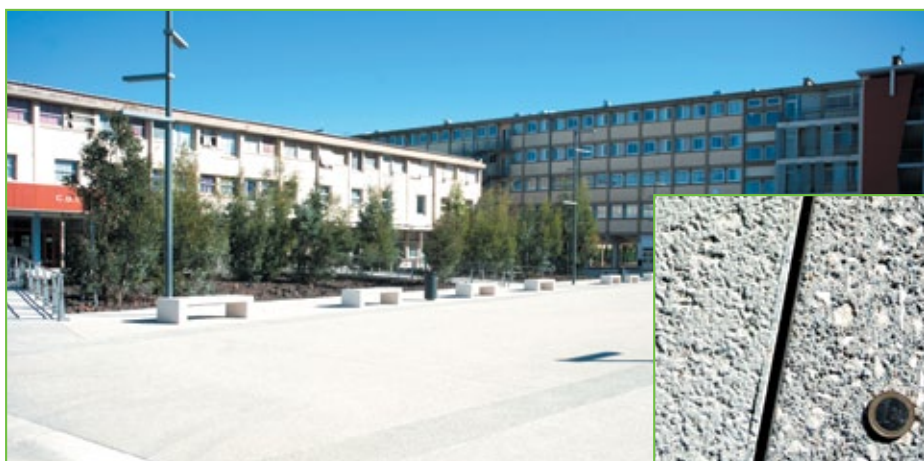
Narbonne : sur le parvis du lycée Eiffel-Diderot, les architectes ont choisi deux granulométries différentes (2/16 et 6/16) pour jouer sur un effet grains de riz au sol.
