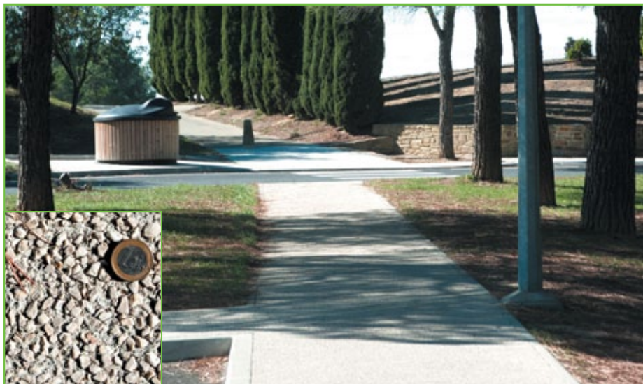
ASF : les teintes claires du béton désactivé, entre gris et blanc, sont proches de celles des pierres calcaires de la région, lui faisant jouer un rôle esthétique et technique.
