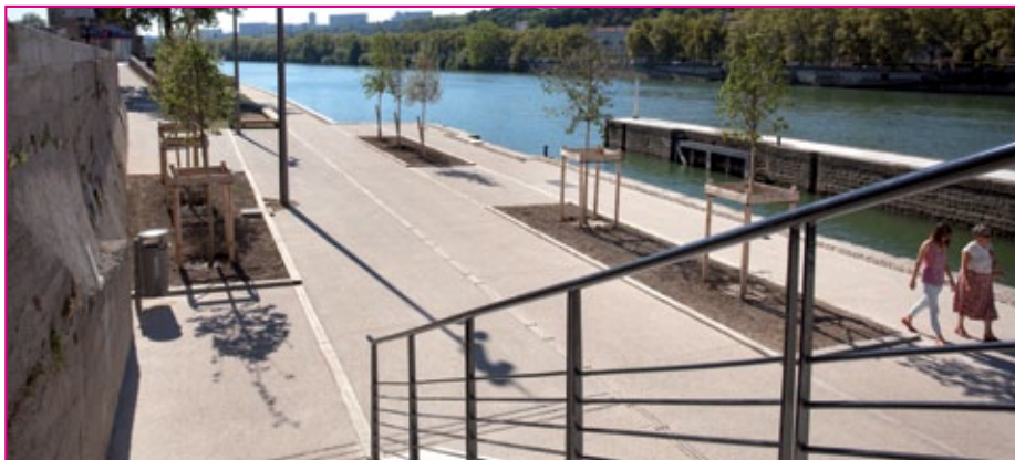
Rives de Saône : le cheminement en béton bouchardé longe l'ancienne écluse de Caluire. Sa formulation XF2 est bien adaptée aux zones potentiellement submersibles.
