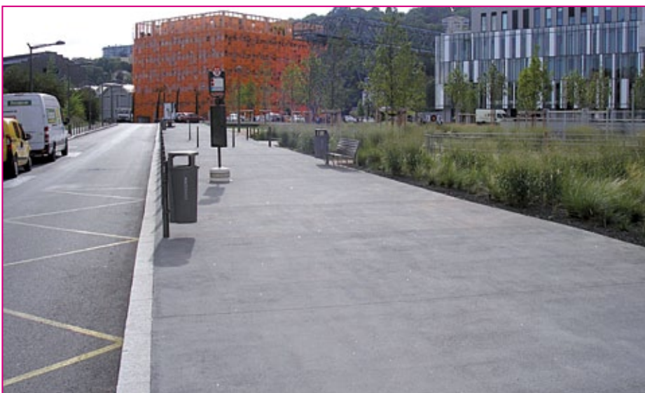
Lyon Confluence : la surface du béton a été légèrement sablée pour lui conférer sa texture finale, lui éviter d'être glissante les jours de pluie et offrir l'aspect esthétique recherché.
