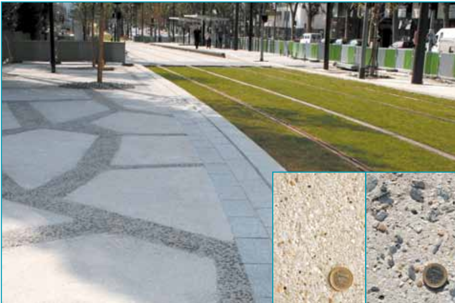
Les abords des stations sont réalisés au moyen de deux bétons désactivés différents, afin d'obtenir une opposition de teintes : l'une claire, l'autre foncée.
