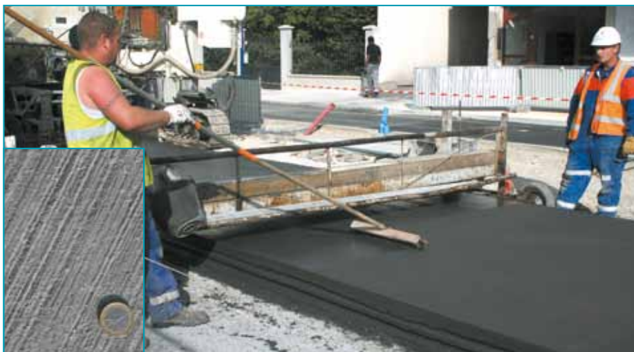
Le balayage de la surface de la couche de roulement vise à améliorer l'adhérence des pneus du tramway, notamment pour les jours pluvieux et dans les zones en pente.
