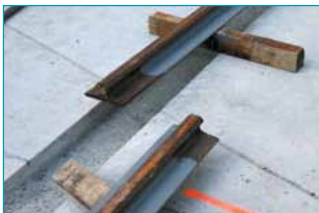
À gauche : après la prise du béton et pour accueillir le rail de guidage, on crée une engravure par sciage et fraisage de la plateforme. À droite : on vérifie ensuite la bonne implantation du rail. Les boîtes à eau, placées de chaque côté de celui-ci, serviront à collecter les eaux pluviales.
