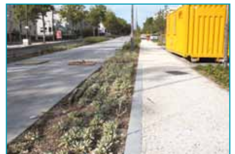
Une piste pour piétons et vélos, réalisée en béton désactivé clair, longe la ligne de tramway et relie les stations entre elles.
