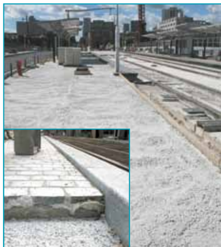
Les abords des stations ont d'abord été coulés avec un béton C30/37 sur lequel ont été posées des dalles en granit.
