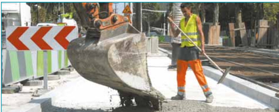
L'approvisionnement en béton prêt à l'emploi destiné aux quais des stations a été effectué au moyen d'un camion-malaxeur et d'une pelle mécanique.
