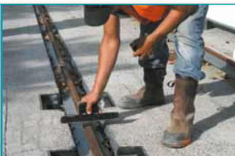
À gauche : après la prise du béton et pour accueillir le rail de guidage, on crée une engravure par sciage et fraisage de la plateforme. À droite : on vérifie ensuite la bonne implantation du rail. Les boîtes à eau, placées de chaque côté de celui-ci, serviront à collecter les eaux pluviales.
