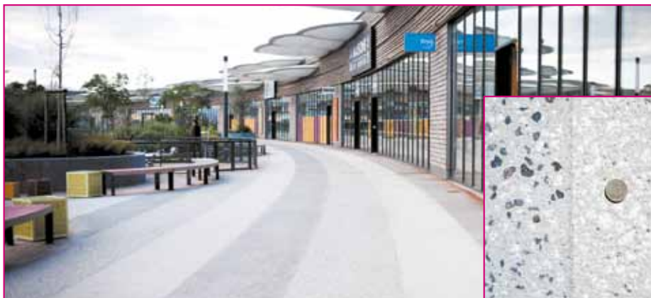
Le parvis se présente sous forme de larges bandes de béton bouchardé dont les teintes différentes ont été obtenues en jouant sur la proportion des granulats clairs 6/16 de Murle et des granulats foncés 6/10 de basalte.
