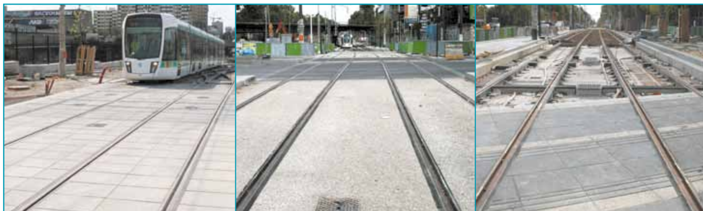
Le choix de différents matériaux caractérise le parcours du T3. Dans les stations et au niveau des traversées piétonnes, on trouve des dalles et pavés en granit (à gauche). Dans les carrefours classiques, du béton désactivé (au centre). Dans les carrefours stratégiques, des dalles préfabriquées en béton (à droite).
