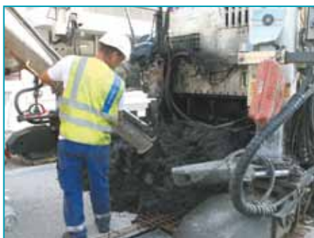
Le béton prêt à l'emploi fourni est un béton coloré en noir à 3% comportant des granulats de porphyre, choisis pour leur grande résistance à l'usure.
