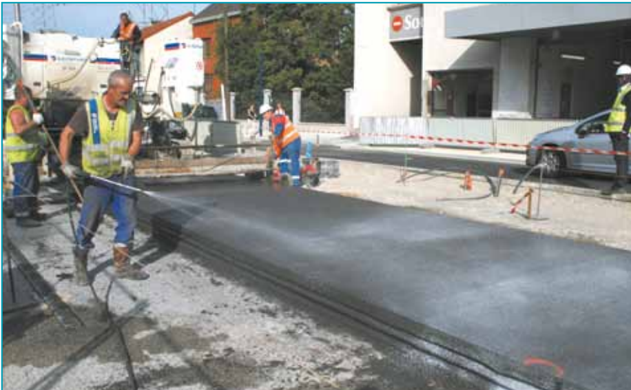
Une double pulvérisation de produit de cure est effectuée juste après le passage de la machine à coffrage glissant.
