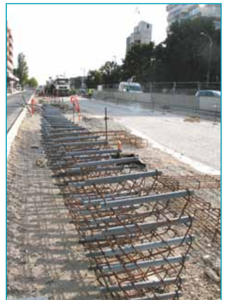
Les paniers porte-goujons prêts à être posés, en moyenne tous les 5 mètres, dans le sens longitudinal de la couche de roulement en BC5.
