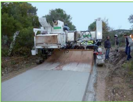
La Croix-Valmer : le passage d'une toile de jute sur le béton frais donne une texture de surface légèrement micro-rugueuse comme du papier de verre.
