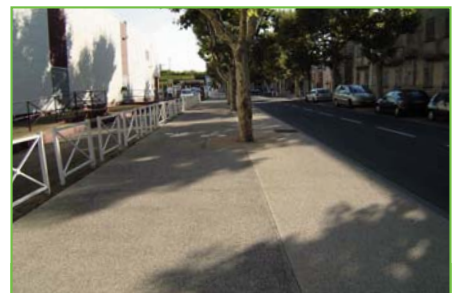
Port-Saint-Louis-du-Rhône : le rétrécissement de la chaussée a permis de créer une voie piétonne beige de 1,80 m et une piste cyclable grise de 2,50 m, les deux étant séparées par une allée de platanes.
