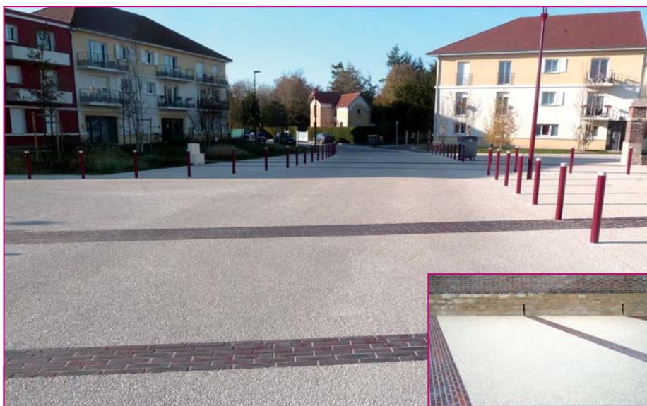
Granulats clairs de comblanchien et briques en terre cuite valorisent esthétiquement le nouveau centre-bourg de Saint-Germain. Rejoignant le mur du cimetière, les lignes de briques jouent un double rôle pratique : lors du coulage du béton, elles servent de coffrage, puis de joints de dilatation.
