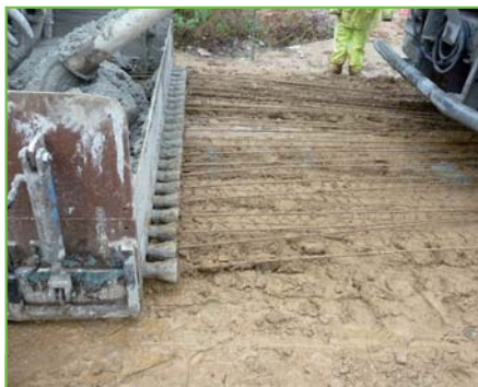
La Croix-Valmer : pour la partie de la piste réalisée à la machine, les 22 aciers filants HA12 soudés sont positionnés à la fibre neutre de la dalle, à l'aide d'un système de trompettes.
