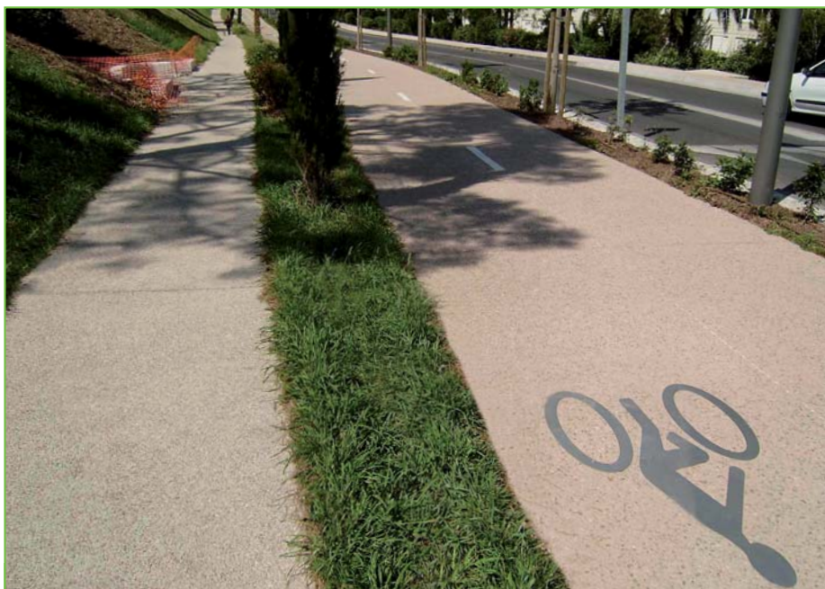
Marseille : de couleur ocre, la piste cyclable fait 3 m de large alors que le trottoir de 1,50 m de teinte naturelle est traité comme une promenade indépendante de la voie.
