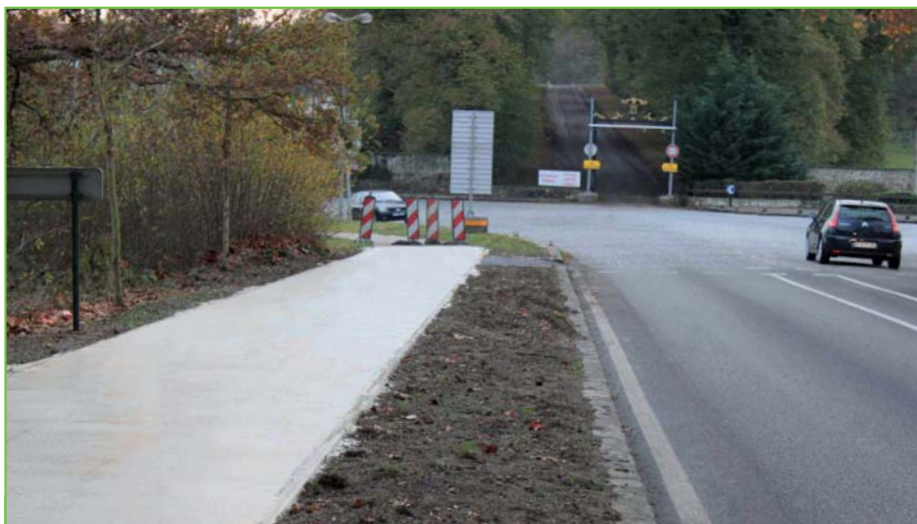
Rambouillet : la piste cyclable est séparée de la RD 937 par une bande de 1 m de large.
