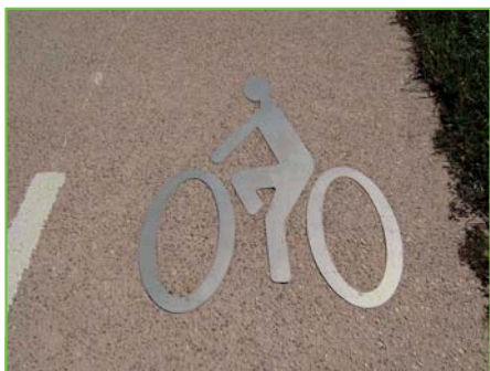
Marseille : intégrés dans le béton, douze inserts en acier inoxydable figurent des logos de cycliste pour marquer les sens de circulation et identifier la piste.
