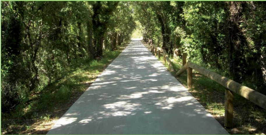
La Croix-Valmer : pour protéger l'environnement, l'Architecte des Bâtiments de France ne souhaitait pas l'utilisation de produits hydrocarbonés pour la piste cyclable.
