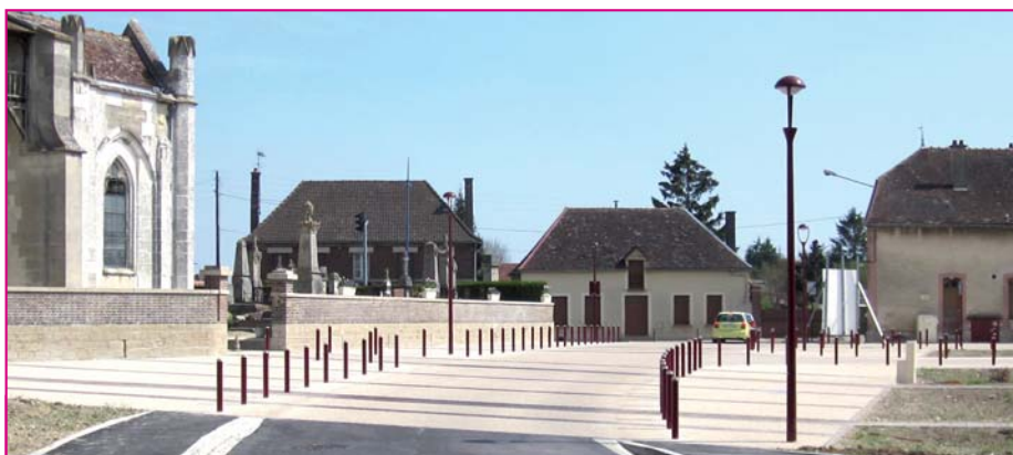
La teinte claire du béton désactivé souligne l'aspect centre-bourg de Saint-Germain et tranche avec la couleur noire de l'enrobé de la route départementale, ce qui incite fortement les automobilistes à ralentir.
