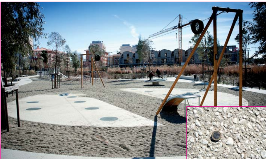
Le chantier a nécessité le recours à l'hydrosablage pour éviter la poussière et une présence permanente pour que les enfants n'aillent pas jouer dans le béton frais.
