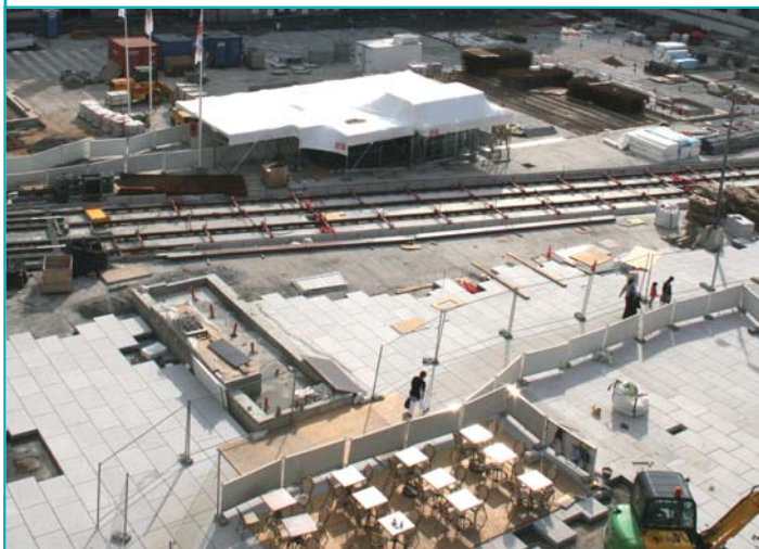
Place du Ralliement : à gauche, vue aérienne de l'implantation du chantier et, à droite, la réalisation terminée avec des dalles en béton, granit, schiste et quartzite sur le parvis, ainsi que des pavés entre les rails.
