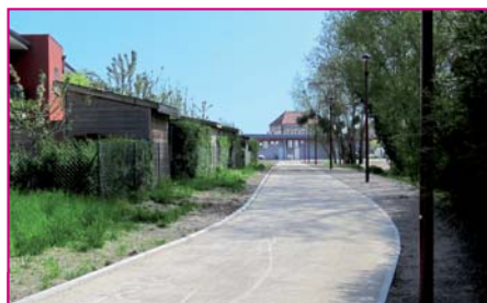
Pour rappeler l'aspect des chemins ruraux, les pistes cyclables sont en sable stabilisé au liant hydraulique.
