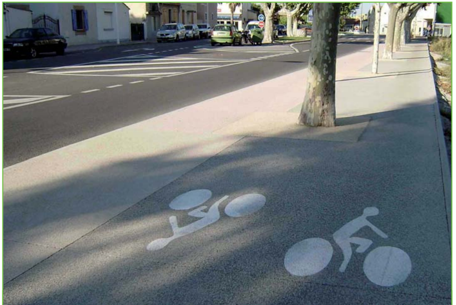
Port-Saint-Louis-du-Rhône : tous les pieds de platanes ont été traités en béton poreux de 2 m de côté avec des granulats identiques à ceux du béton désactivé.
