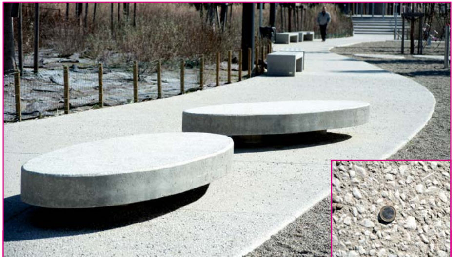
Les tables ovales en béton ont été coffrées et coulées in situ : la formulation de leur béton est la même que celle du béton sablé du sol sur lequel ils reposent.
