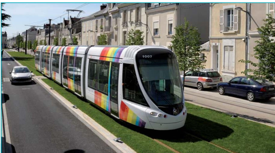
Sur les 12,3 km de la ligne, la priorité a été donnée au végétal avec 8 km de plate-forme engazonnée.
