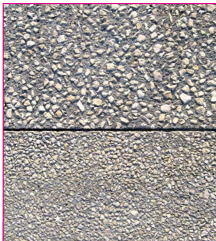
Différences d'aspects entre béton sablé gros granulats (en haut) et béton sablé granulats fins (en bas).
