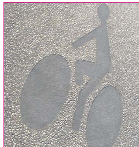
La technique du pochoir permet de dessiner en relief la signalétique de la partie cyclable, évitant ainsi l'emploi d'une peinture de sol.
