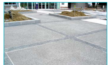
Le quadrillage a été réalisé au moyen de deux bétons désactivés clair et foncé.
