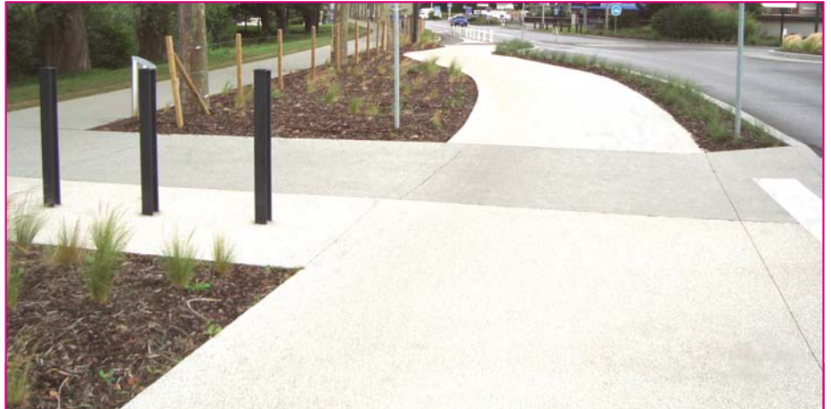
Les traversées piétonnes, bien différenciées de la piste cyclable, sont signalées par un changement de rugosité et d'aspect du béton.
