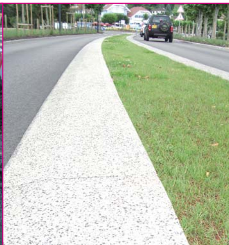
À gauche, les deux bordures larges et surbaissées en béton sablé, en cours de réalisation. À droite, le terre-plein central terminé, après engazonnement et plantation de miscanthus.
