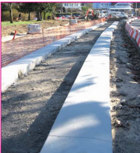
À gauche, les deux bordures larges et surbaissées en béton sablé, en cours de réalisation. À droite, le terre-plein central terminé, après engazonnement et plantation de miscanthus.
