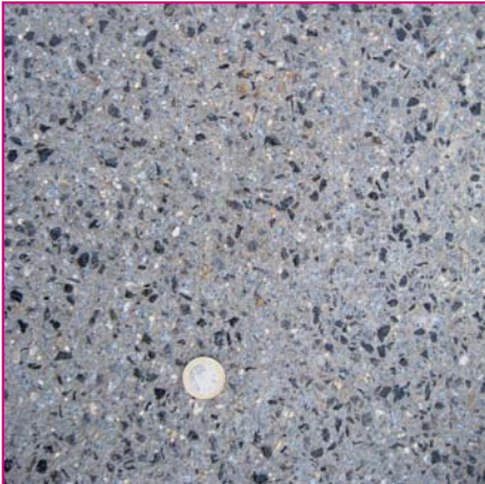
Le béton noir, aux granulats de basalte, assure la séparation entre la voie verte et la chaussée automobile.
