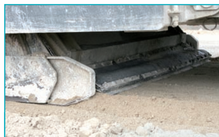
Détail de la phase de malaxage.
