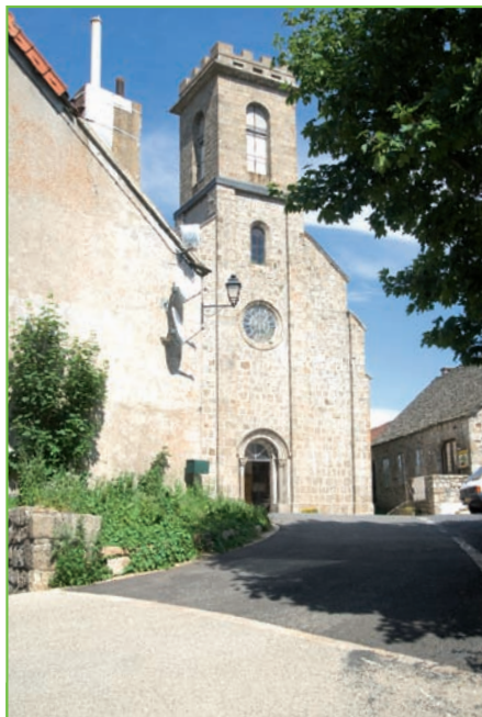
Sagnes-et-Goudoulet : le béton désactivé rappelle parfaitement la pierre naturelle de l'église de style roman.
