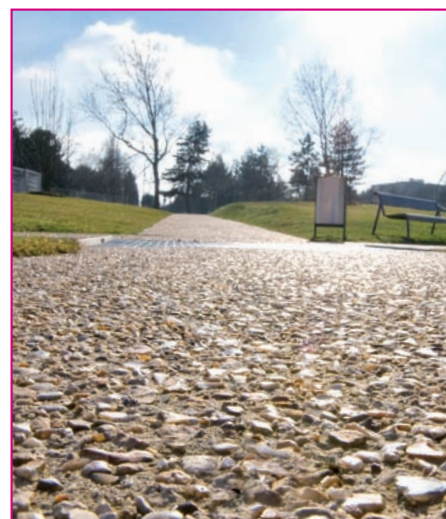
Gros plan sur le béton désactivé des allées, dosé à 330 kg de ciment et enrichi de fibres en polypropylène.
