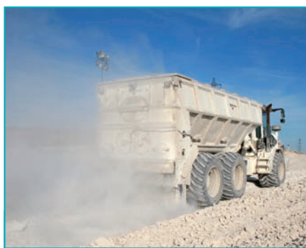
Traitement de la partie supérieure de terrassement à raison de 4 % de LHR.
