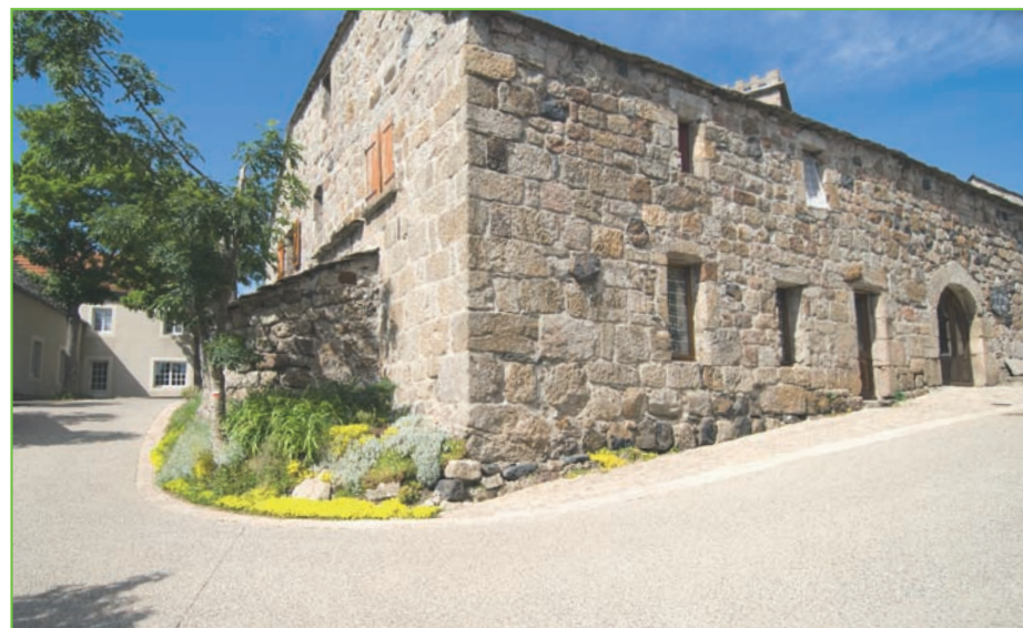
Sagnes-et-Goudoulet : perché à plus de 1200 mètres d'altitude, le village a choisi le béton désactivé pour moderniser toute sa voirie. La couleur des granulats s'harmonise avec celle des façades de ce village de 140 habitants.
