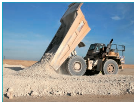
Déchargement de matériaux pour la partie supérieure de terrassement.
