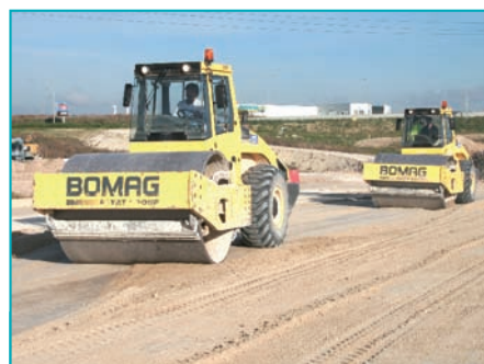
Compactage des 35 cm de la partie supérieure de terrassement.
