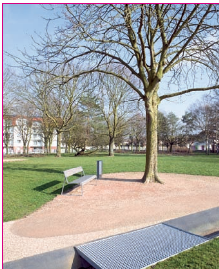
Les placettes, en forme de pétale, sont en sol stabilisé au ciment.
