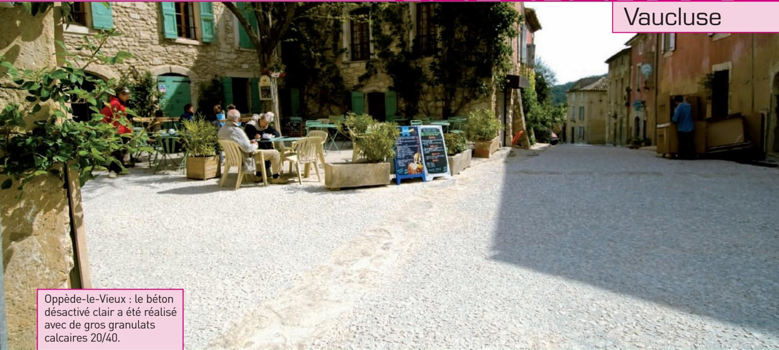
Oppède-le-Vieux : le béton désactivé clair a été réalisé avec de gros granulats calcaires 20/40.
