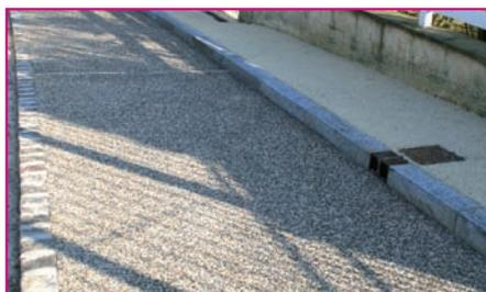
Sur cette commune située au bord de l'Oise à 6 km de Compiègne, Eurovia Picardie a mis en œuvre 200 m<sup>3</sup> sur deux réalisations : un trottoir en béton stabilisé, teinté jaune ocre dans la masse et des places de parking en béton désactivé Haute-Marne, sans colorant, avec granulats 6/20 La Frette et fibres en polypropylène.
