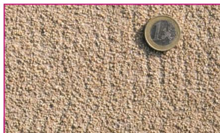
Choisy-au-Bac : gros plan sur le béton stabilisé de la piste cyclable.
