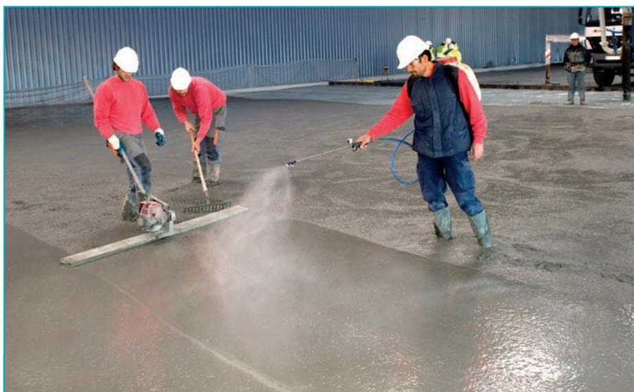
Passage de la règle vibrante et pulvérisation d'un produit de cure.
