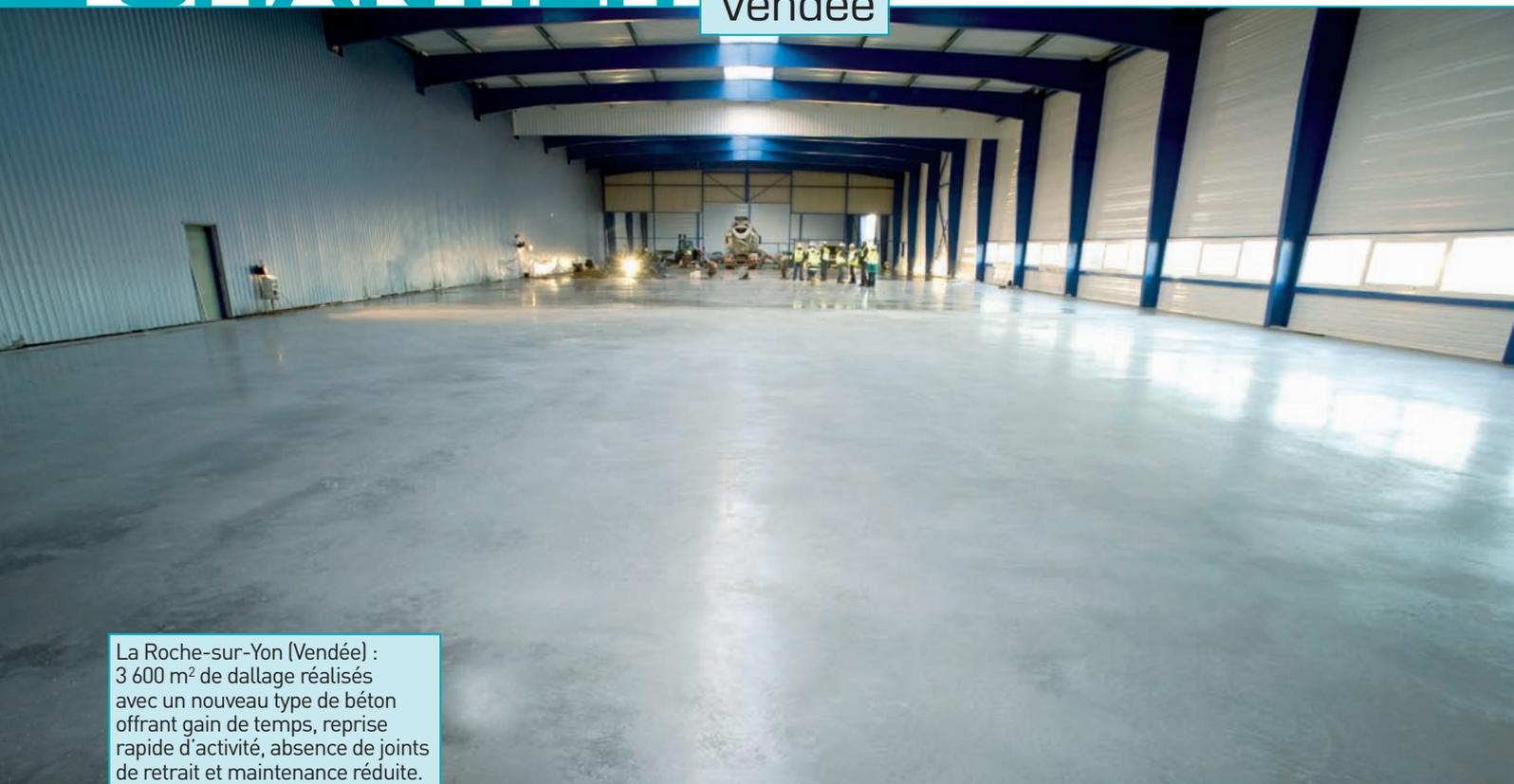
La Roche-sur-Yon (Vendée) : 3 600 m<sup>2</sup> de dallage réalisés avec un nouveau type de béton offrant gain de temps, reprise rapide d'activité, absence de joints de retrait et maintenance réduite.
