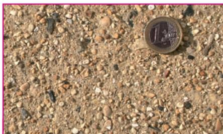
Le Meux : gros plan sur le béton désactivé des places de parking.
