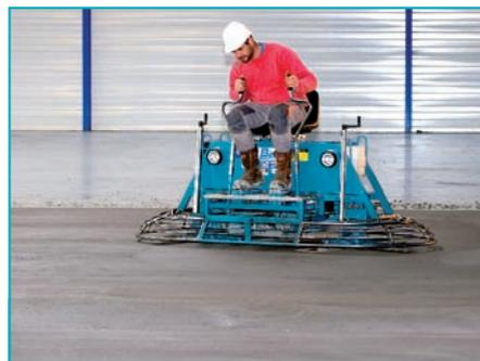
Opération de lissage du béton, permettant d'obtenir un effet miroir.
