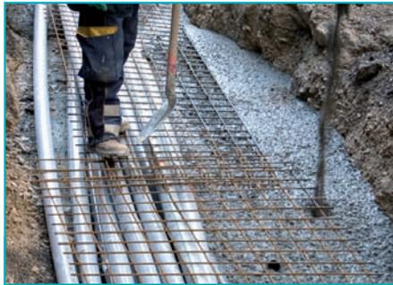
Afin d'enfourer les câbles, 400 m<sup>3</sup> de béton fluide à prise rapide ont été coulés.
