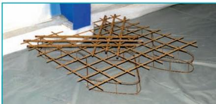
Mise en place d'une bande de désolidarisation périphérique, pose d'un polyane et renfort en pied de poteau.
