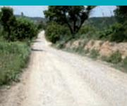
Plan-de-la-Tour : des chemins communaux retraités au liant hydraulique routier sans couche de roulement
