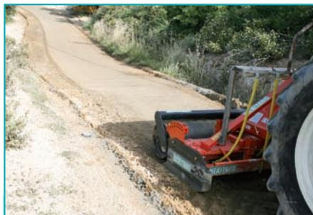
Le compactage termine la mise en œuvre des matériaux traités en place.
