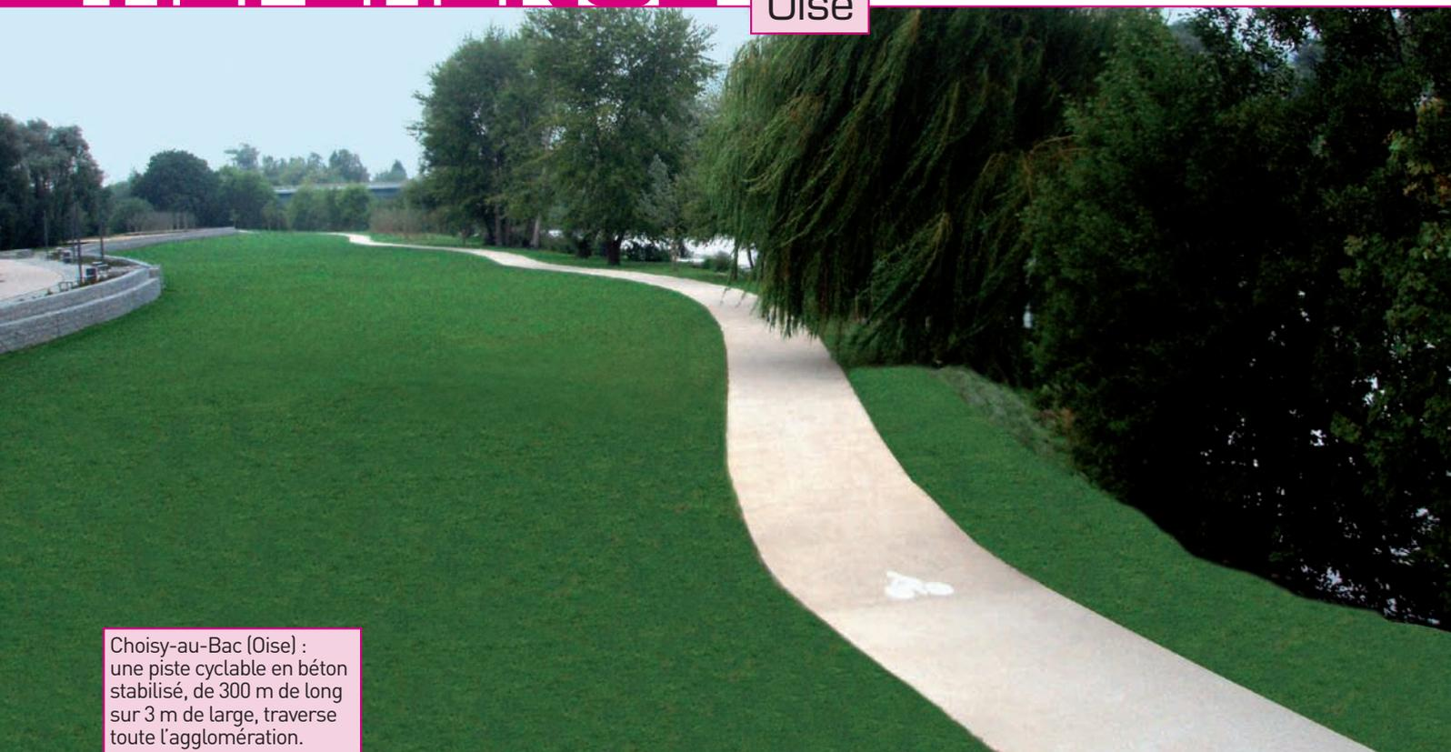
Choisy-au-Bac (Oise) : une piste cyclable en béton stabilisé, de 300 m de long sur 3 m de large, traverse toute l'agglomération.
