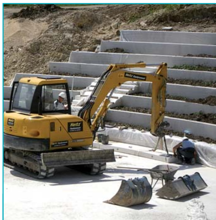
Mise en place des dalles béton préfabriquées des gradins de l'amphithéâtre.
