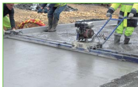
La règle vibrante prend appui sur les coffrages et les bordures.
