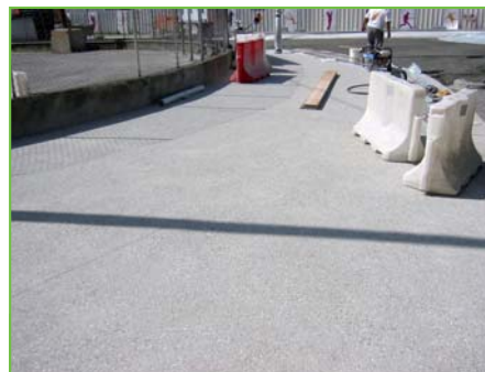
Sablées en même temps que les trottoirs, les bordures sont quasi invisibles.
