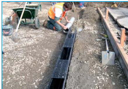
Un caniveau de 4 m de long collecte les eaux de la dalle et les évacue vers le séparateur, via un tuyau PVC.
