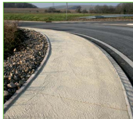
Beauvais Site : RD 927 (sud-ouest) Type : Modification carrefour existant Surface : 23 m 2 - Finition : béton lissé
