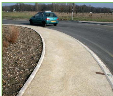
Auneuil Site : RD 981 Type : Modification carrefour existant Surface : 23 m 2 - Finition : béton taloché
