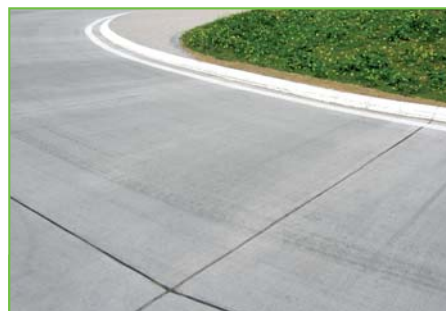
Le découpage du béton en figures carrées de 5 mètres de côté évite les angles vifs fragiles.
