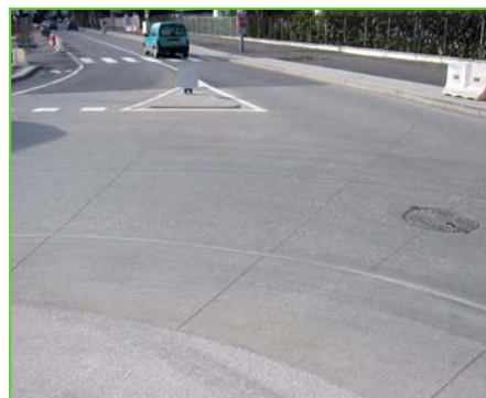
Le calepinage des joints de la chaussée dessine une sorte de toile d'araignée.
