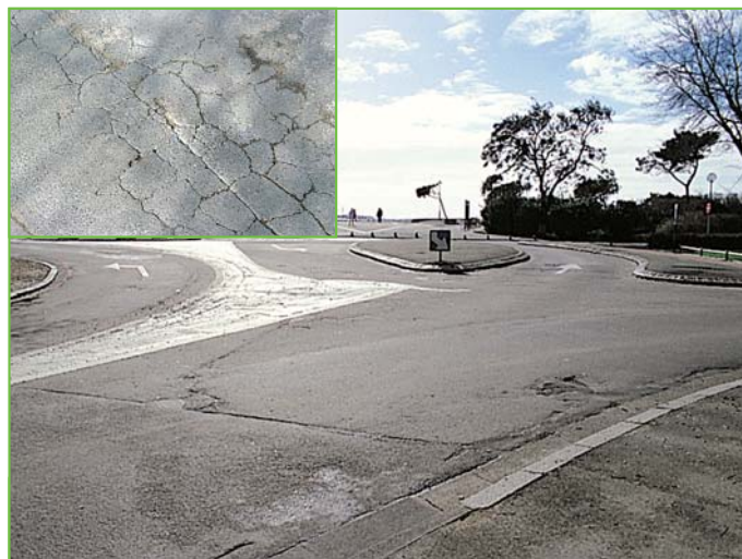
Dégradations structurales observées sur les carrefours giratoires : faïencage et orniérage des couches de surface.
