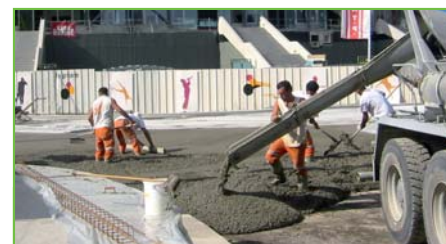
Déversé directement du camion-toupie, le béton a été coulé le matin.
