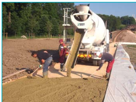
Coulage du béton désactivé ocre le long des couronnements du bassin.
