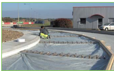
Après mise en place du polyane, les goujons fixés sur leurs paniers sont posés à l'emplacement des futurs joints.
