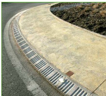
Ressons-sur-Matz Site : RD 82 - Type : Modification carrefour existant - Surface : 25 m 2 Finition : béton taloché
