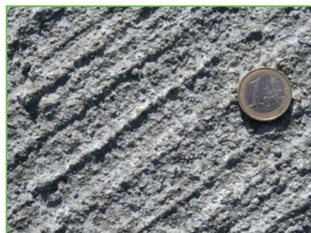
Le béton balayé donne sa texture anti-dérapante à la couche de roulement.
