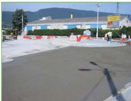
Chaque jour est réalisée une demi-chaussée du giratoire.
