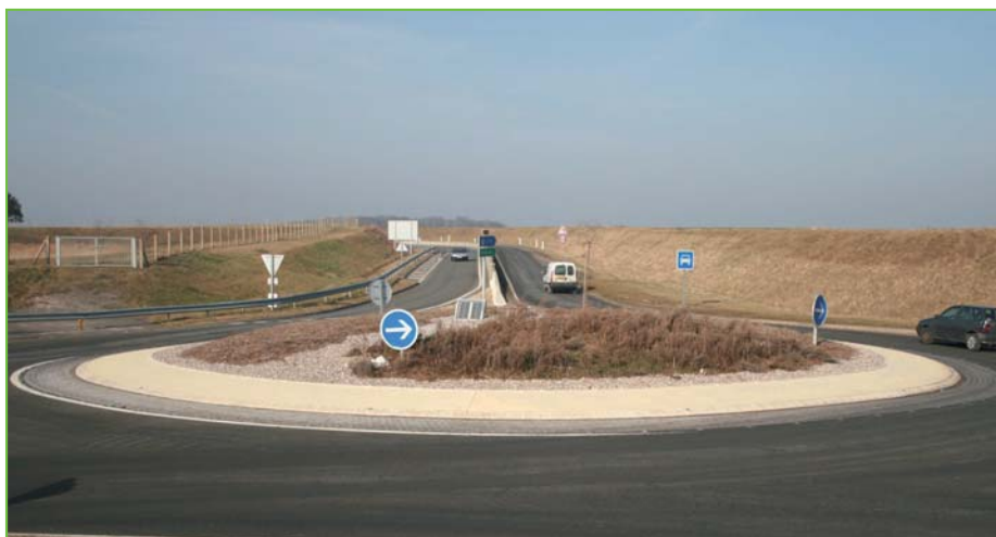
Therdonne - Site : RD 12 - Type : Modification carrefour existant Surface : 23 m 2 - Finition : béton taloché
