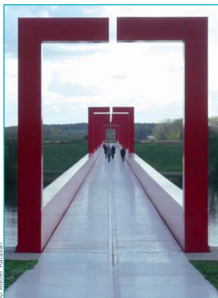
Le passage piétonnier de la passerelle métallique qui surplombe le bassin est réalisé en dalles de béton blanc de 3,60 m sur 1,80 m et de 20 cm d'épaisseur.
