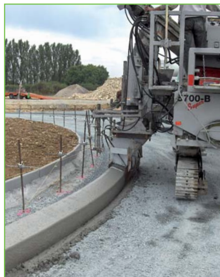
Les bordures sont réalisées en place avec une machine à coffrage glissant.
