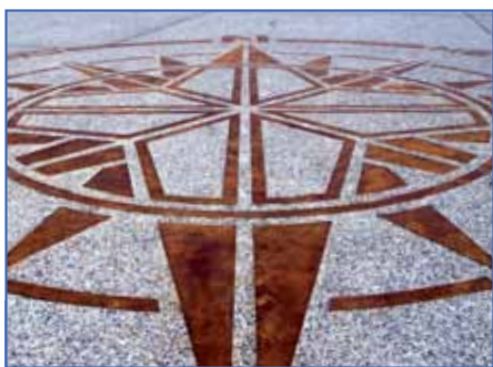
Le béton désactivé permet l'incrustation de motifs, comme cette rose des vents métallique intégrée dans le quai.
