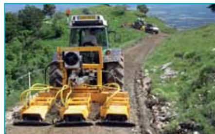
Phase de compactage avec une plaque vibrante montée sur tracteur.
