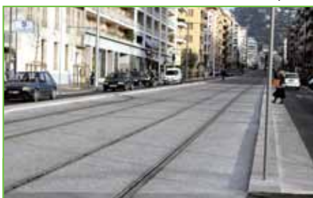
Le béton désactivé s'intègre parfaitement dans le cadre urbain de Nice.
