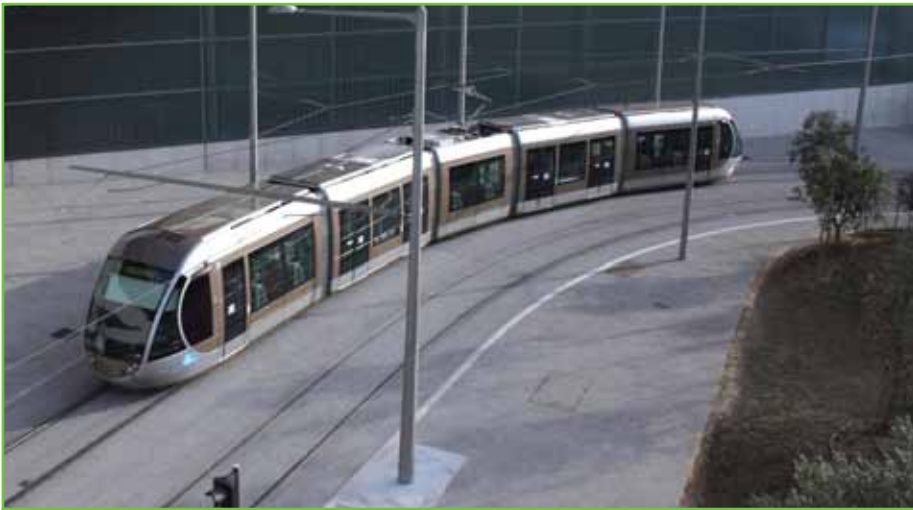
En tête de ligne, le béton désactivé habille plate-forme et trottoirs.
