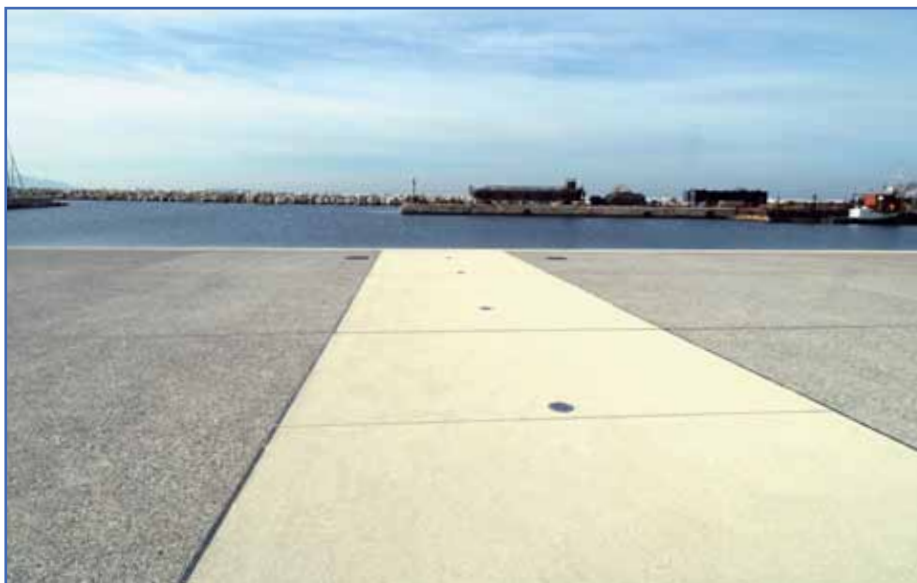
Le quai de l'Estaque, réalisé au moyen d'une combinaison entre béton désactivé et béton bouchardé, a permis aux habitants de renouer directement avec la mer.
