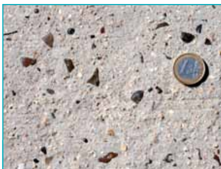
Le balayage superficiel du béton lui donne sa texture anti-glissance.
