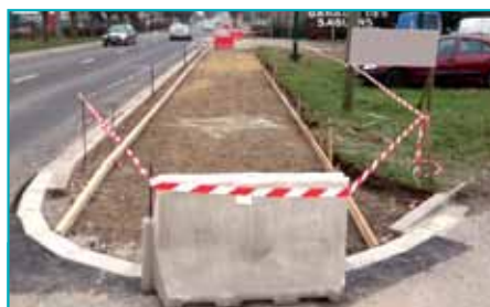
Le trottoir a été préalablement décaissé en début de chantier.
