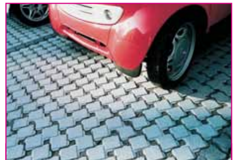
Les places de parking sont clairement délimitées par les pavés béton.
