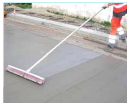
Après talochage, le béton frais a été strié transversalement au balai.
