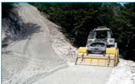
Malaxage ciment/rocher concassé sur environ 15 cm de profondeur.
