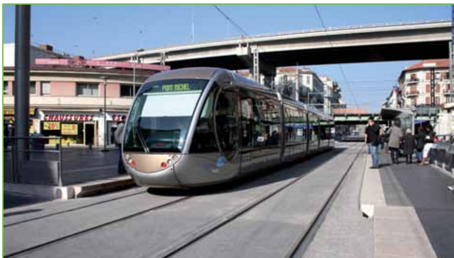
Robustesse oblige : la plate-forme du tramway et la couche de fondation des quais sont toutes les deux réalisées en béton.
