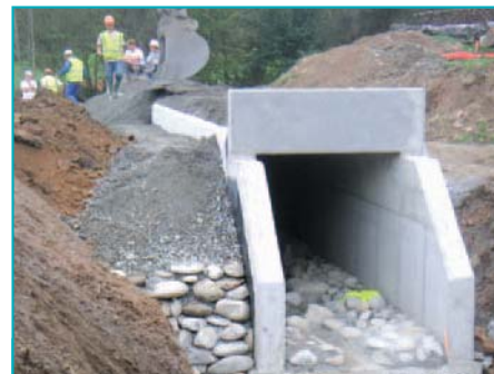
Aménagement intérieur de l'ouvrage hydraulique avec des galets.
