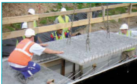
Pose des éléments préfabriqués en béton, à l'aide d'un engin de levage loué.
