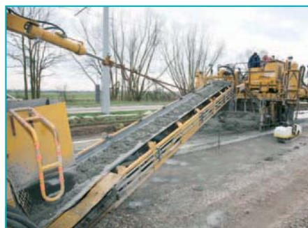
Alimentation en béton, par tapis, à l'avant de la machine à coffrage glissant.
