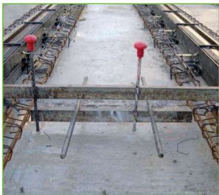
Les rails posés et fixés, les ferrailages sont alors mis en place.
