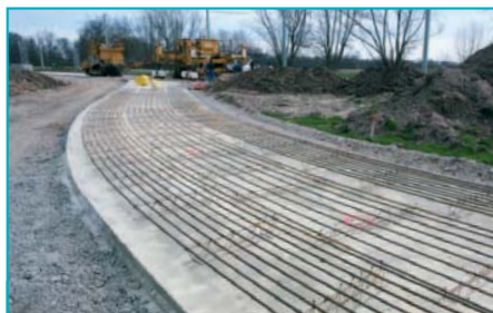
Une fois la couche de fondation réalisée, les fers continus sont disposés sur le BAC selon un espacement régulier.
