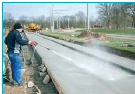
Pulvérisation sur le béton armé continu d’un produit de cure anti-dessiccation.
