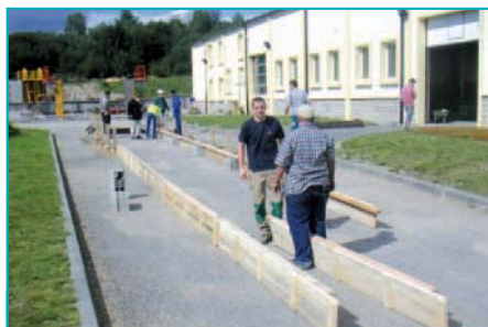
Montage à blanc du coffrage du radier.
