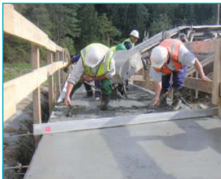
Bétonnage de la traverse supérieure.
