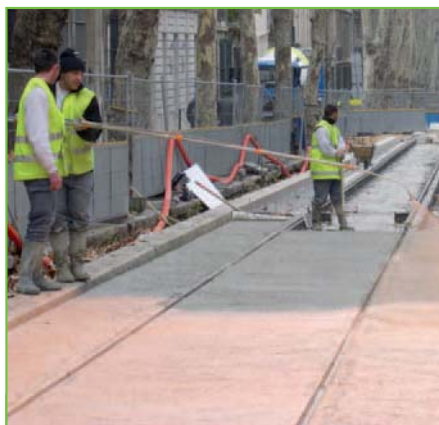
Le désactivant est appliqué sur la dalle dès qu'elle a été tirée.
