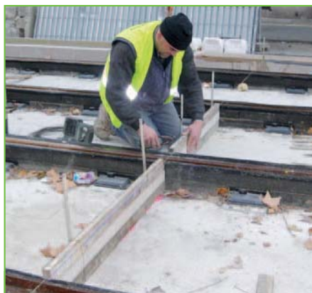
Les coffrages sont mis en place directement entre les rails, afin de délimiter la portion de dalle à couler.
