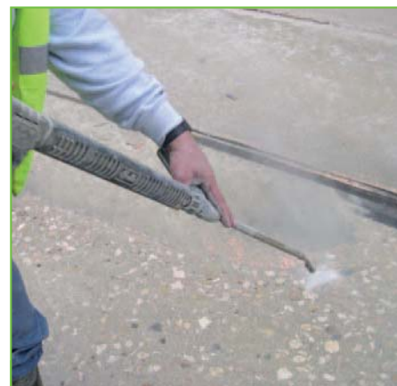
Une fois la prise réalisée, le béton est lavé au jet à haute pression pour faire apparaître les granulats.
